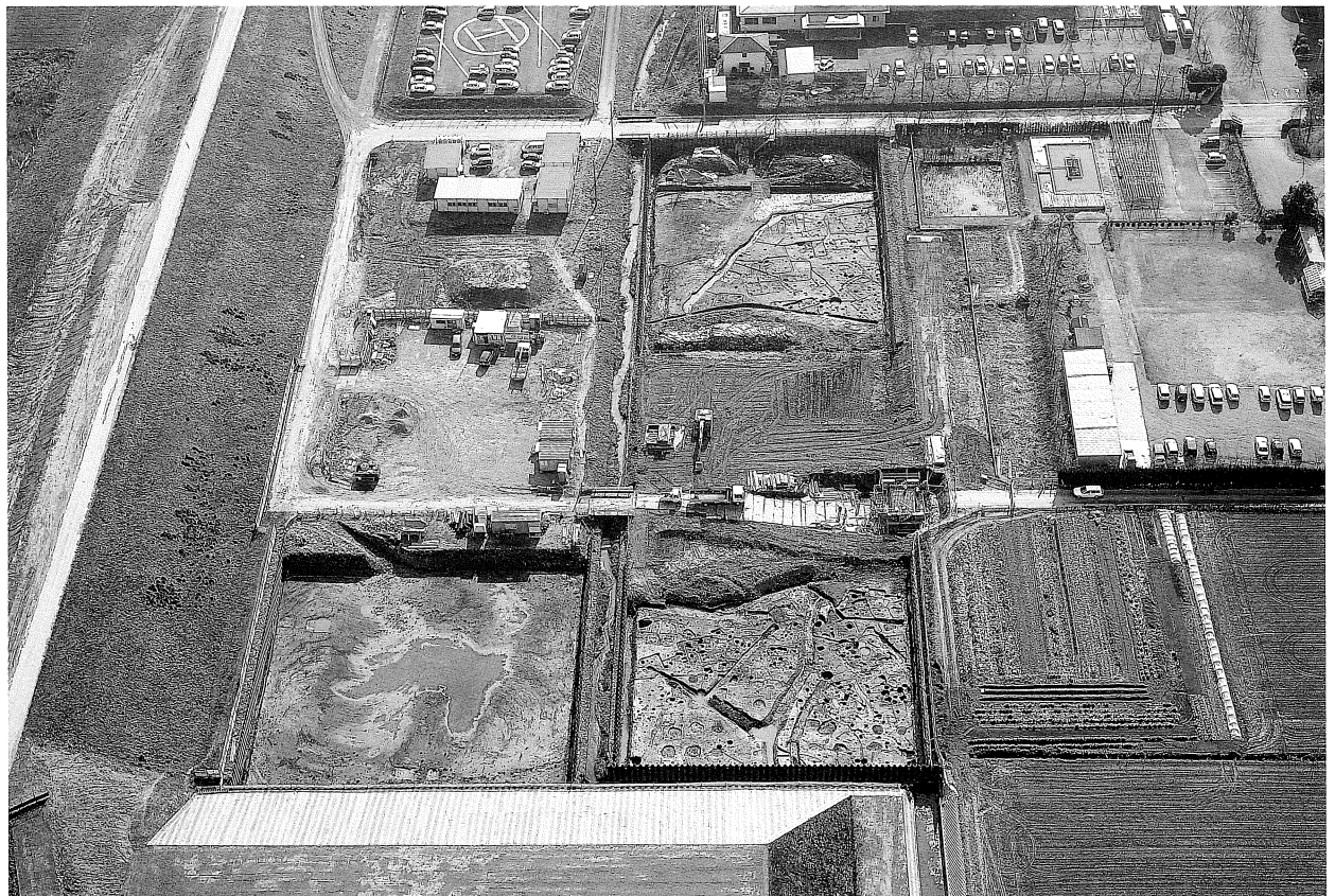
2 調査区全景（北から）
