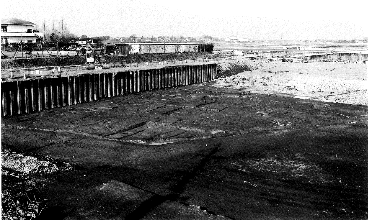
1 調査区南半全景（南西から）
