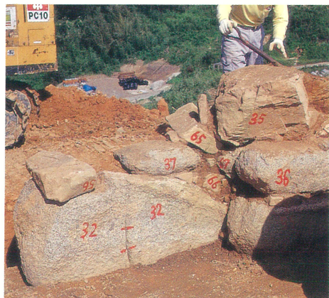
遺跡移築復元のための石材搬出作業
