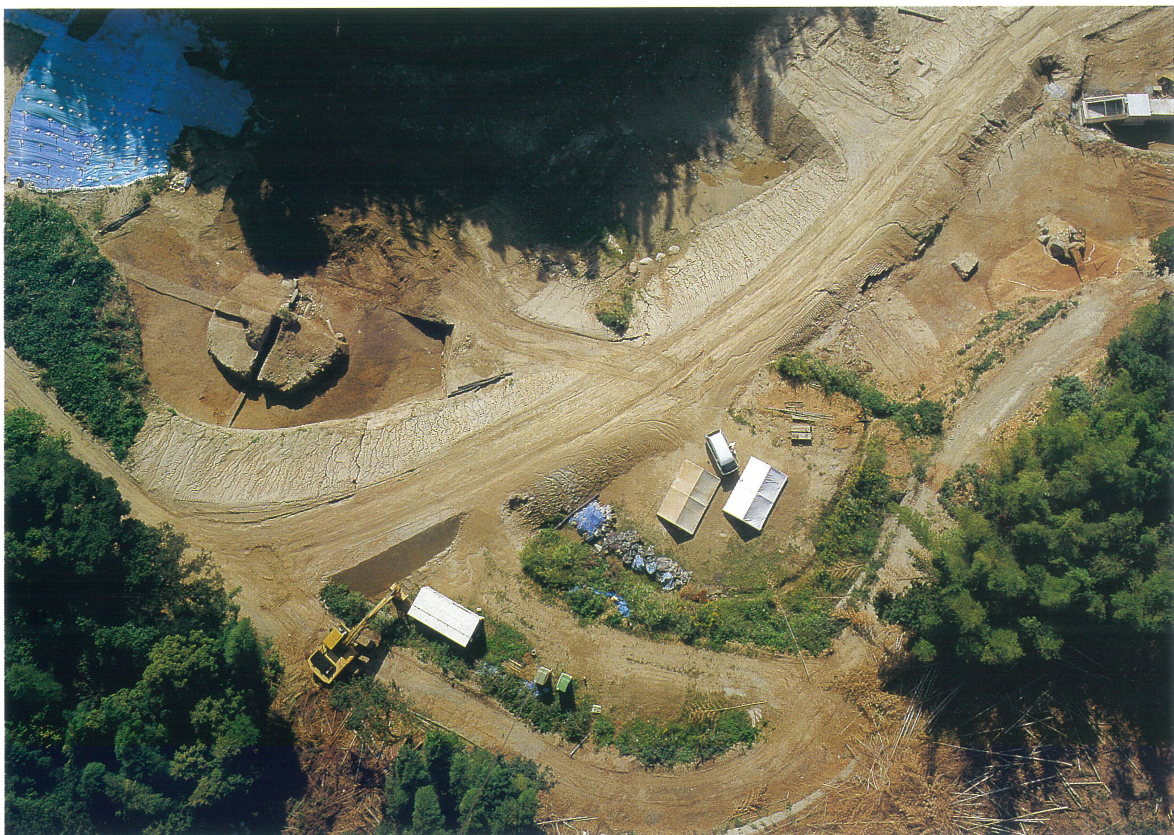
Fig.19 西堂田代古墳群B群全景
