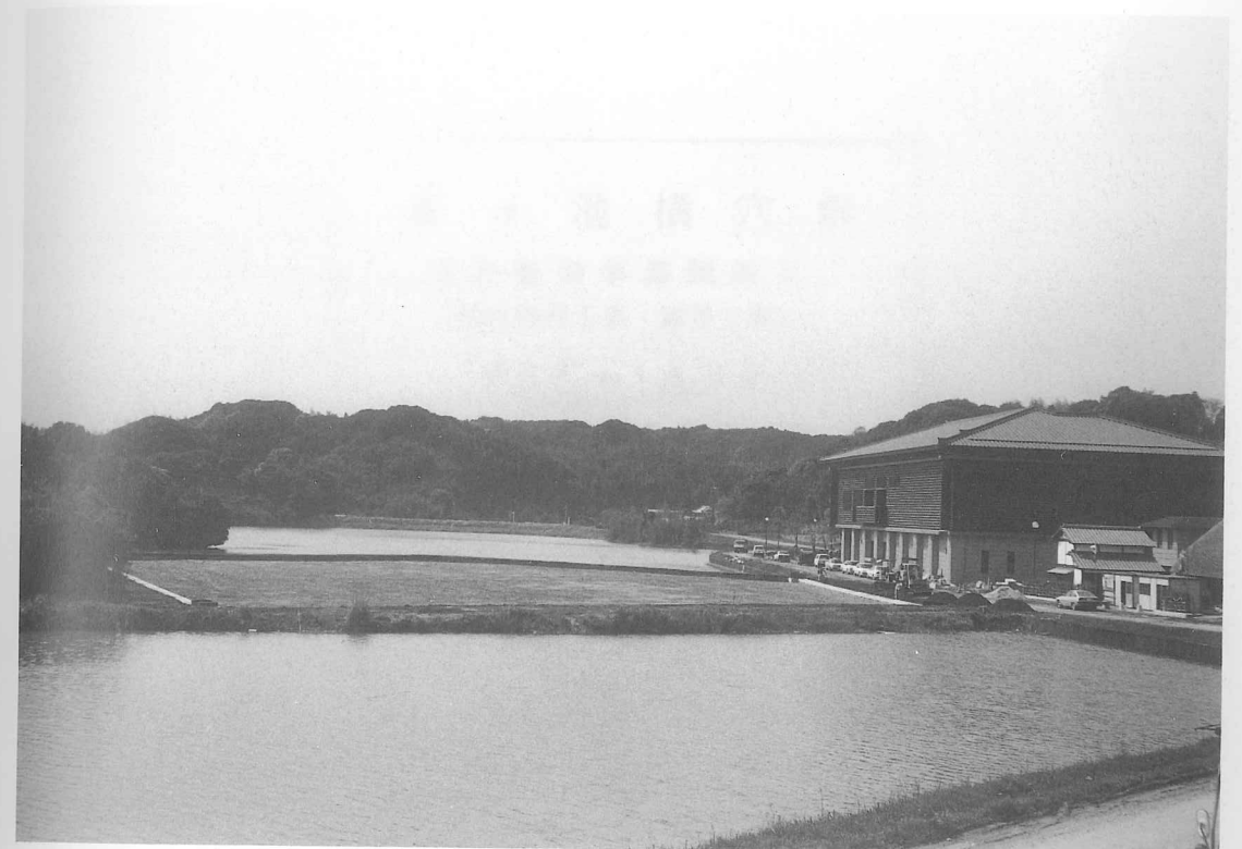
図版74 駐車場整備工事
