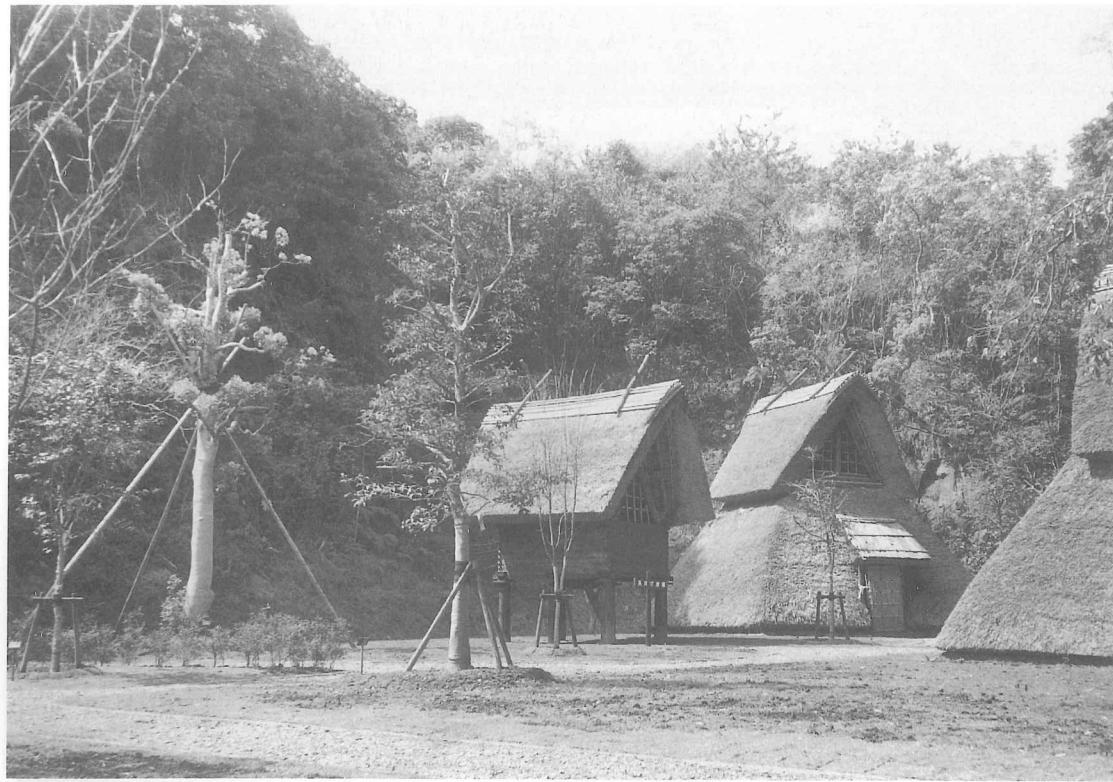
図版67 竪穴住居復元広場修景工事
