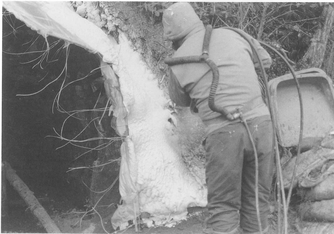
図版12 13号横穴「発泡ウレタン吹き付け状況」
