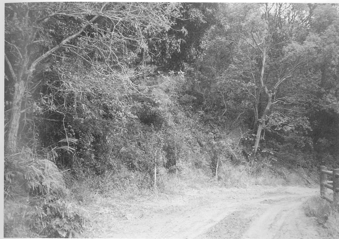
图版54 36~39号横穴前庭部補強工事「着工前」
