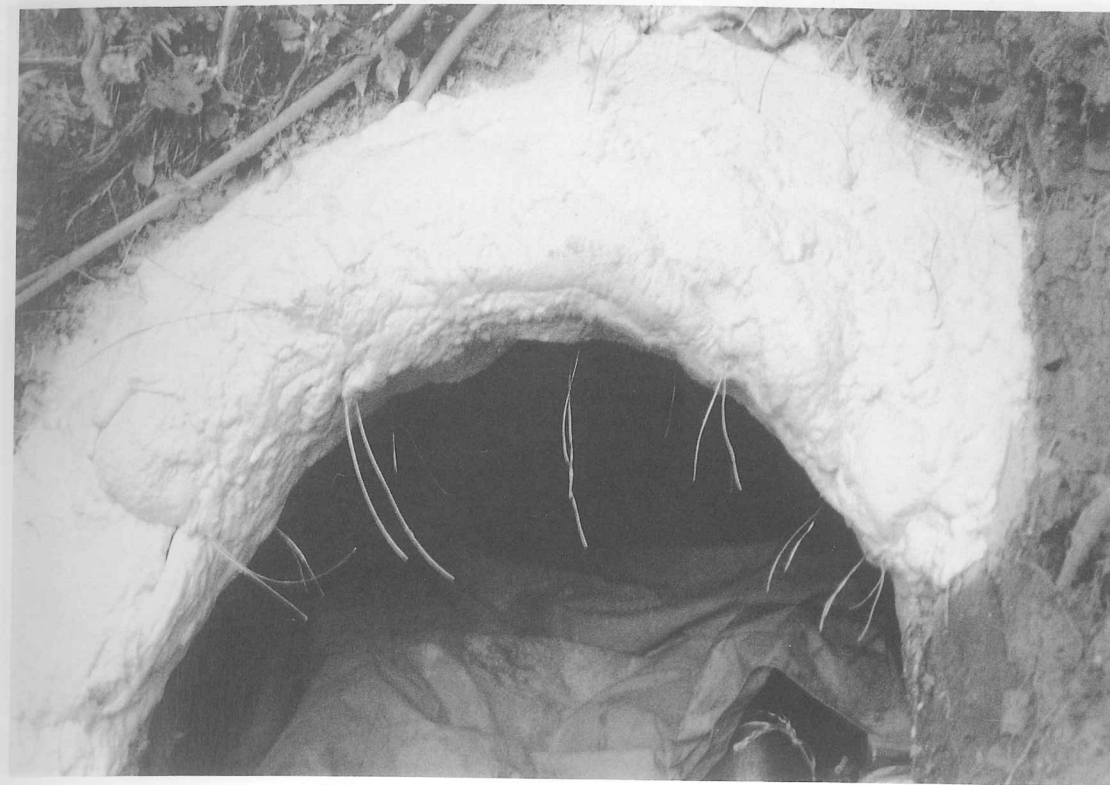
図版41 31号横穴「発泡ウレタン吹き付け状況」
