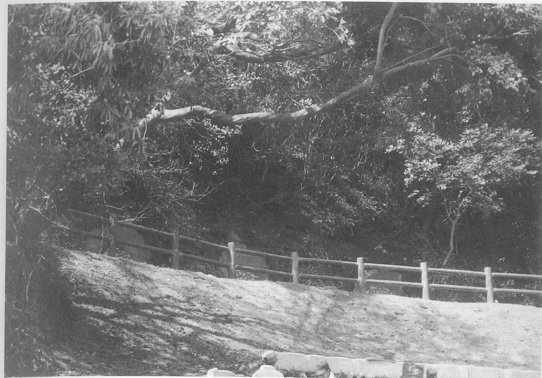
図版57 36～39号横穴見学道安全擬木柵設置工事〔完 成〕
