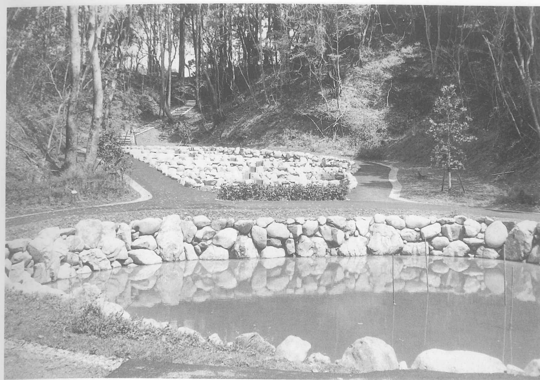
図版61 蓮池及び湿性植物園整備工事〔完成〕
