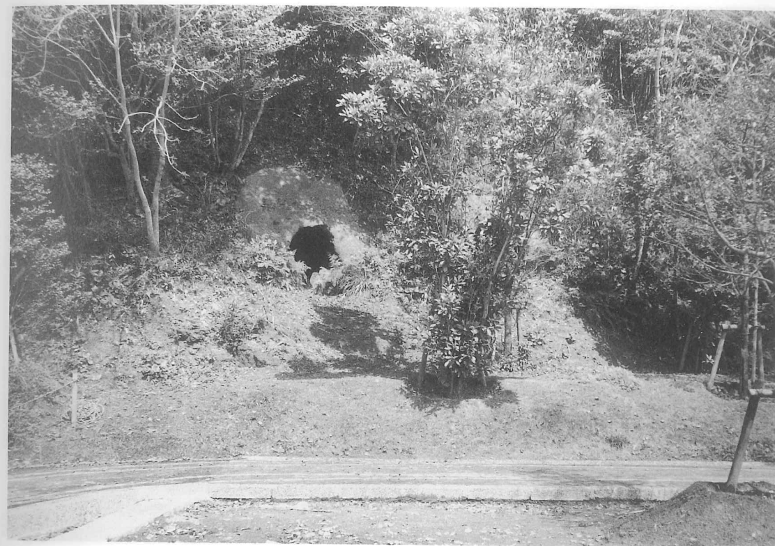
図版58 見学道舗装工事①〔6～8号横穴見学道〕〔完 成〕
