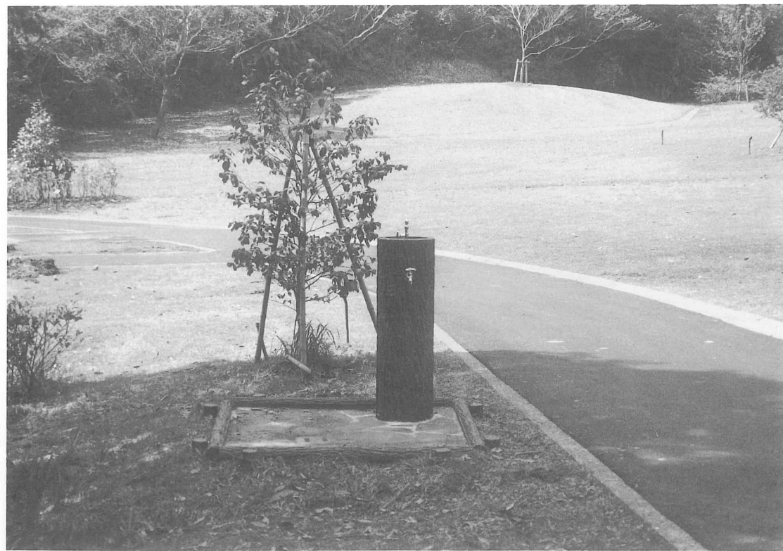
図版63 水飲み場整備工事「完成」
