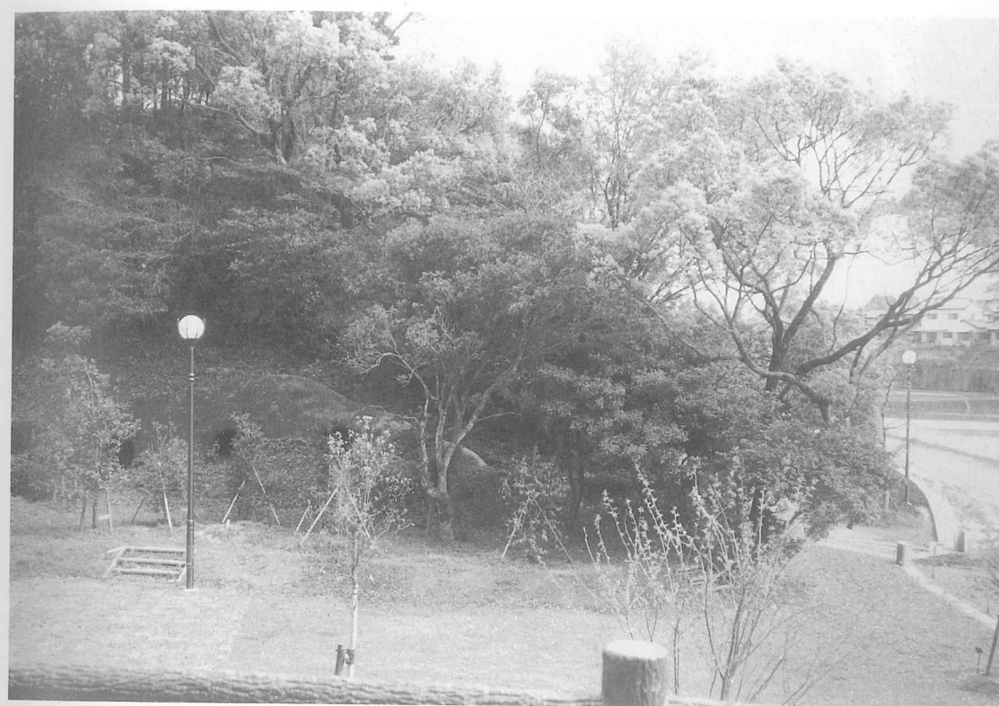
図版62 園内照明工事〔完成〕
