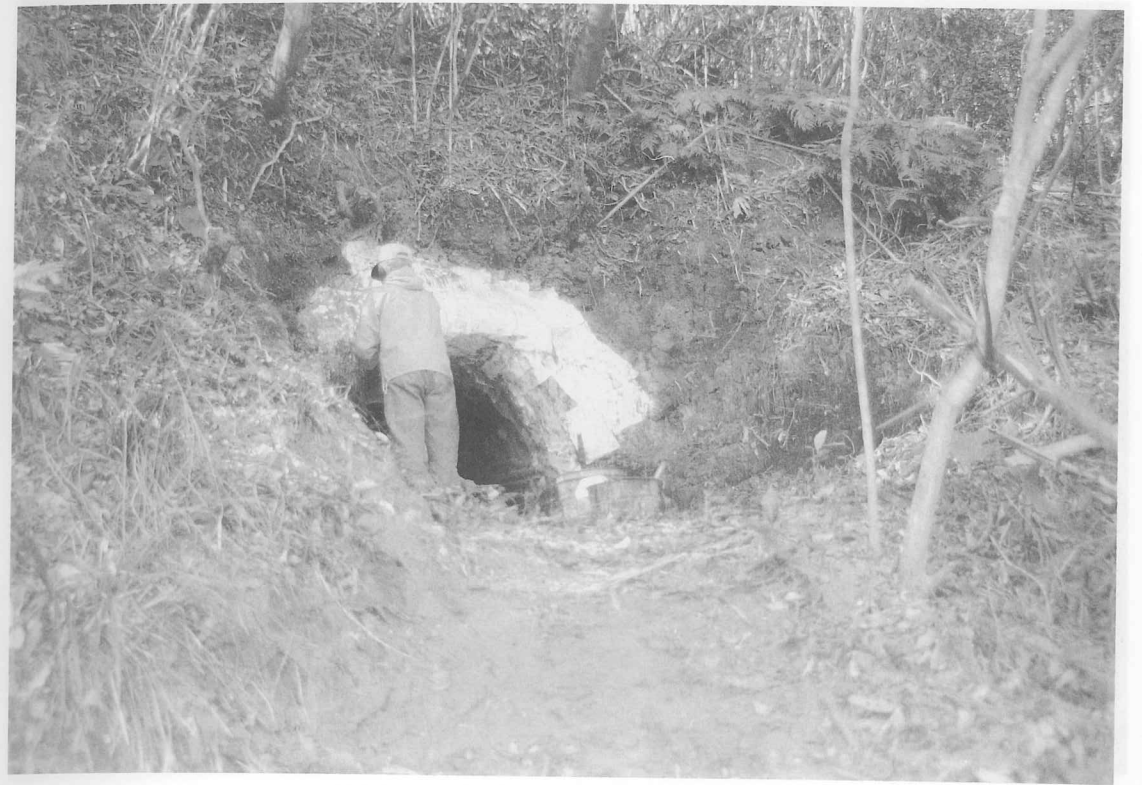
図版21 23号横穴「FRP貼り付け状況」
