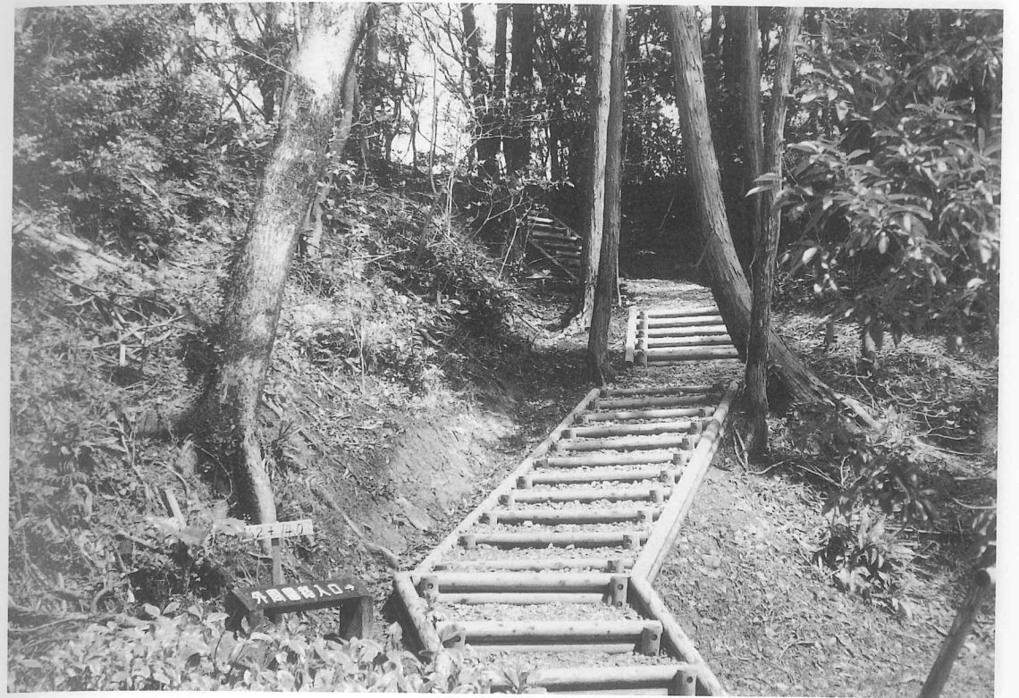
図版69 外周園路工事〔中央谷間から稲荷池奥部〕
