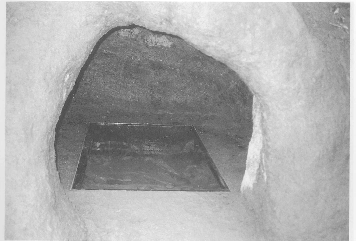
図版18 13号横穴「玄室床面保護被覆板設置工事完成」
