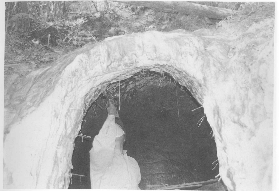
図版37 35号横穴「発泡ウレタン被覆、FRP貼り付け状況」
