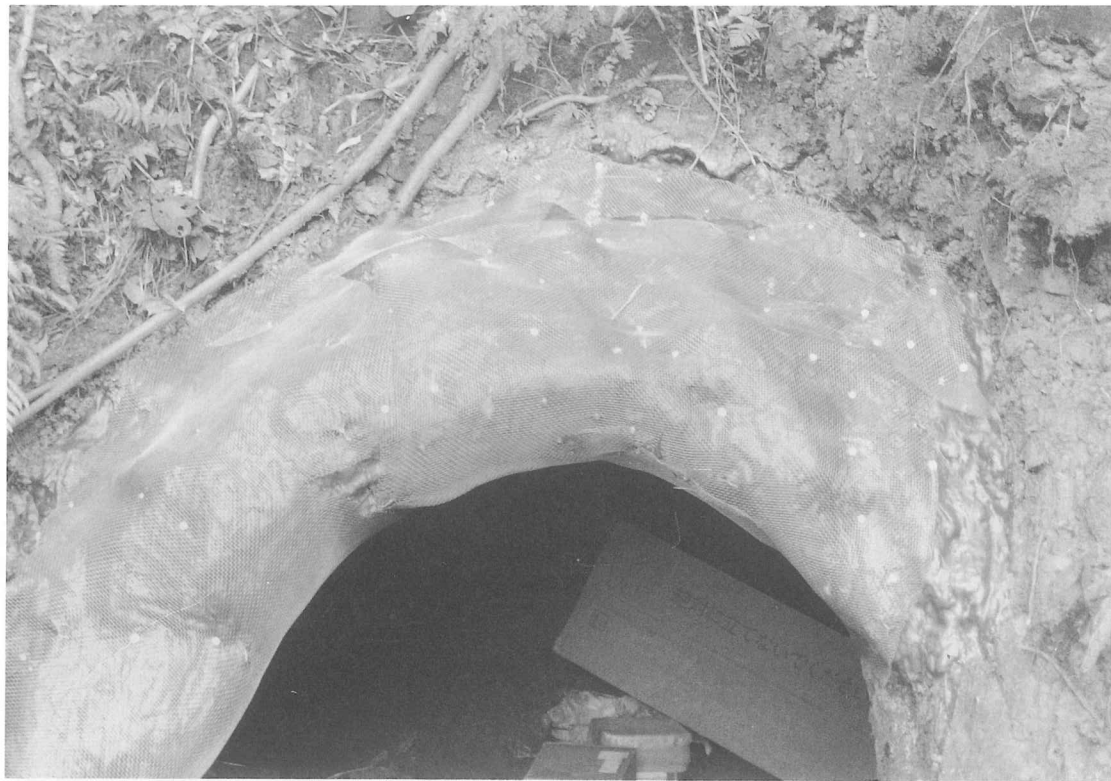
図版43 31号横穴「ステンレス金網取り付け状況」
