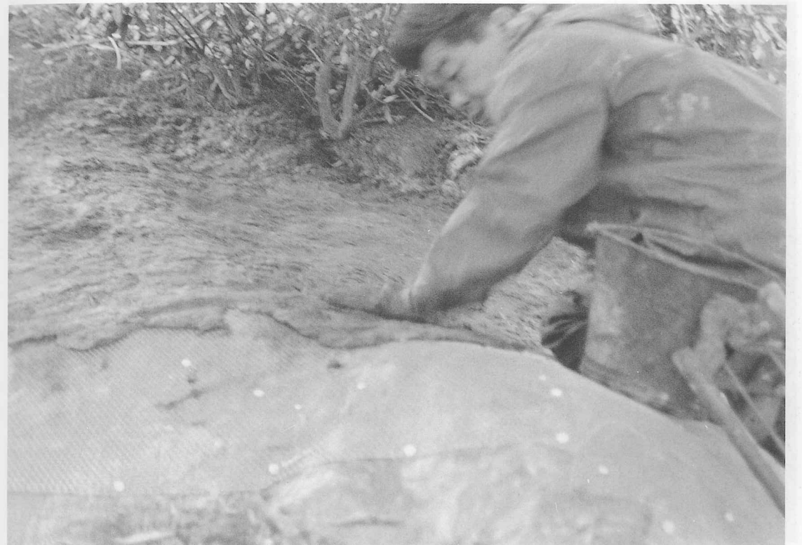
図版14 13号横穴「金網取り付け後のエポキシ擬土貼り付け状況」
