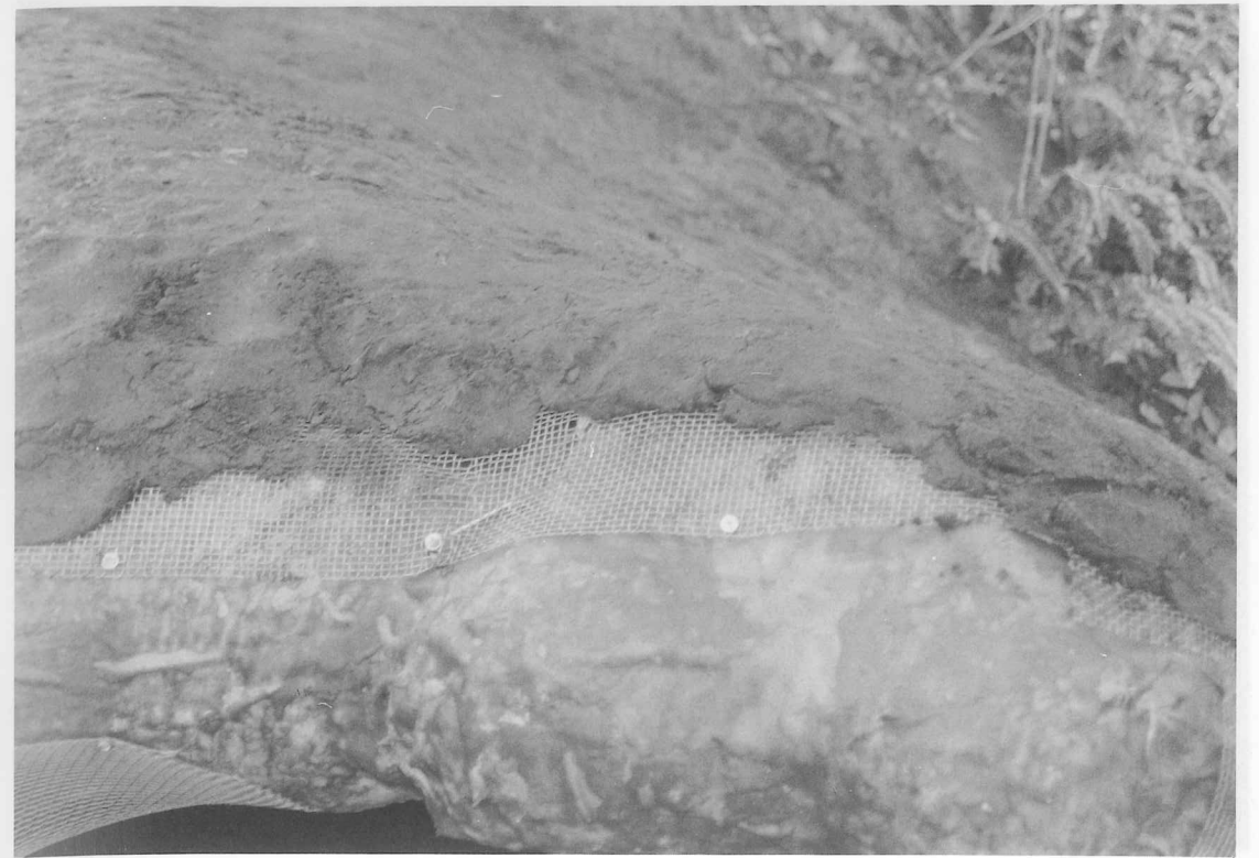
図版13 13号横穴「FRPによるウレタン被覆後の金網取り付け状況」
