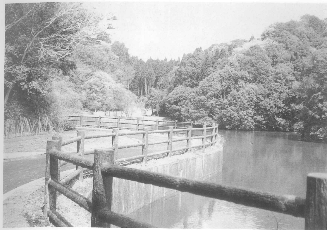
図版65 園路舗装工事②〔御諏訪池縁園路〕「完成」
