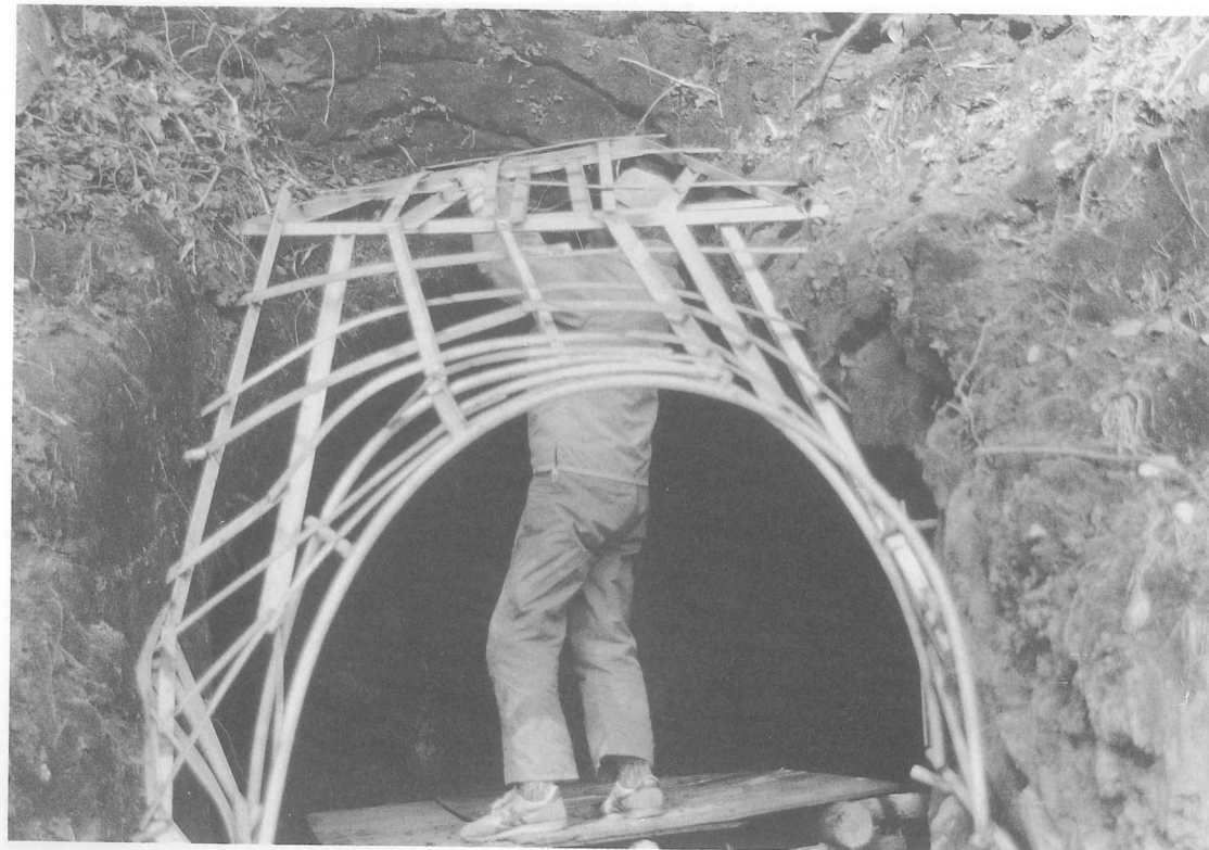
図版36 35号横穴「玄室天井及び羨道、羨門口復元ステンレス骨組」
