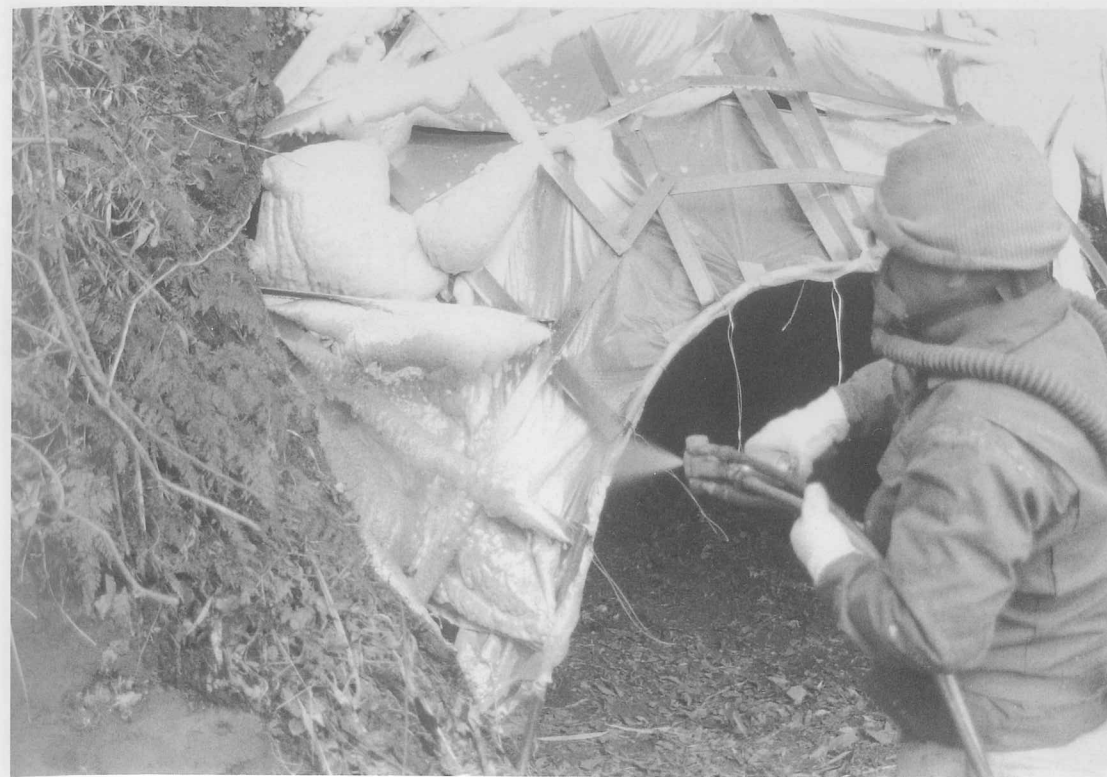
図版25 29号横穴「発泡ウレタン吹き付け状況」
