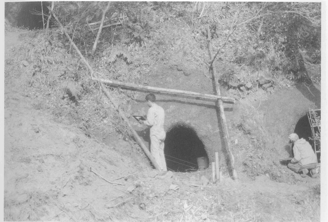
図版30 29号横穴「サイト擬土貼り付け状況」
