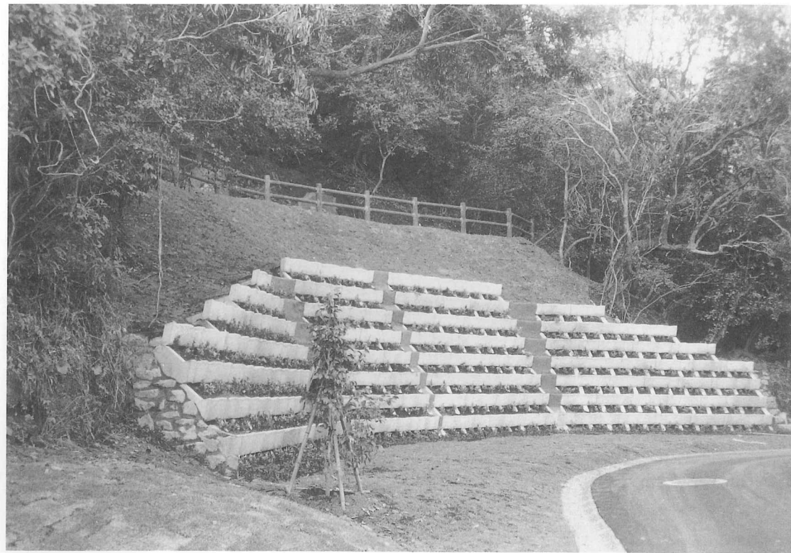
図版55 36～39号横穴前庭部補強工事〔緑化ブロック〕〔完 成〕
