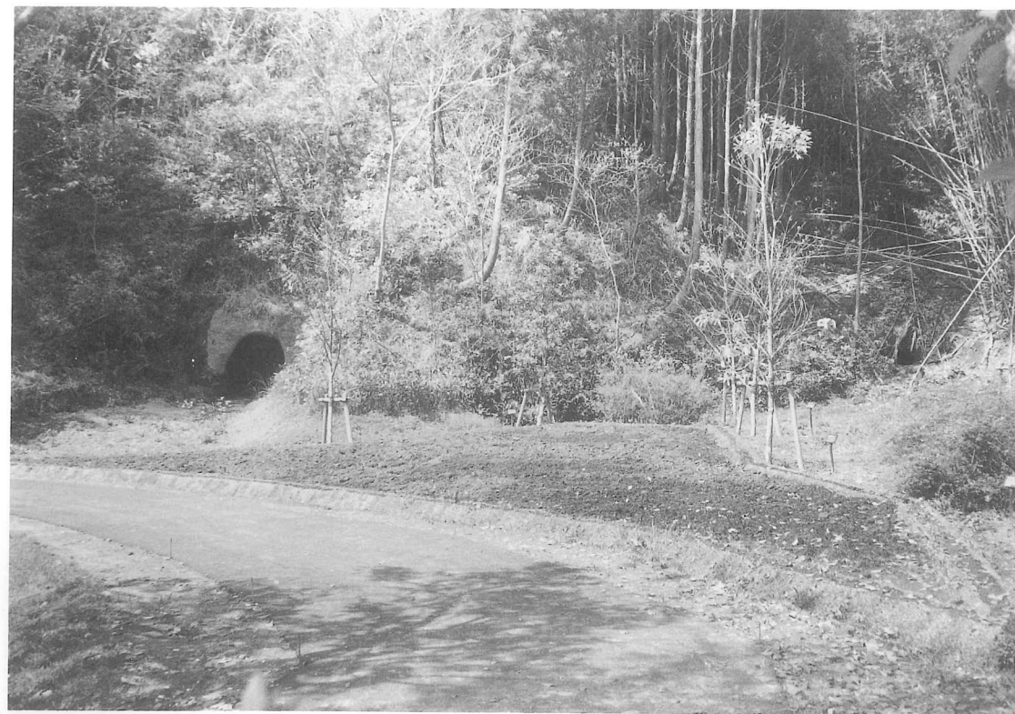
图版51 53号横穴前広場整地修景工事「完成」
