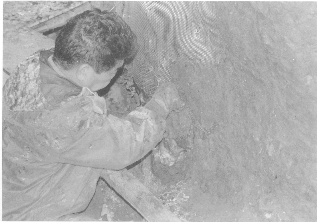
【実写】 図版15 13号横穴「羨道内部エポキシ擬土貼り付け状況」
