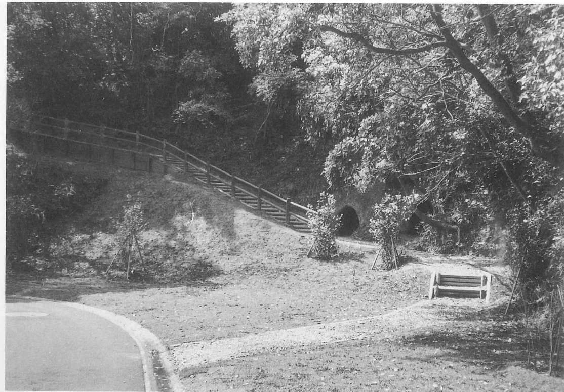
図版56 36～39号横穴見学道設置工事〔完 成〕
