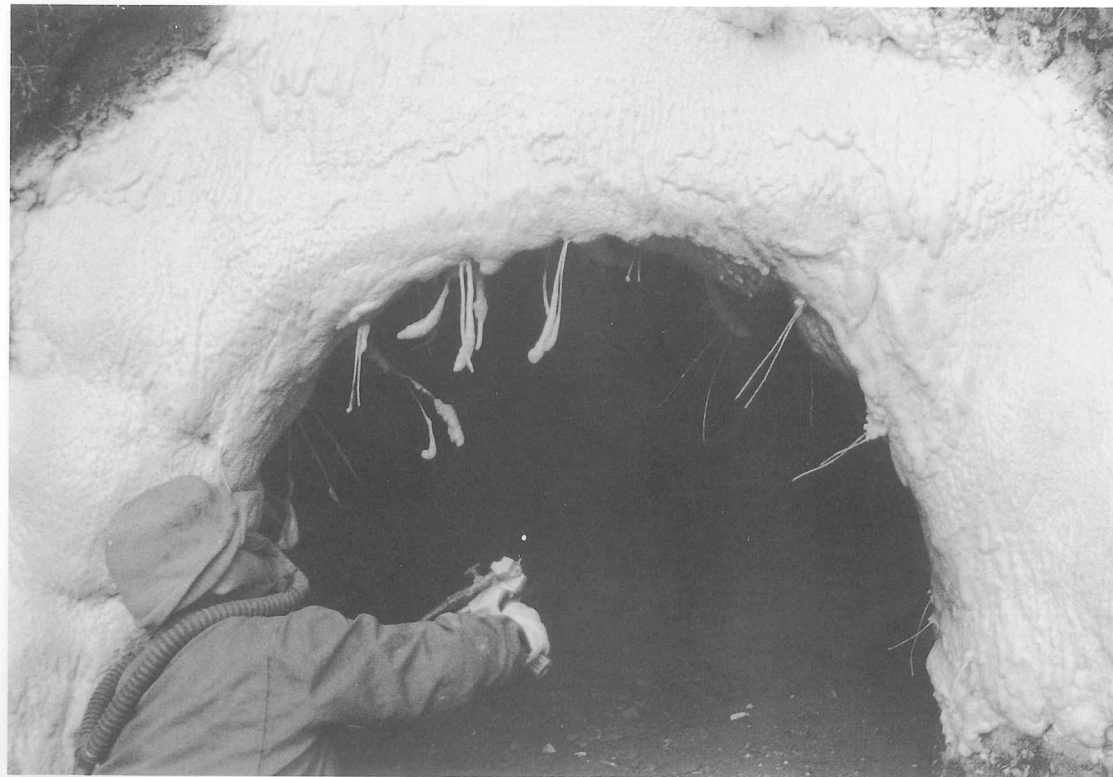
図版20 23号横穴「発泡ウレタン吹き付け状況」
