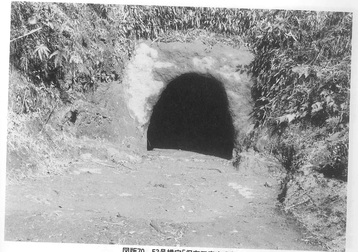
图版70 53号横穴「保存工事完成」
