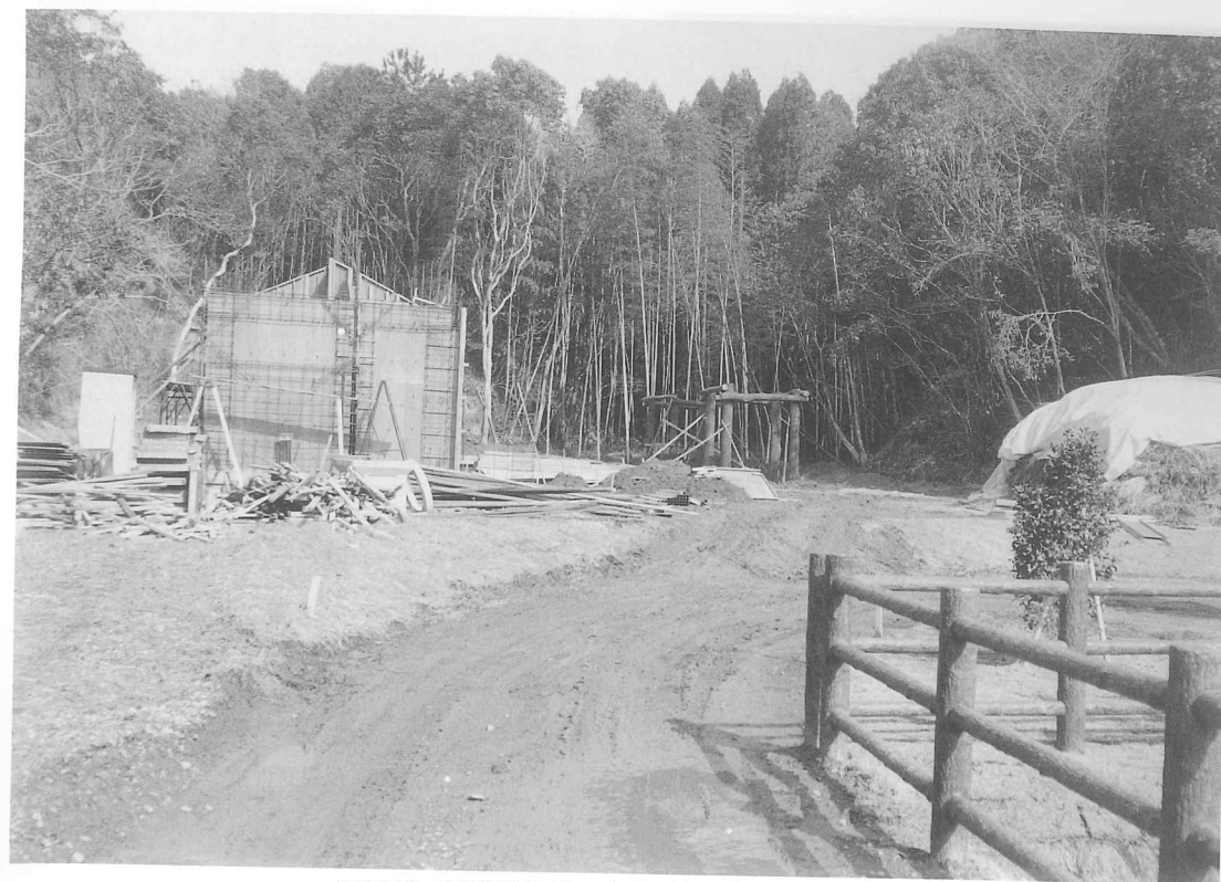
図版83 便所棟仮枠工事(御諏訪池西岸支谷建設)
