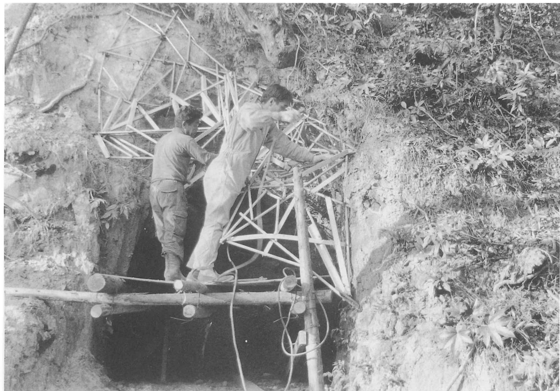
図版44 69号横穴「ステンレスによる玄室天井、羨道部骨組状況」
