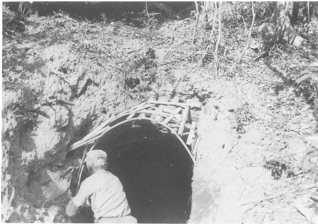
図版51 72号横穴「ステンレスによる羨道部骨組状況」
