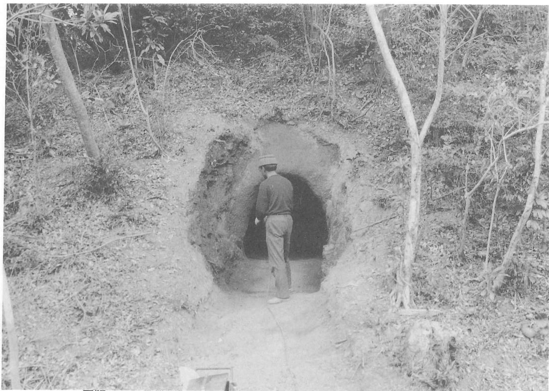
図版55 72号横穴「サイト擬土による仕上げ後の玄室部サンコール含浸」
