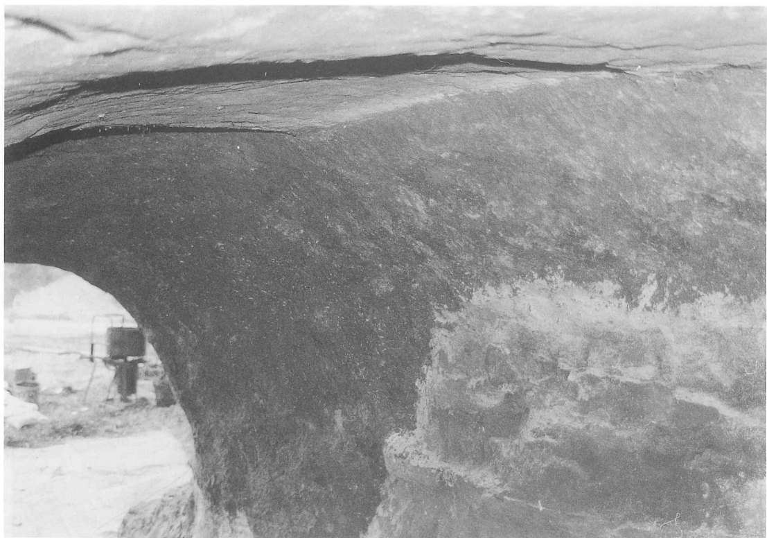
図版40 53号横穴「羨道部から玄室にかかる崩落部のエポキシ擬土押圧貼り付け修復」
