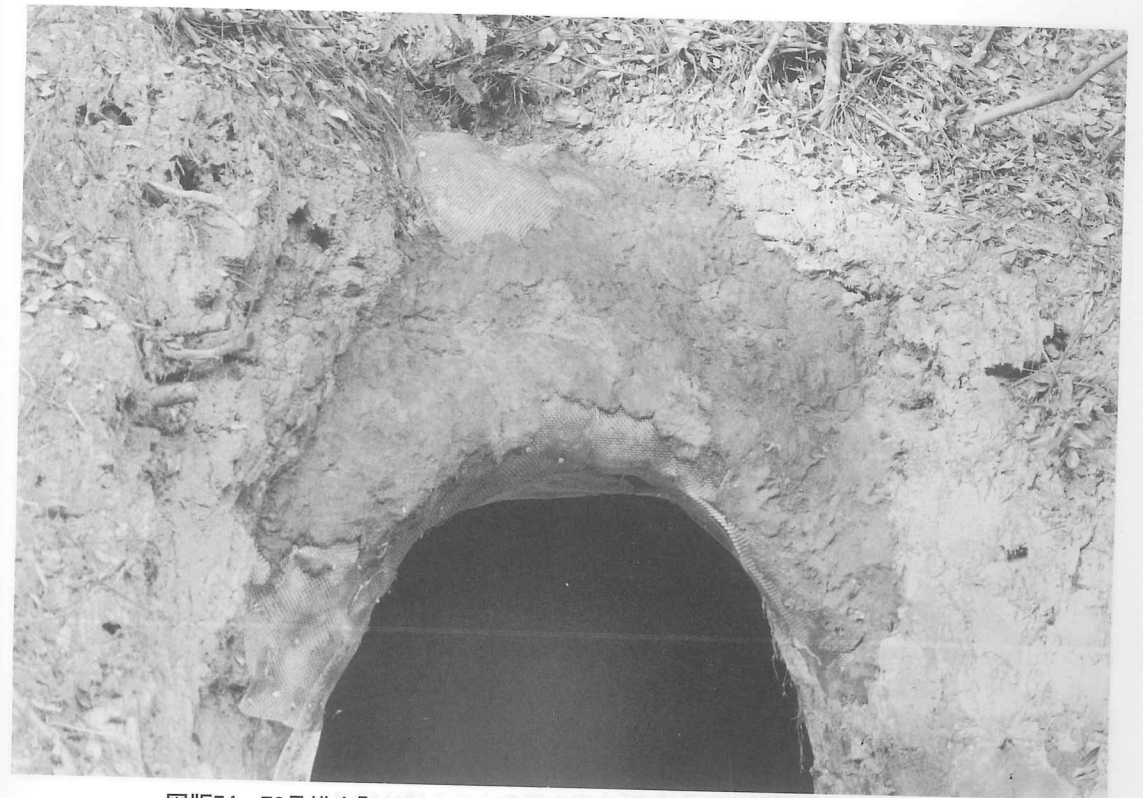
図版54 72号横穴「ステンレス金網貼り付け後のエポキシ擬土押圧貼り付け」
