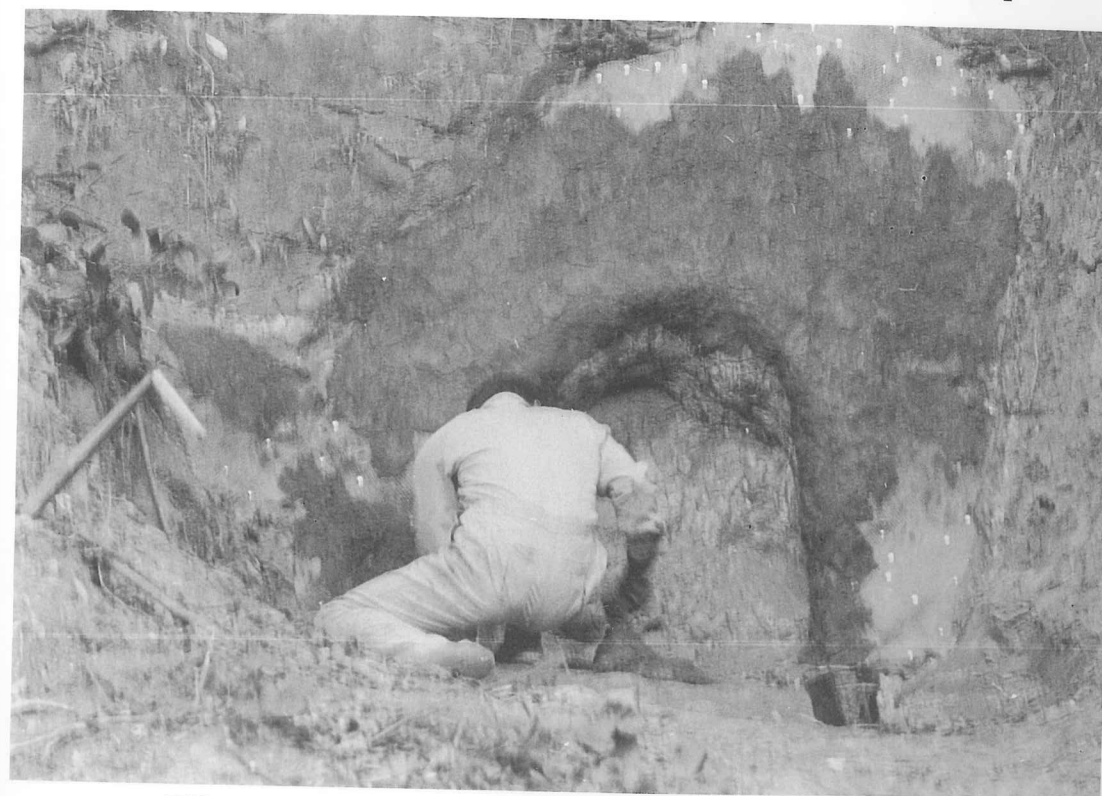
図版58 73号横穴「ステンレス金網貼り付け後のエポキシ擬土押圧貼り付け」
