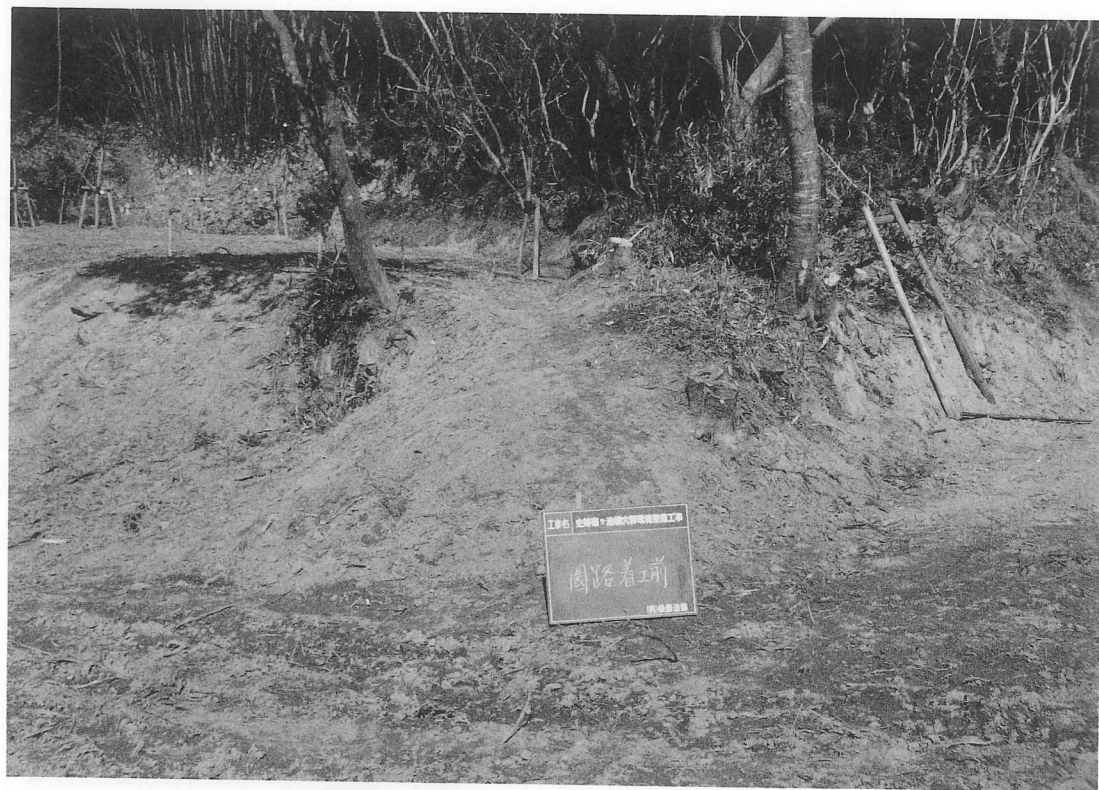
図版78 53号横穴前庭広場園路工事「着工前」
