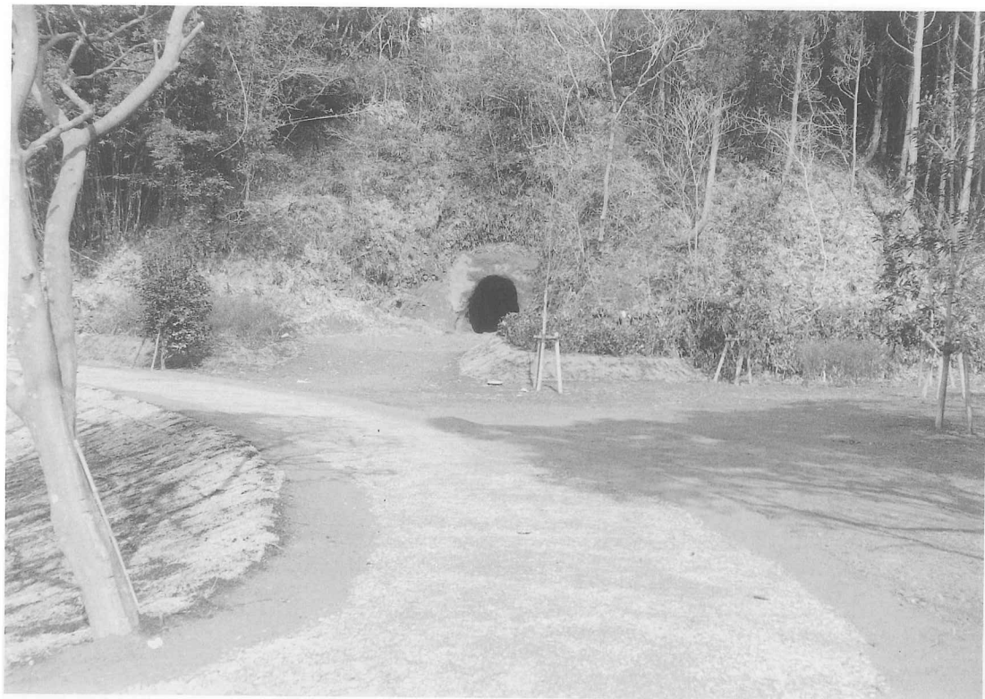
図版82 53号横穴前庭広場植栽工事「完成」
