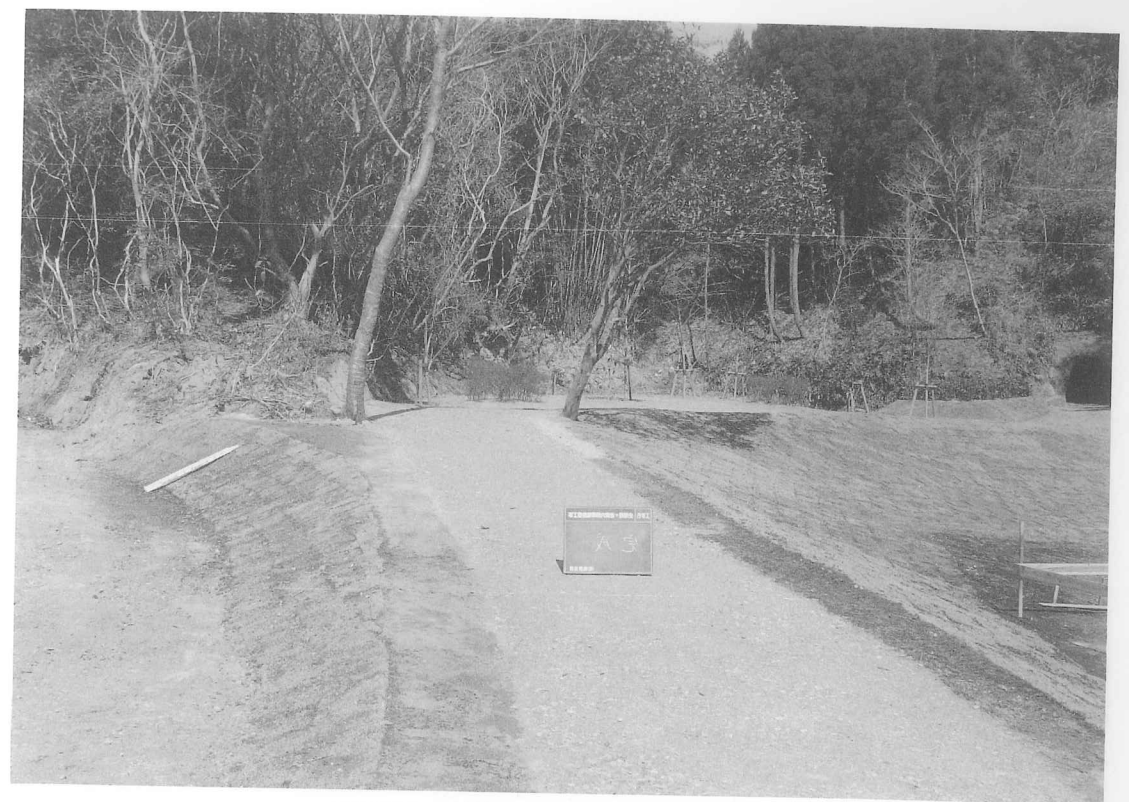
図版79 53号横穴前庭広場園路工事「完成」
