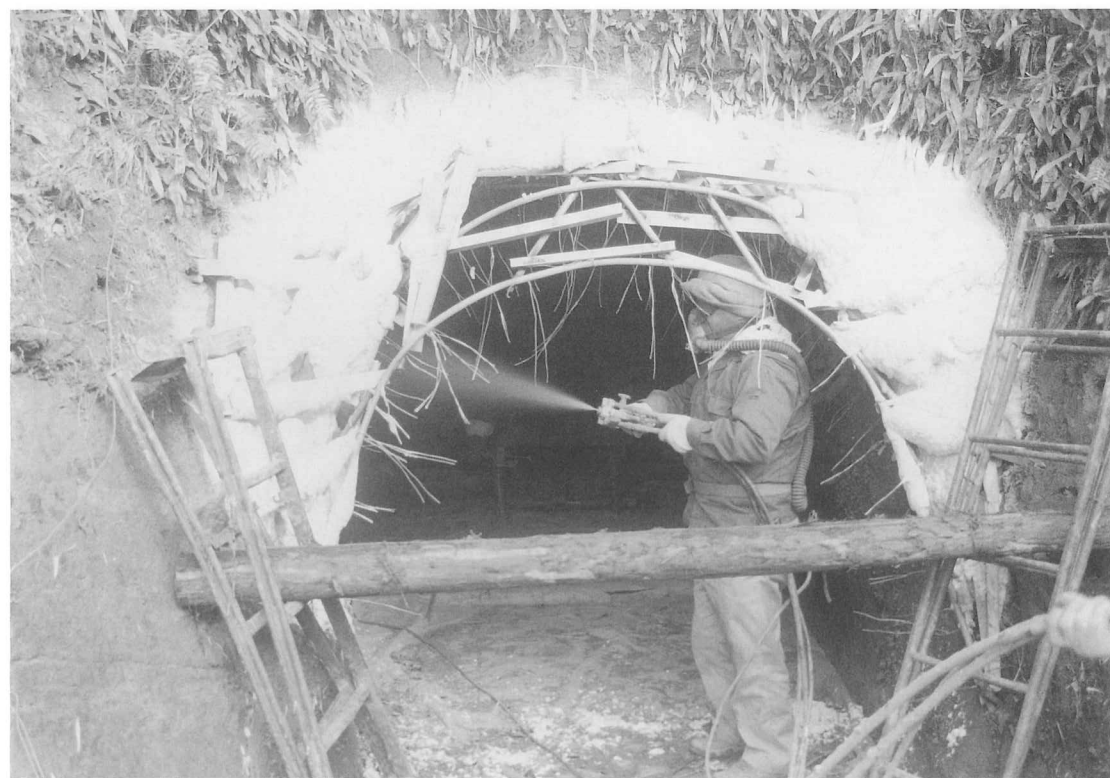
図版32 53号横穴「ステンレスによる羨道部骨組後の発泡ウレタン吹き付け状況」
