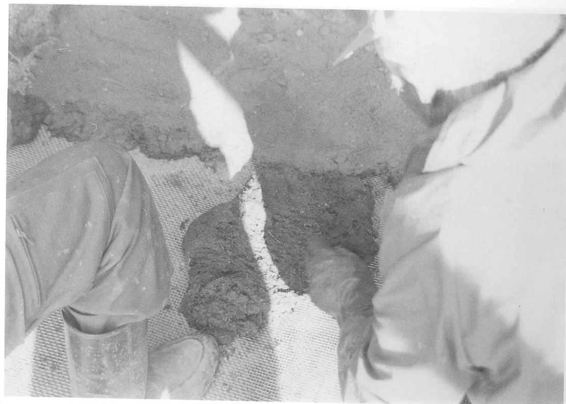
図版42 53号横穴「ステンレス金網貼り付け後のエポキシ擬土押圧貼り付け」
