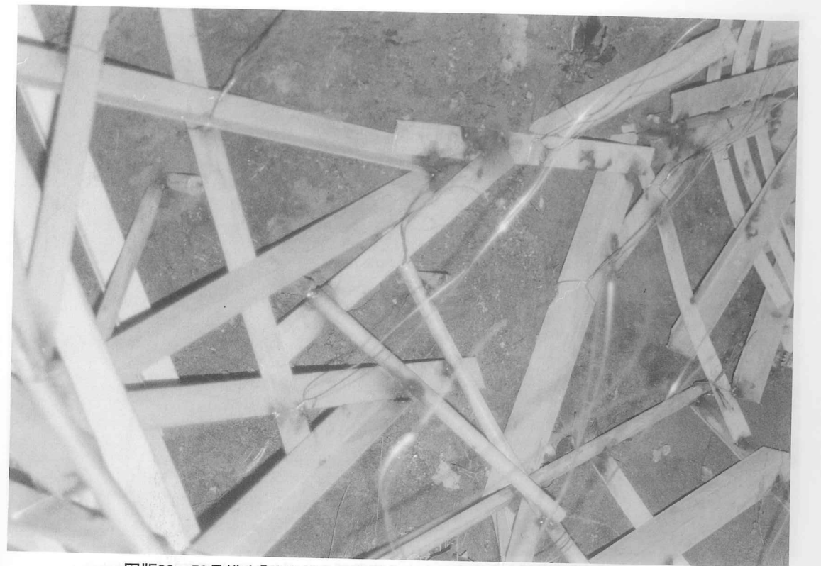
図版38 53号横穴「羨道部から玄室にかかる崩落部の補強ステンレス骨組」
