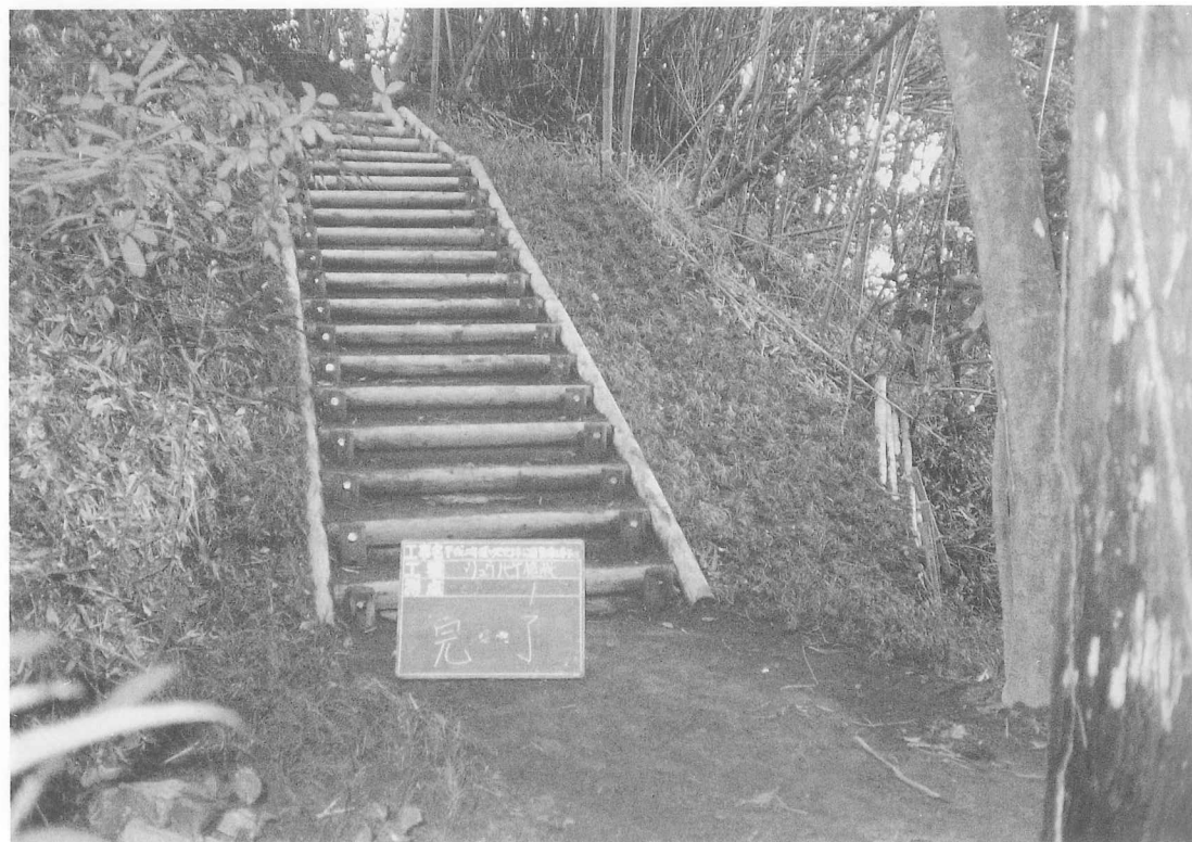
図版94 史跡公園外周園路工事②(完成)
