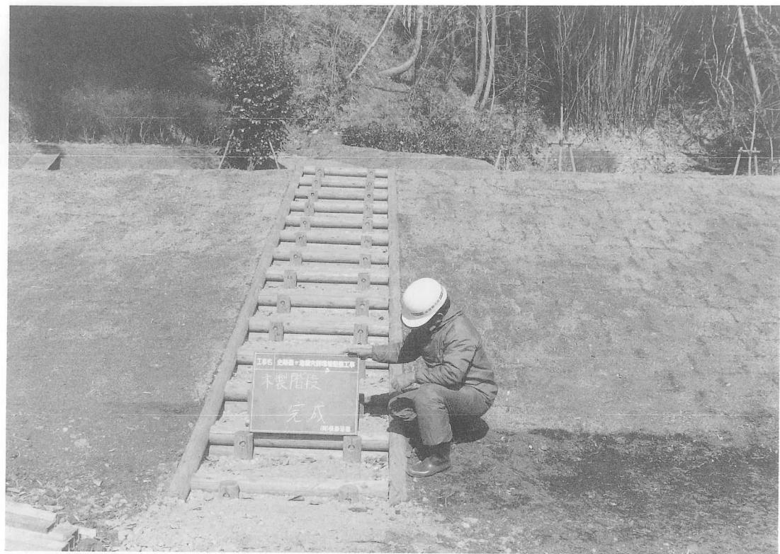
図版81 53号横穴前庭広場階段工事「完成」
