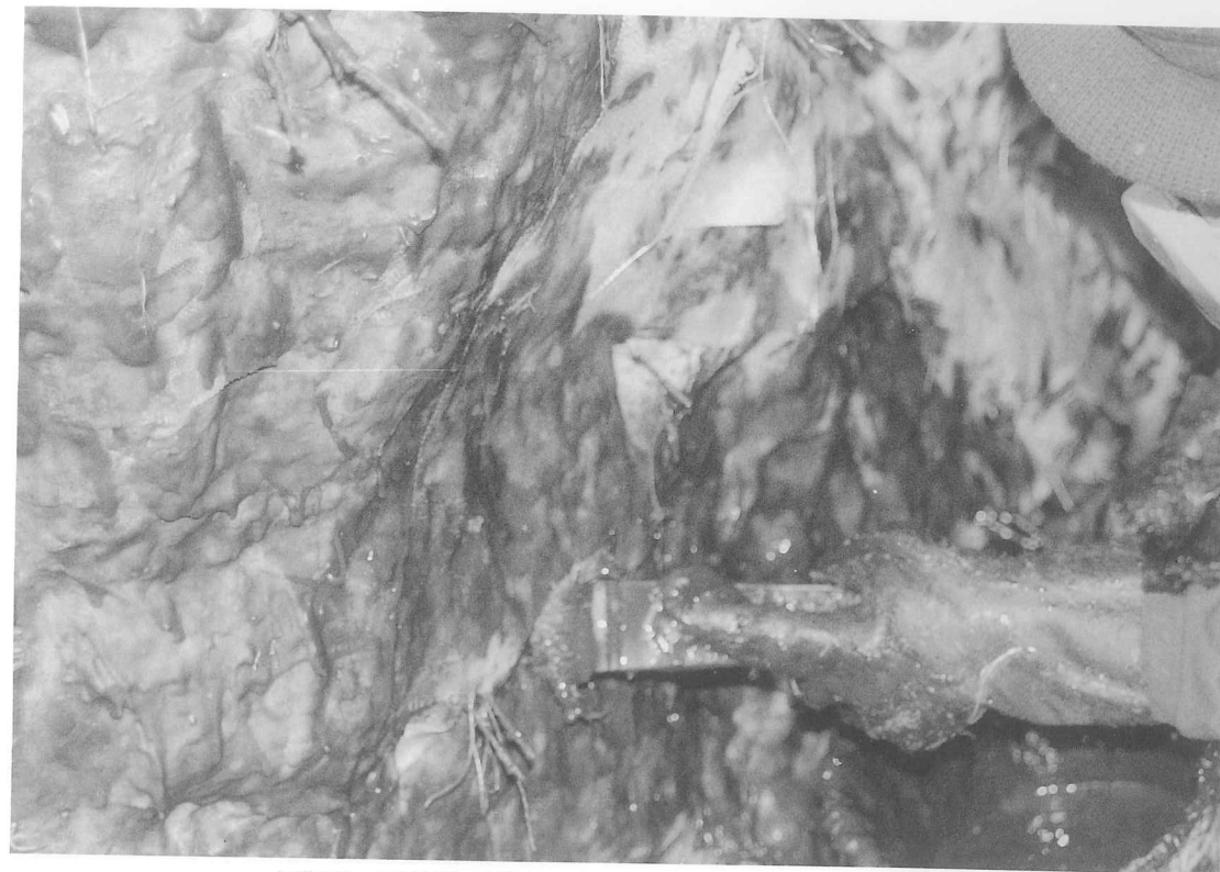
図版33 53号横穴「発泡ウレタン被覆FRP貼り付け状況」
