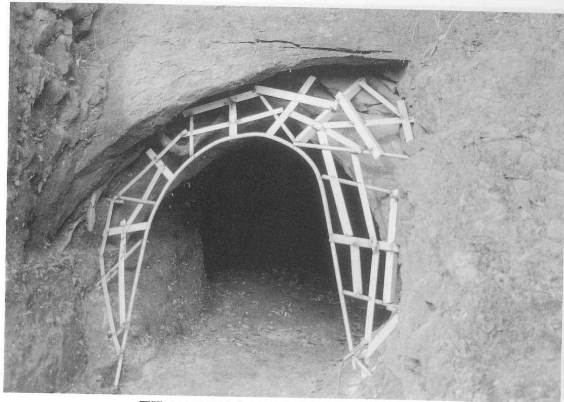
図版21 36号横穴「ステンレスによる羨道部骨組状況」
