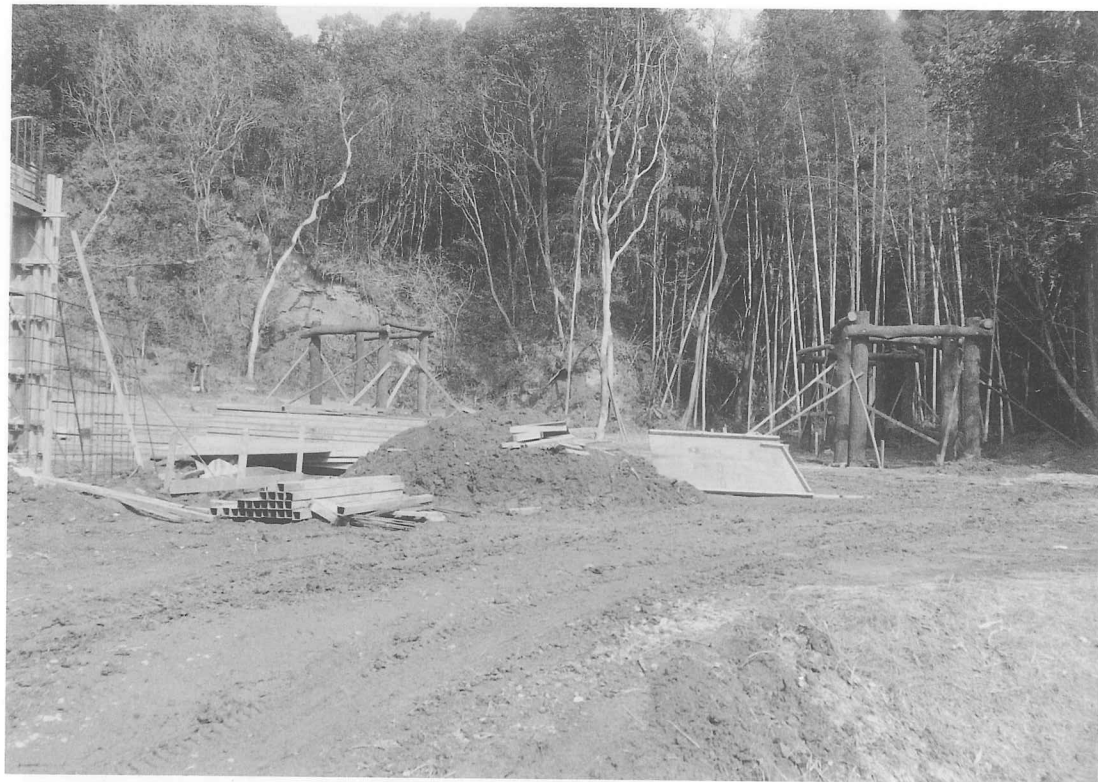
図版86 竪穴住居、高床倉庫建設工事(御諏訪池西岸支谷建設)
