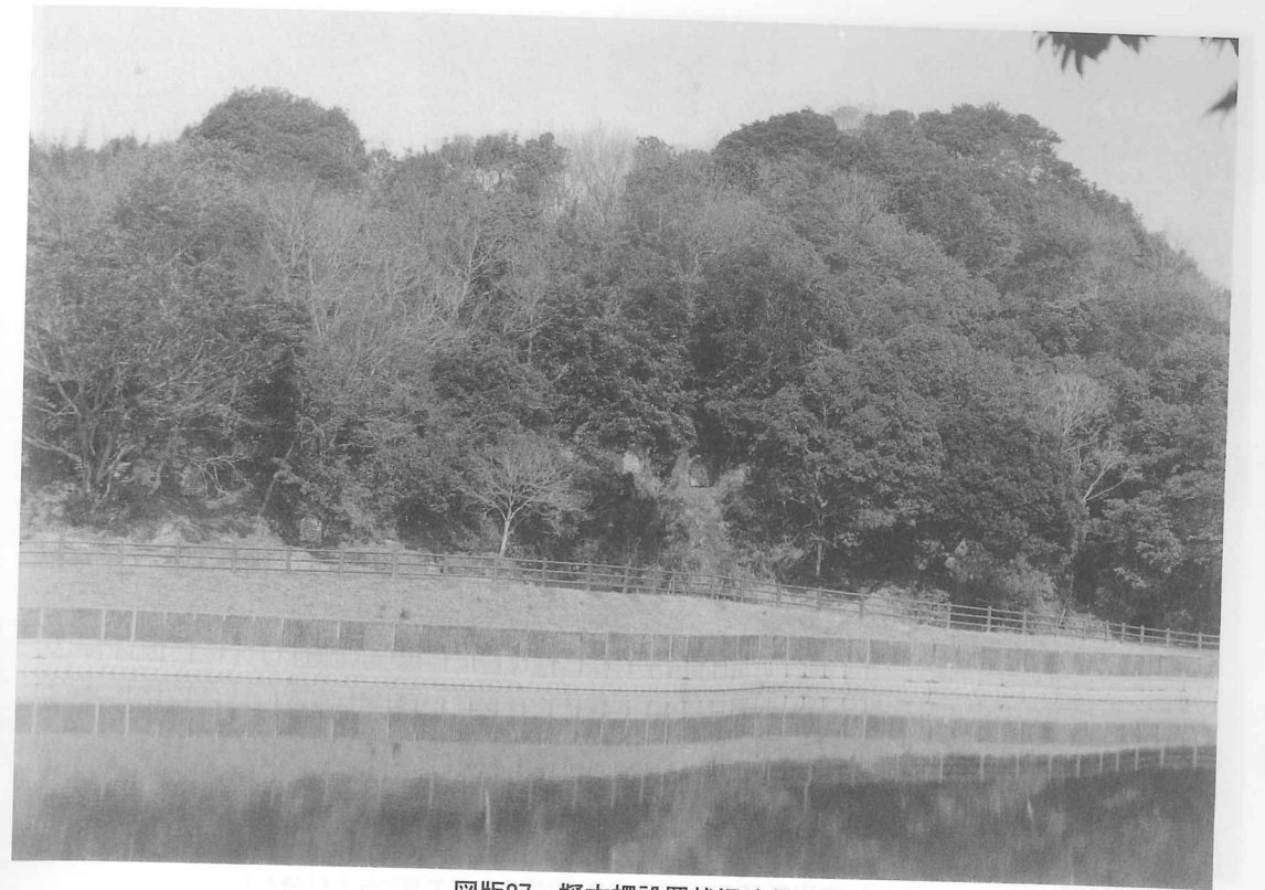
図版87 擬木柵設置状況遠景
