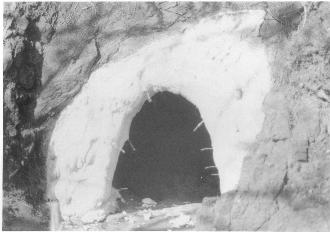
図版23 36号横穴「発泡ウレタン吹き付け」
