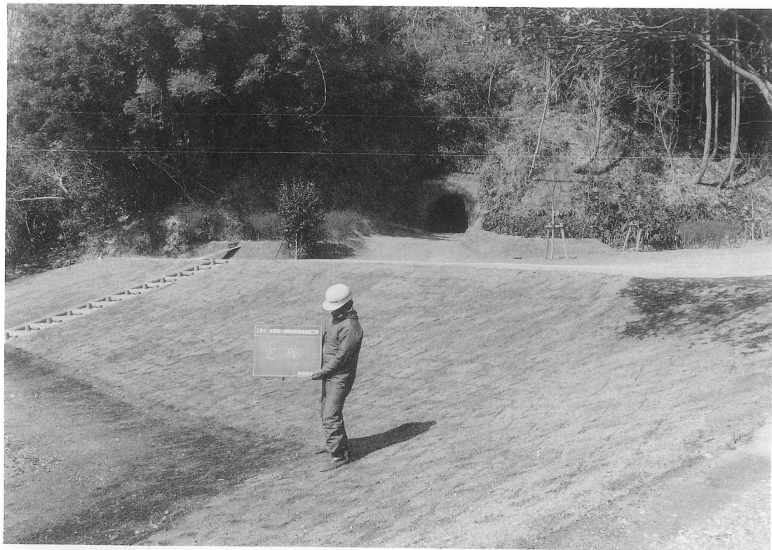
図版77 53号横穴前庭広場修景工事「完成」
