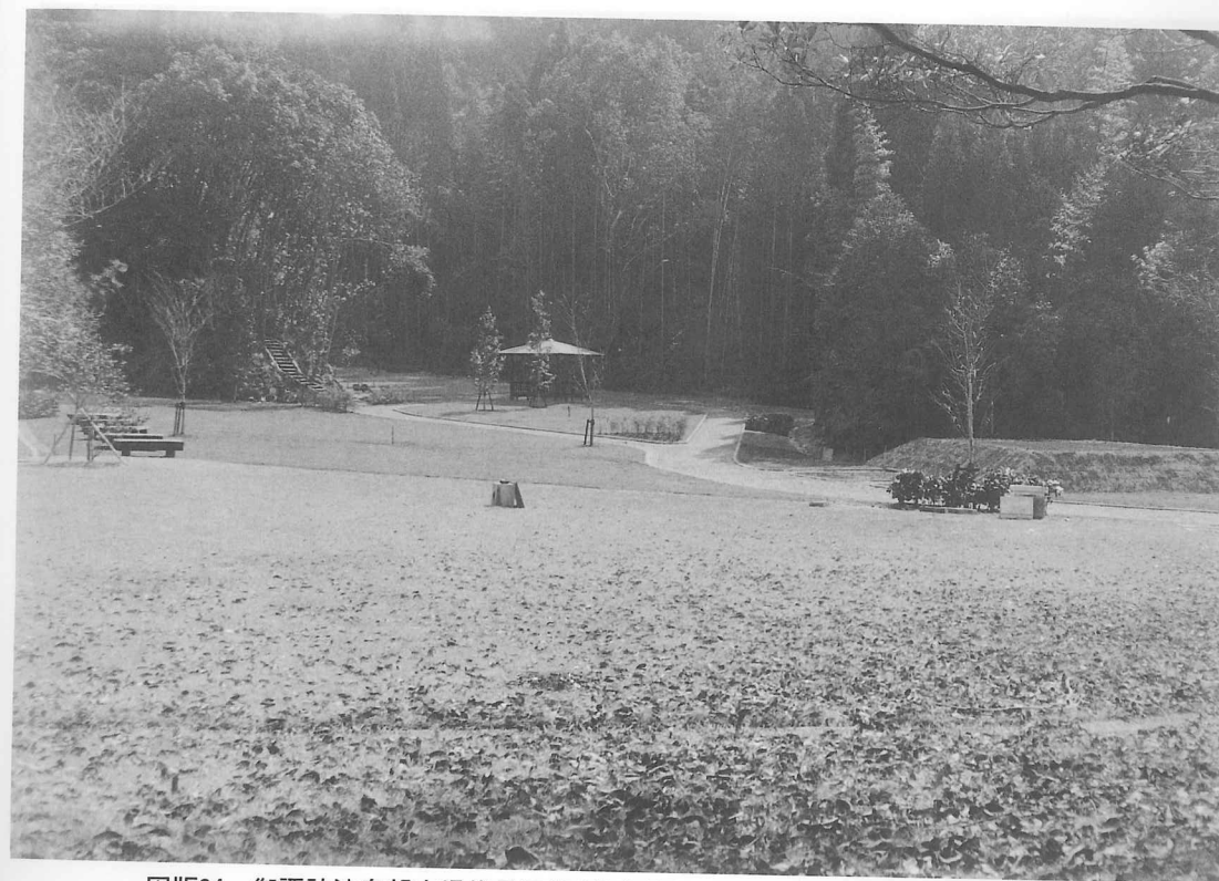
図版84 御諏訪池奥部広場修景工事(芝生舗装、休憩棟、縁台、ベンチ、土舞台、植栽)
