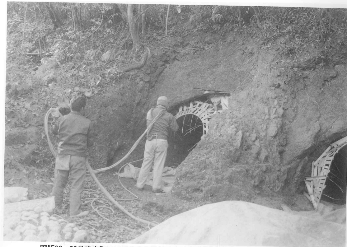
図版22 36号横穴「ステンレスによる羨道部骨組後の発泡ウレタン吹き付け状況」
