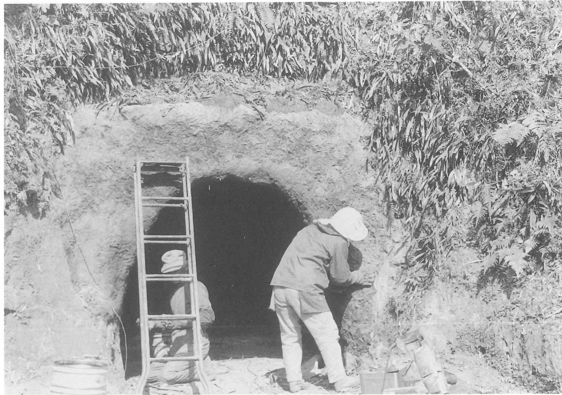
図版35 53号横穴「エポキシ擬土押圧貼り付け」
