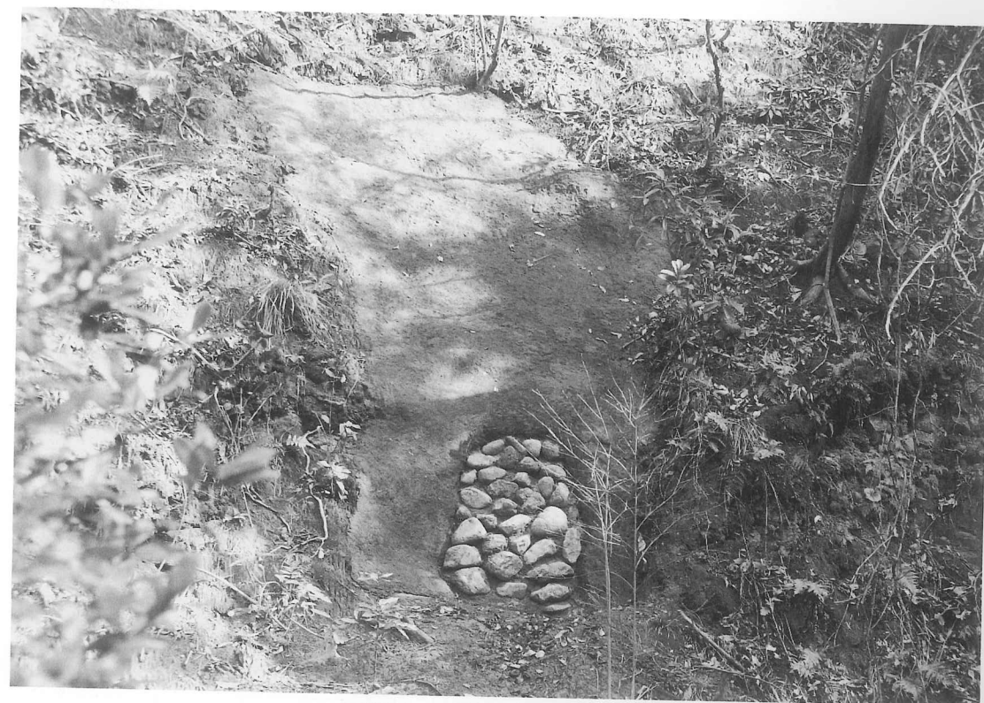
图版74 73号横穴「保存工事完成」
