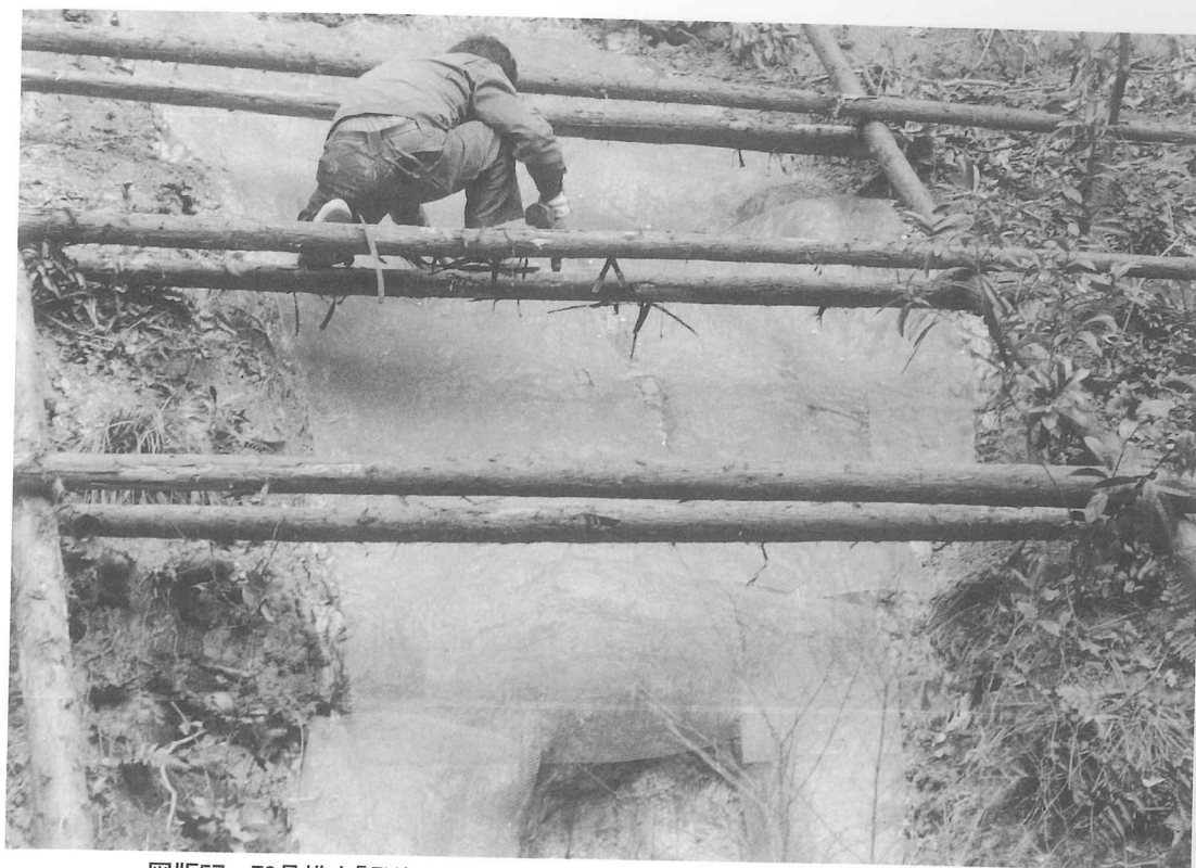
図版57 73号横穴「発泡ウレタン被覆FRP貼り付け後のステンレス金網取付け」
