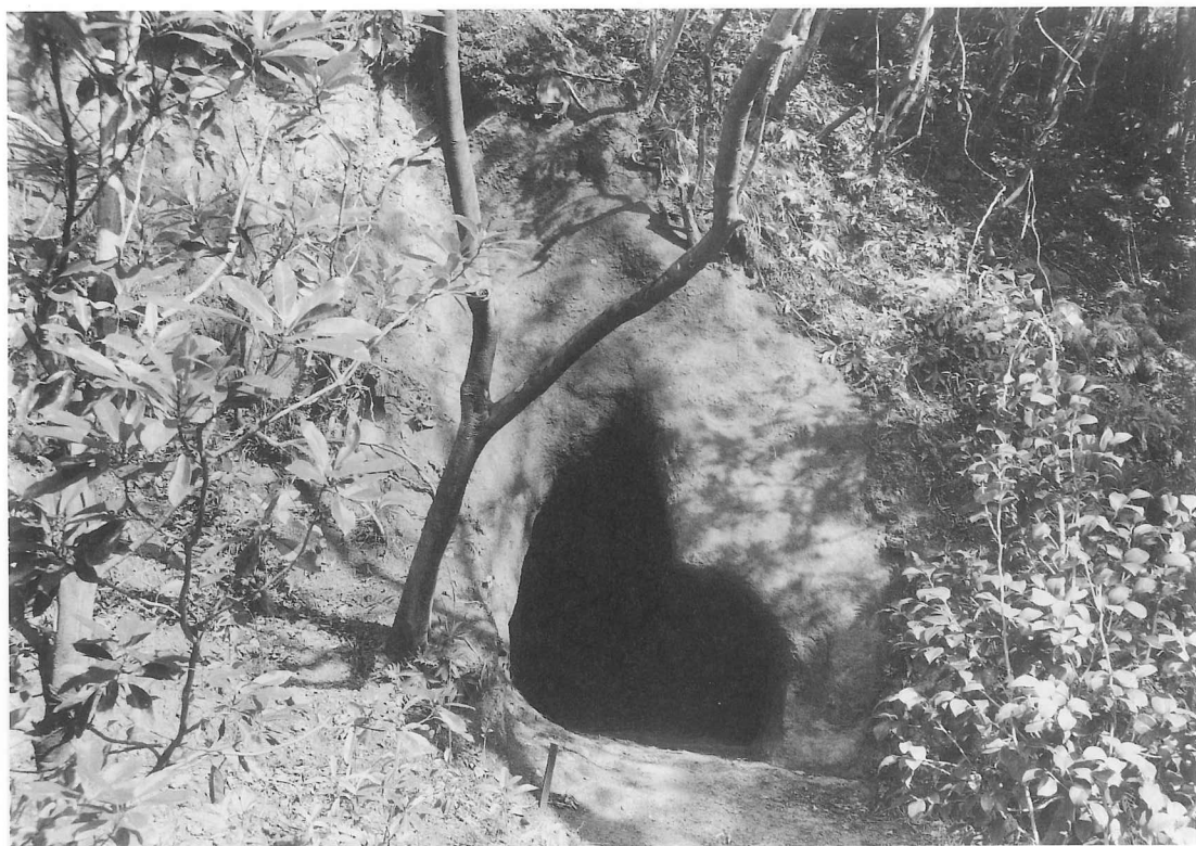
图版71 69号横穴「保存工事完成」
