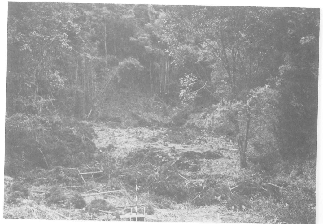
図版64 修景工事（73号横穴前庭広場着工前）
