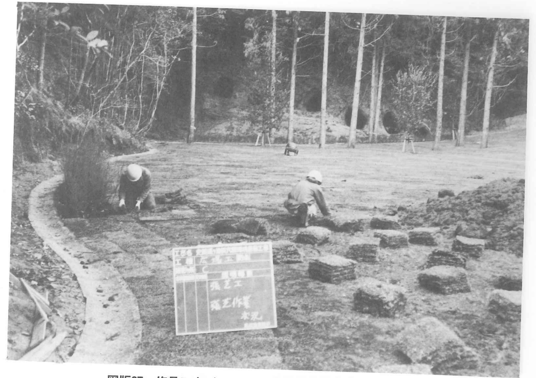
図版67 修景工事 (16号~21号横穴前庭広場張芝作業状況)
