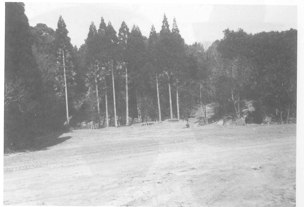
図版76 修景工事 (16号~21号横穴前庭広場完成)
