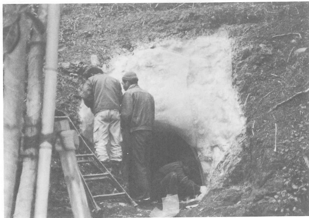
図版58 8号横穴保存工事（擬土貼付前のステンレス金網取付）
