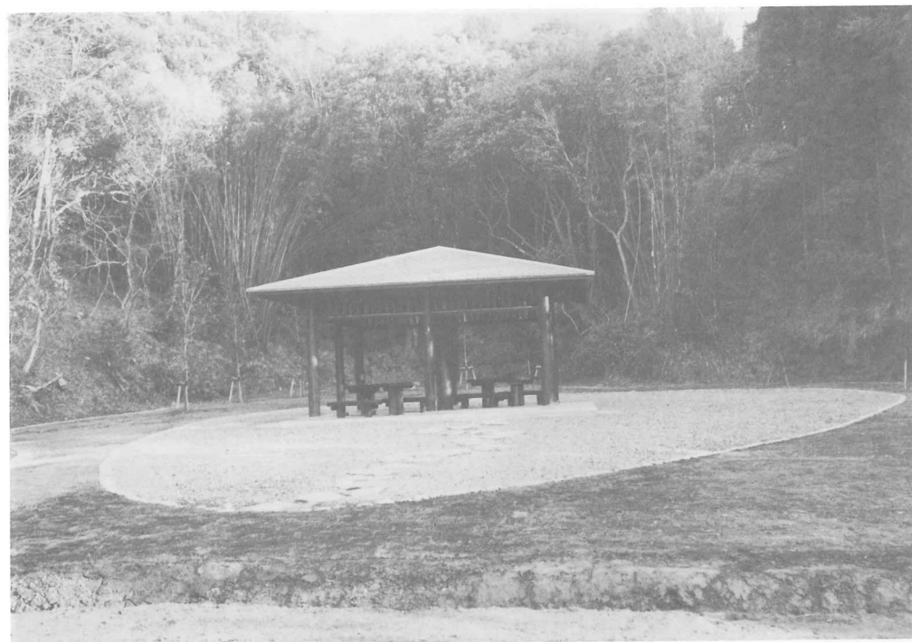
図版74 修景工事 (70号~72号横穴前庭広場完成)
