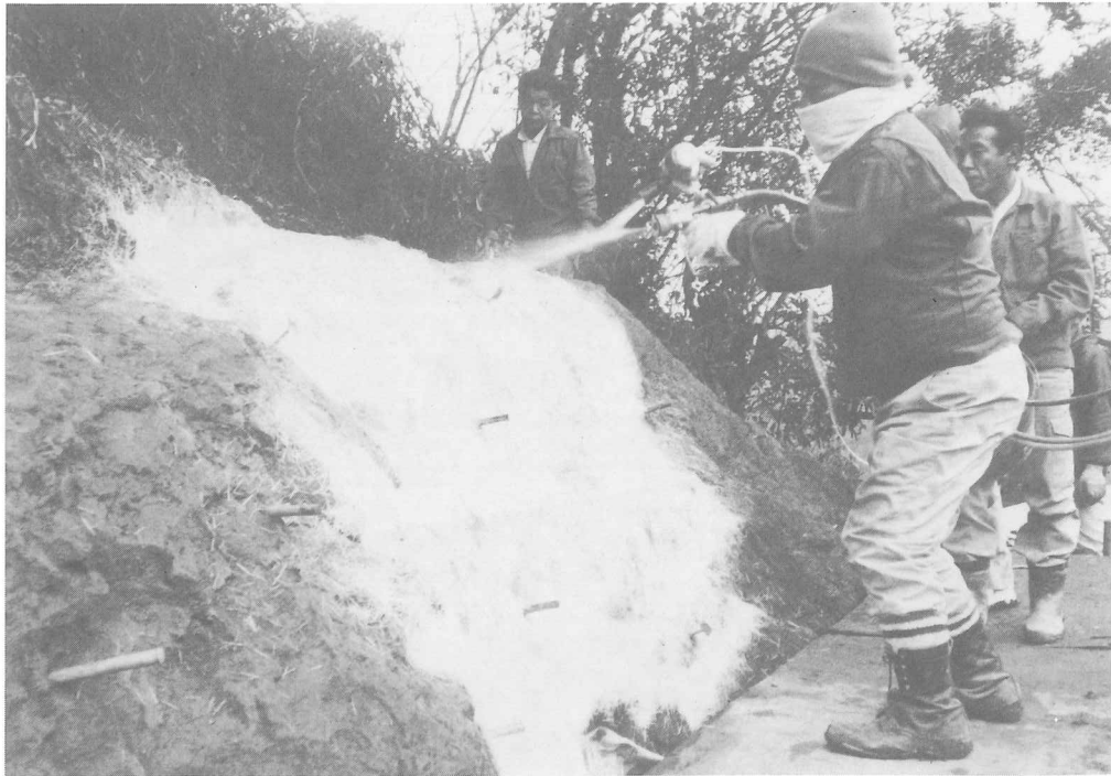
図版49 2号～5号横穴保存工事（下地FRP貼付作業）
