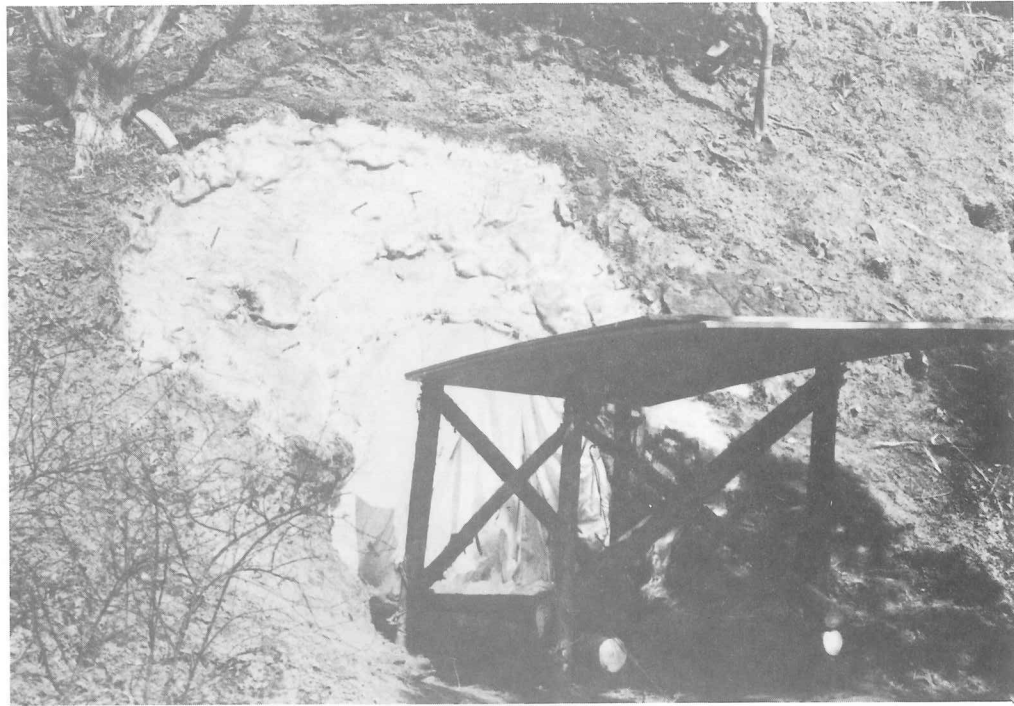
図版61 6号横穴保存工事（下地FRP貼付）
