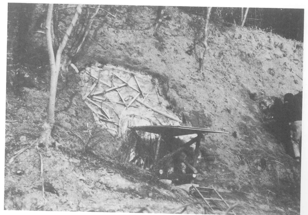
図版60 6号横穴保存工事（下地FRP貼付後のステンレス骨組み）
