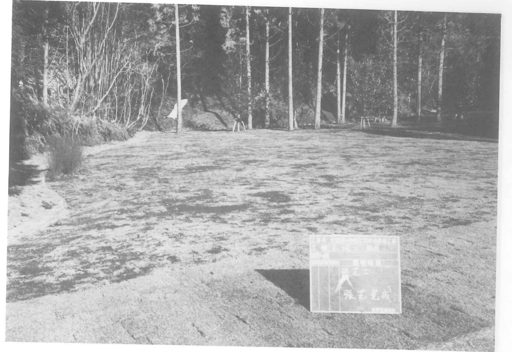
図版71 修景工事 (16号~21号横穴前庭広場張芝他完成)
