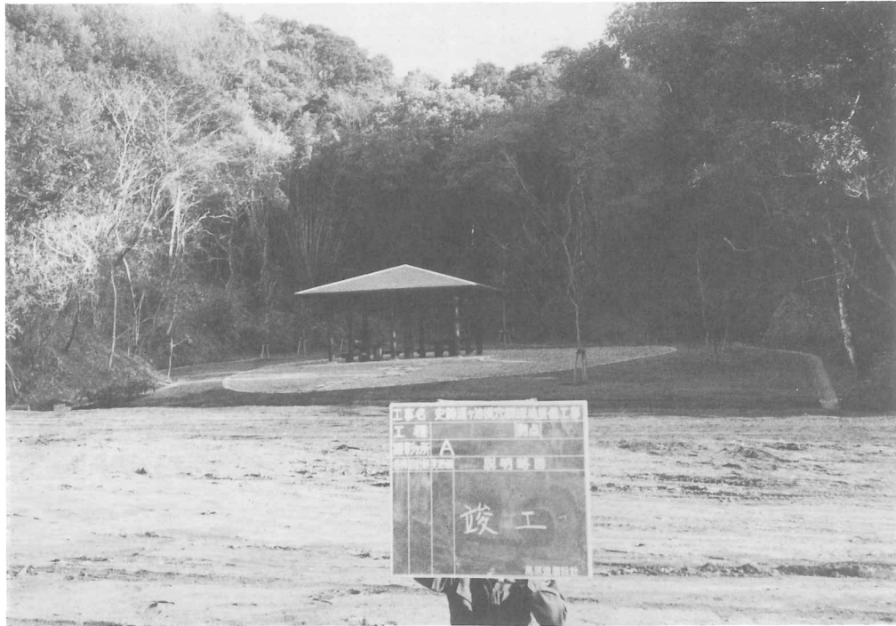
図版69 修景工事 (70号~72号横穴前庭広場張芝他完成)
