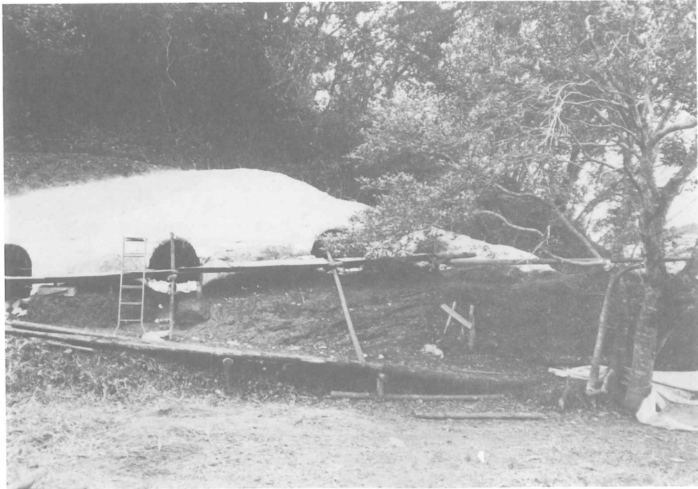
図版53 2号～5号横穴保存工事（発泡ウレタン吹付）
