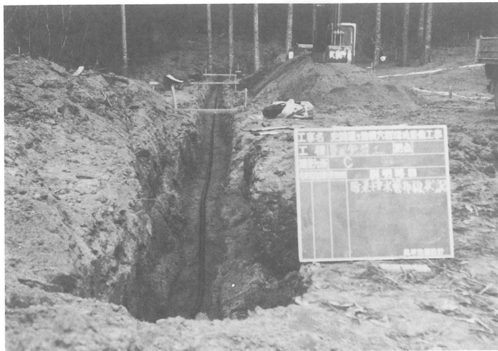
図版66 修景工事 (16号~21号横穴前庭広場暗渠付設)
