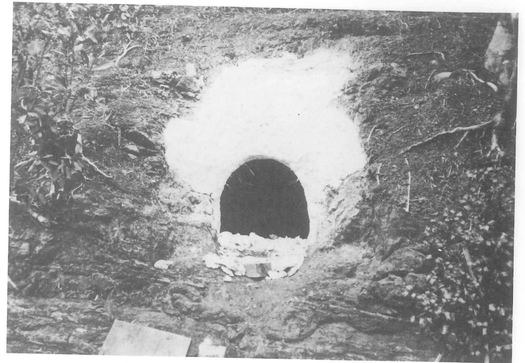
図版59 8号横穴保存工事（発泡ウレタン吹付）
