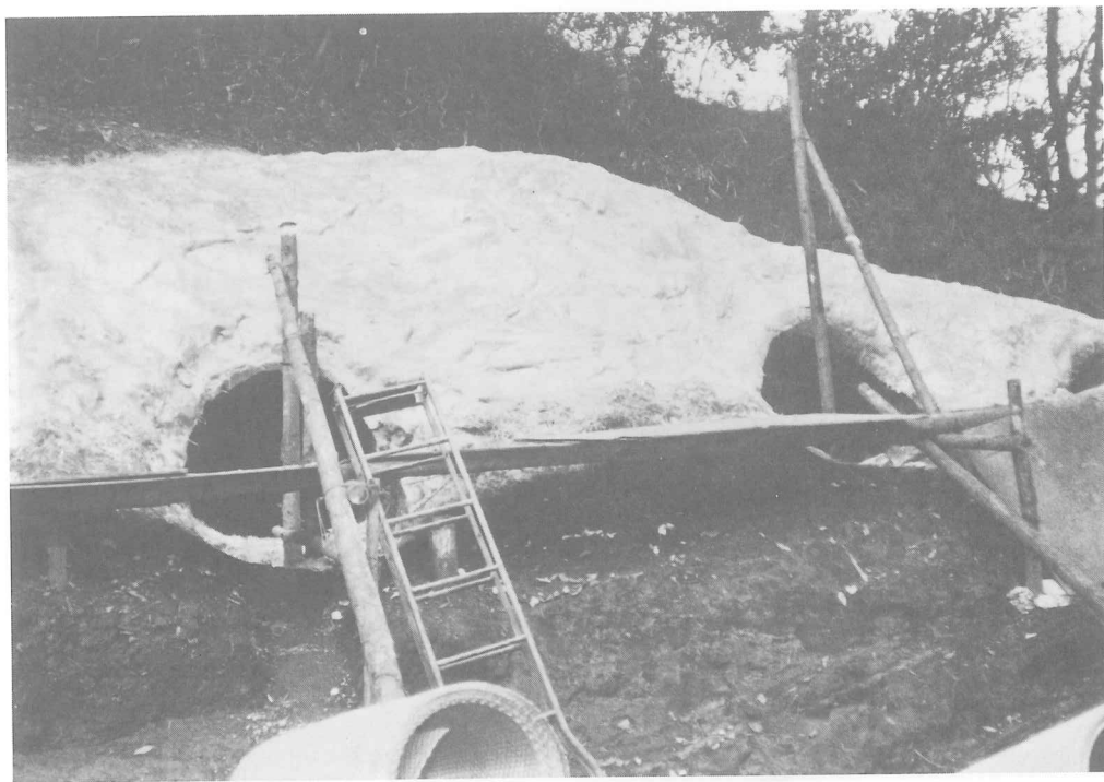
図版54 2号～5号横穴保存工事（発泡ウレタン被覆FRP貼付）
