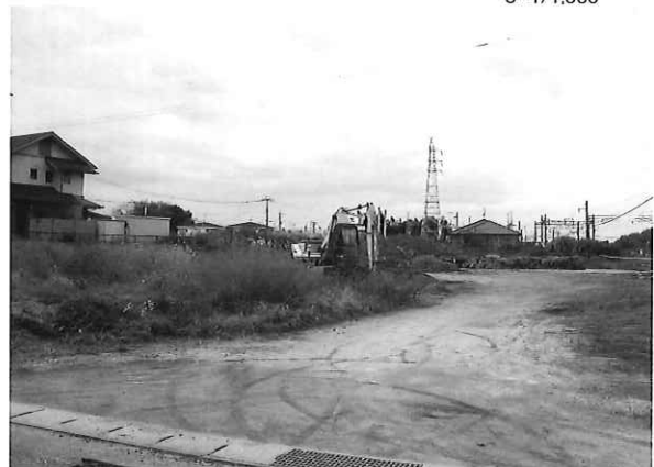
写真49 市道岱明玉名線建設予定地状況
