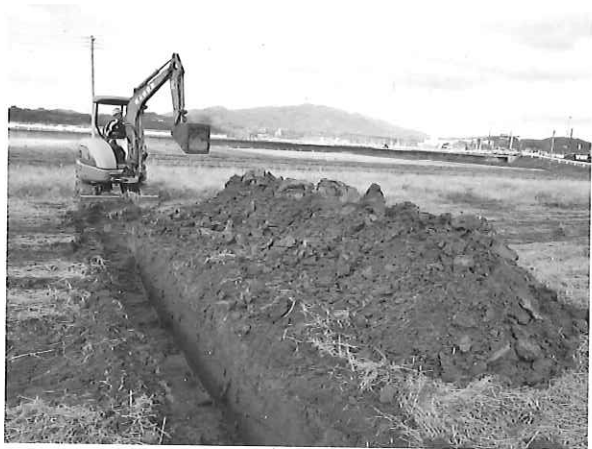
写真1 トレンチ掘削状況
