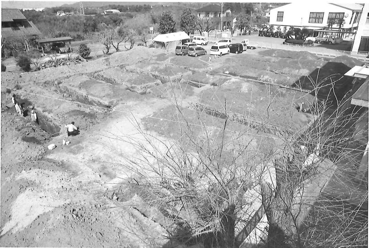
写真52 伊倉宮の後遺跡調査地全景（南西→北東）
