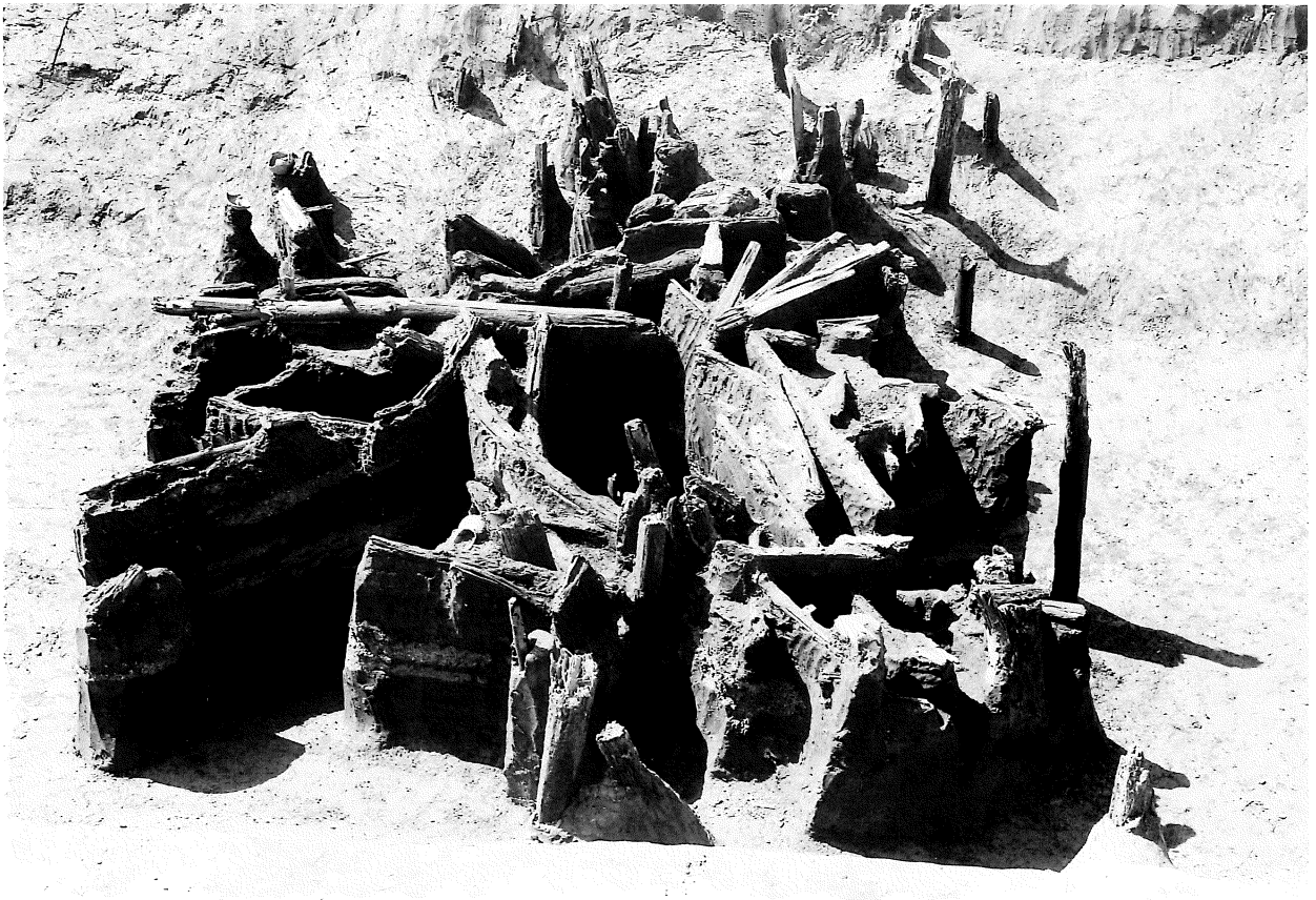
第2号堰跡検出状態（東から）
