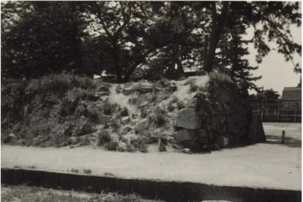
写真3 地震による崩落状況(第1調査区)
