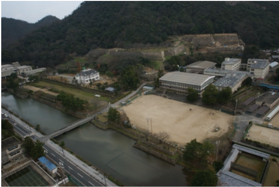
写真1 中ノ御門周辺の現況
