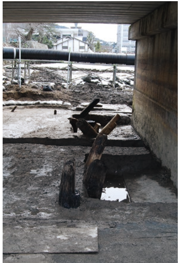
第1調査区柱16~22・66~68(北西から)
