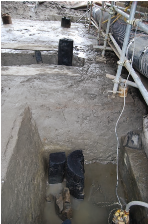
柱群(北西から)
