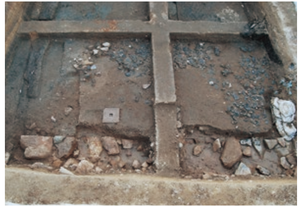
瓦群検出状況 (南東から)
