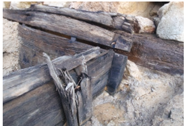
柵外面(南から)
