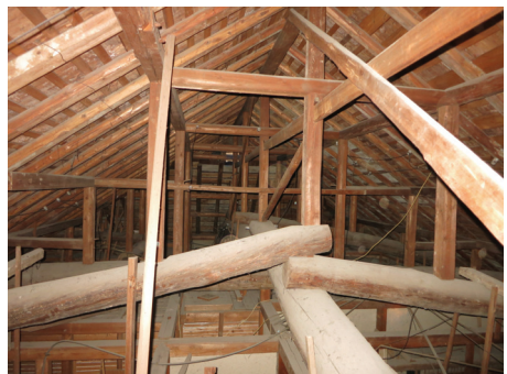
当初建物、和小屋 (金物が使用されていない)
