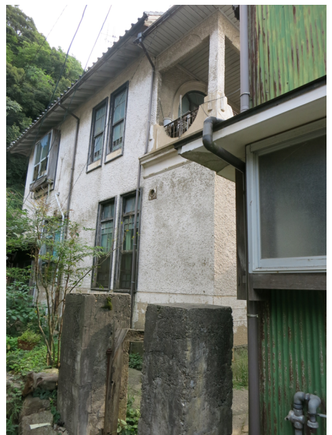
当初建物東面外観
