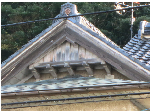
当初建物切妻部 破風板のデザインと持ち送り梁の化粧も優れている
