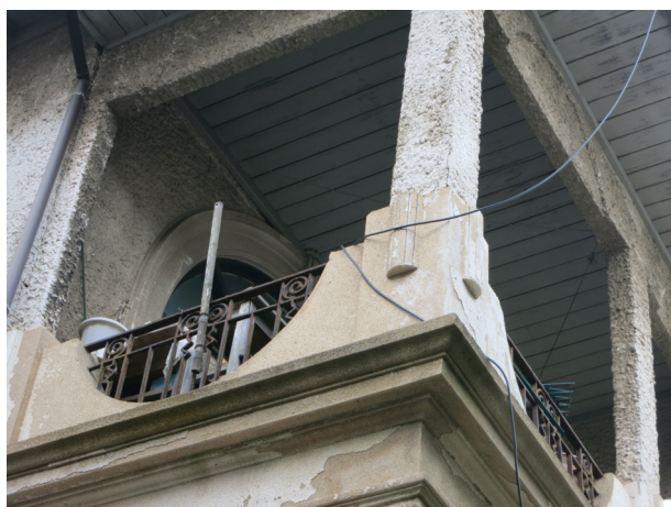
2階ベランダ窓と手摺
