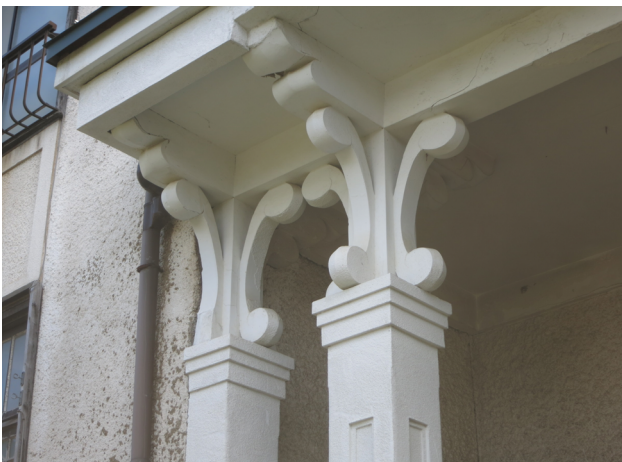
1階ベランダ柱頭飾り
