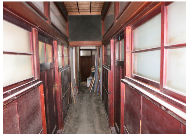
2階廊下の間仕切・明り取り
