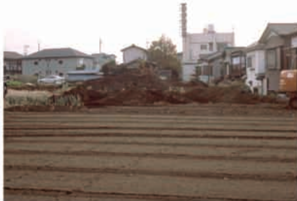
2. 表土剥ぎ風景
