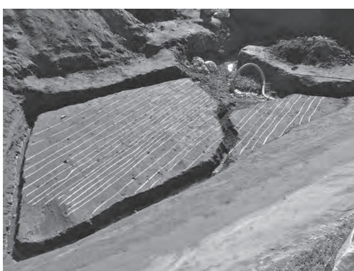
周囲に溝を巡らすことで、掘削面の保水量を低減させた。
