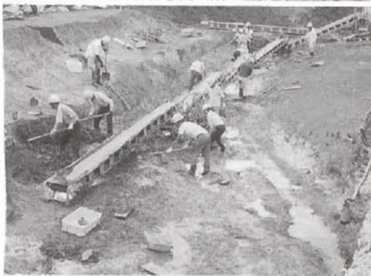
2. 木器出土状況 4. 旧河道掘削状況
