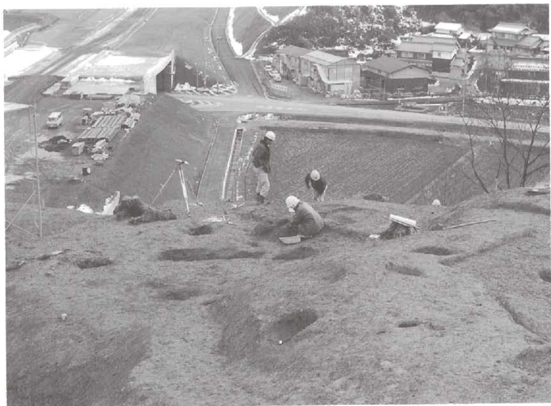
2. 第6郭（2号住居跡）掘削状況 北から
