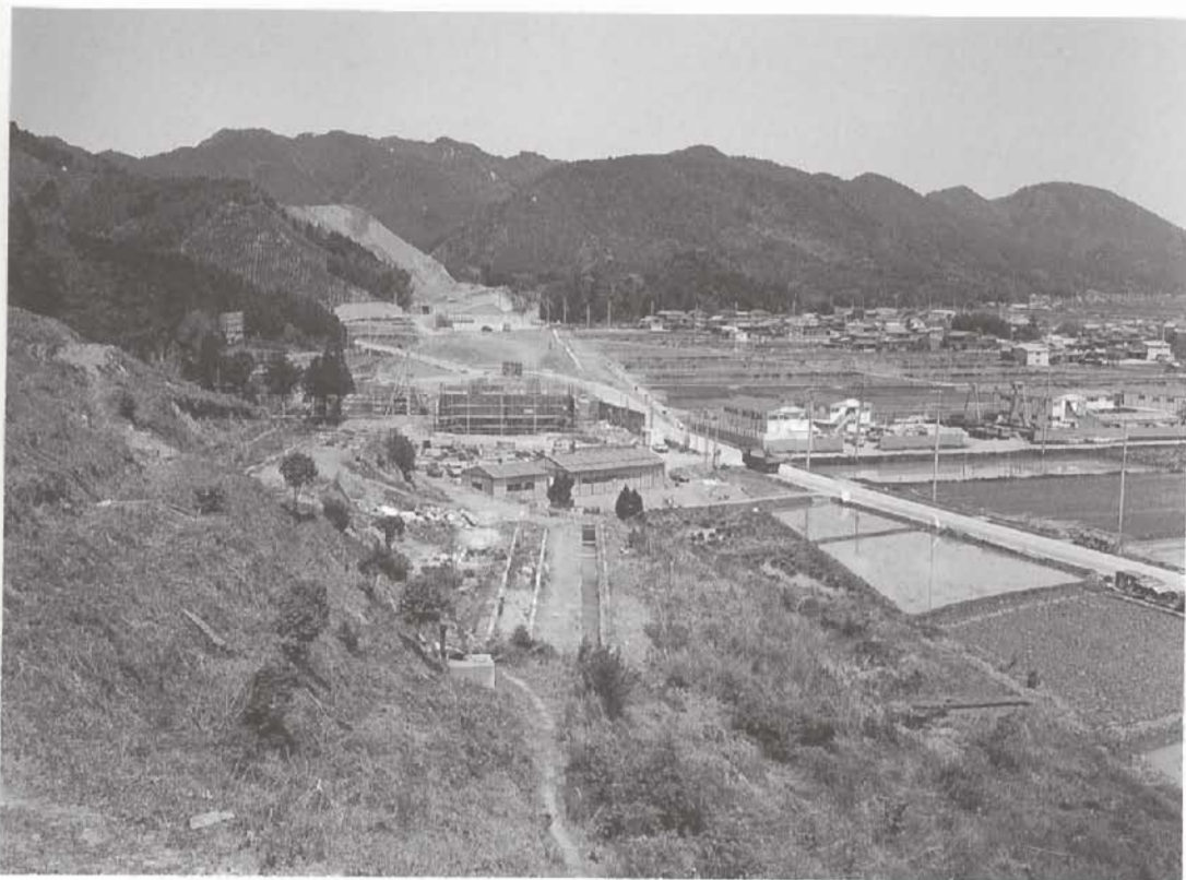
1. 調査前 南から
