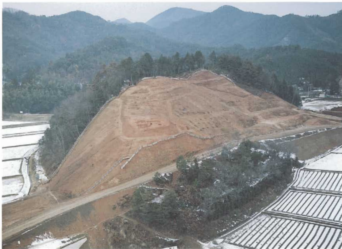
山城跡の曲輪・帯曲輪(南西から)
