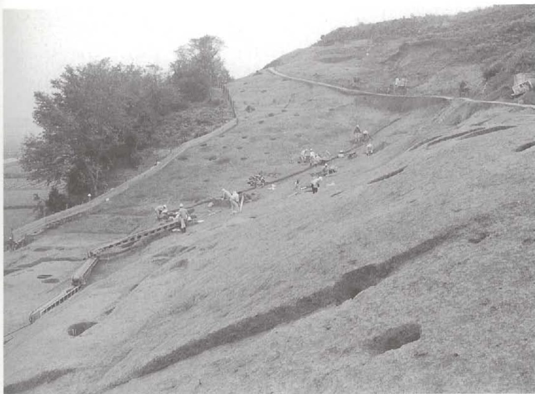
1. 斜面部掘削状況 北から
