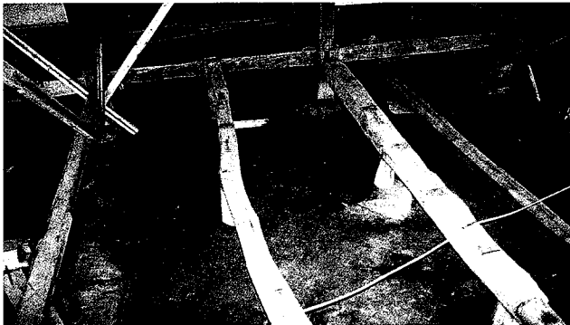
↑南より オゲンカン、オヘヤ根太解体状態。「7」通りには足固貫を差通す
