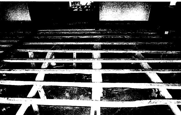
↑南より オゲンカン床板解体状態
