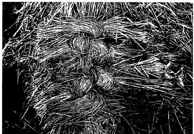
↑東より 藁葺棟の状態。束ねた藁を鞍掛けしている
