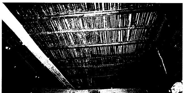
↑東より イマ天井解体、簀子天井の状態。
