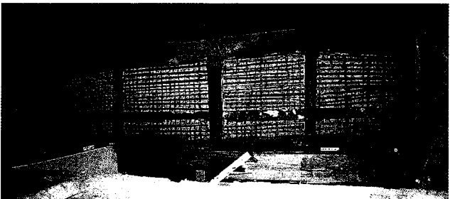
↑南より オヘヤ天井裏北側壁、換気用の下地窓がある。「ヨ」通りの梁端部が残っている
