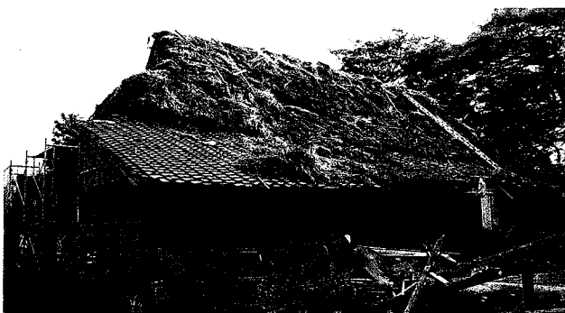
↑北東より 屋根トタン張り撤去、藁葺全景
