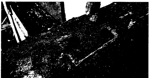
↑南東より 「レ」通り上屋梁の「7」の位置に残る扱首彫りの痕跡。
