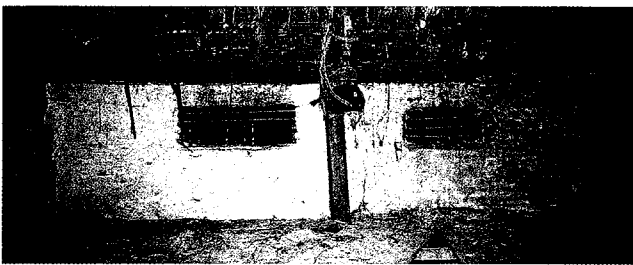
↑南より オヘヤ天井裏北側壁、換気用の下地窓がある。「ヨ」通りの梁端部が残っている
