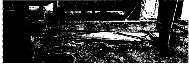
↑西より カンジョウバ根太解体状態。框根太彫り上は色付けされ、床下は柱とも色付けはない
