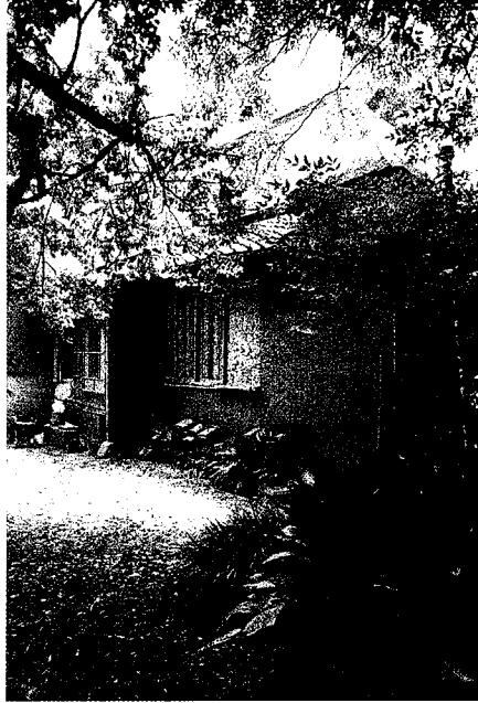
↑ブツマ北西側外観
