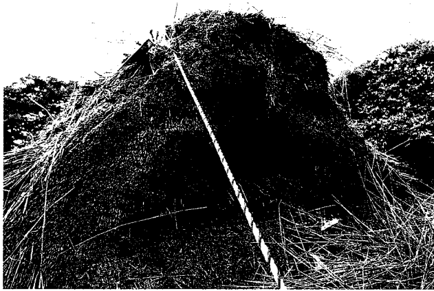
↑南東より 藁葺東側破風の状態
