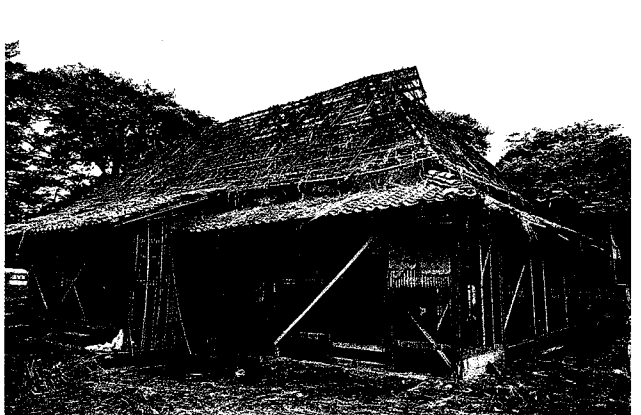
↑南東より 藁葺解体、野地竹組全景
