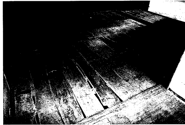
↑北東より ブツマ畳撤去状態
