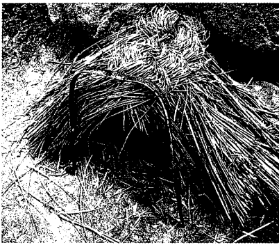
↑鞍掛けしている束ねた藁とコの字状に曲げた押え割竹
