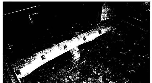
↑北西より オヘヤ根太解体状態。「ヨ」通りの大引
