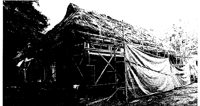
↑南西より 屋根トタン張り撤去、藁葺全景
