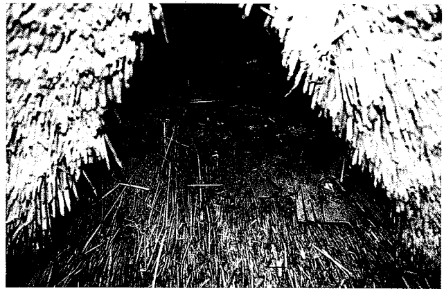
↑東より 藁葺東側破風の状態。破風は妻壁を造らず空気口になり、藁を葺き上げ杉皮を敷き、丸竹で押え、鉾竹に縄搦みし、その奥はコの字状に曲げた割竹を差し押さえている
