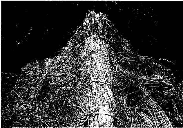
↑東より 藁葺西側棟の状態。藁は下層に稲藁を敷き、上層を麦藁とする
