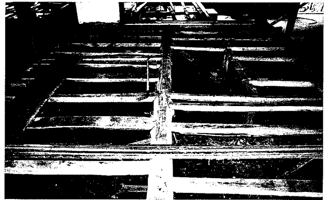
↑南より イマ床板解体状態
