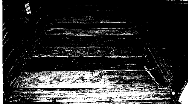
↑東より オヘヤ畳撤去状態。色付けされた床板が混在している
