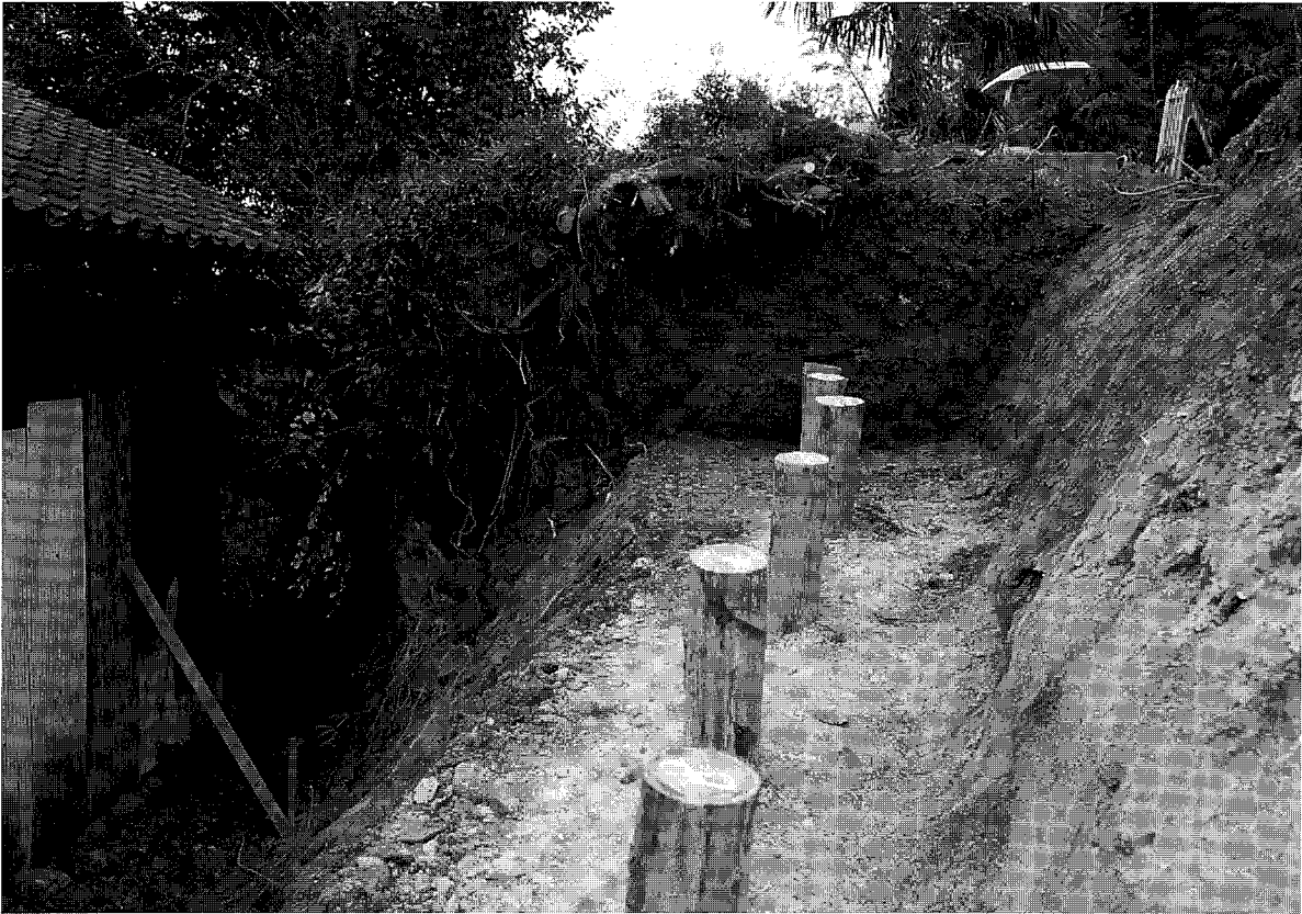
a. 大門遺跡 (大門484-1) 全景 (南より)
