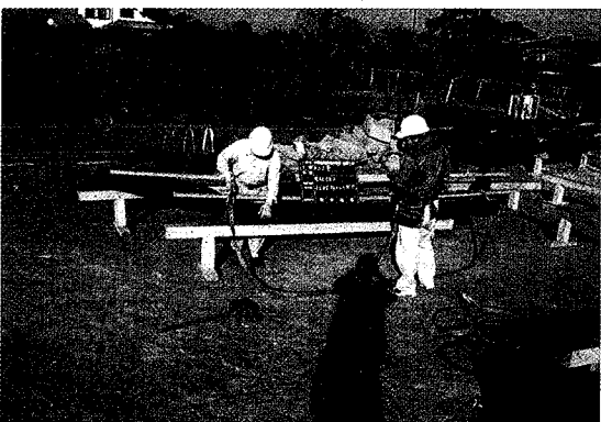
扱首材の下組み作業
