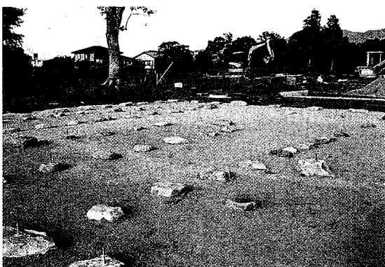
5通りの礎石列と、周囲は土で埋戻し、ボルトで結束
