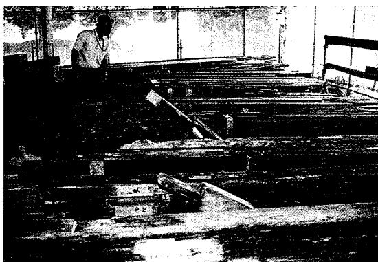
解体材の仕分け
