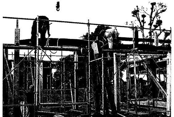
上屋部分 「5」通りの組立て
