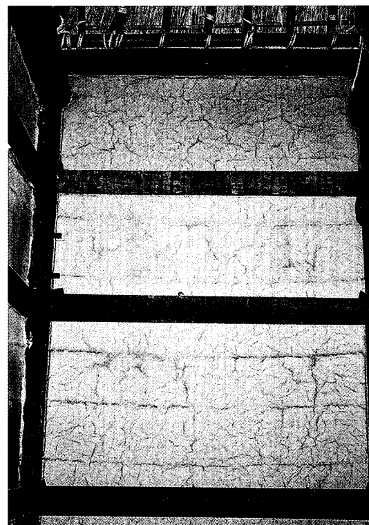
「八」 通り内部より荒壁の乾燥
