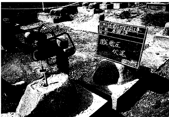
コンクリート布基礎と礎石をアンカーボルトで結束
