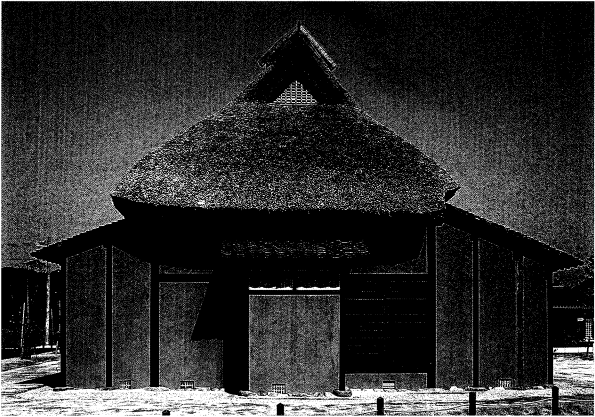
4 竣工 側面（西から）
