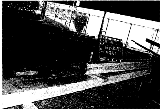
「ワ5」柱 東より下を新材で修理
