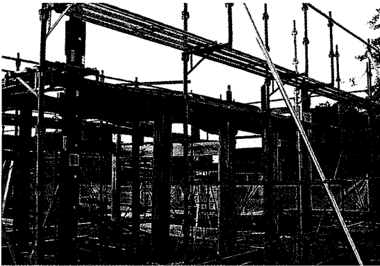
上屋部分 「八」通りの組立て
