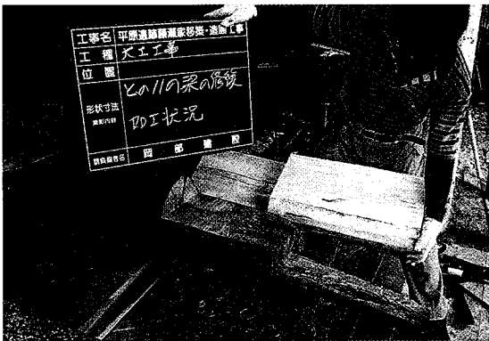
「ト11」 梁端部の修復作業中
