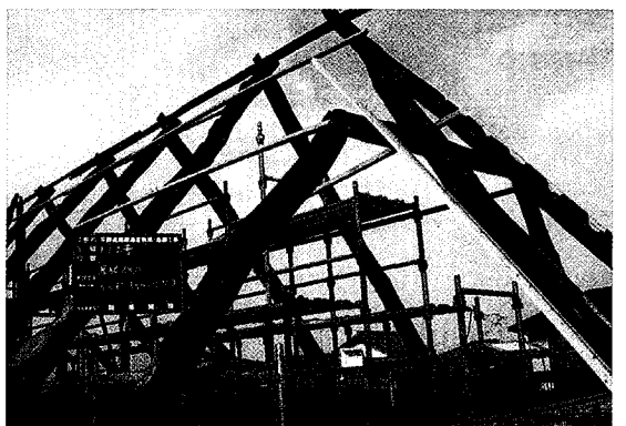
扱首材の建て込み
