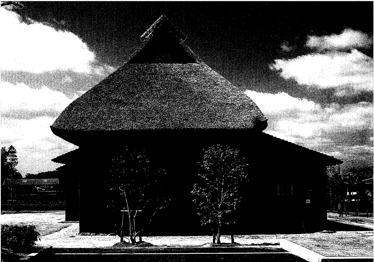
5 竣工 側面（東から）
