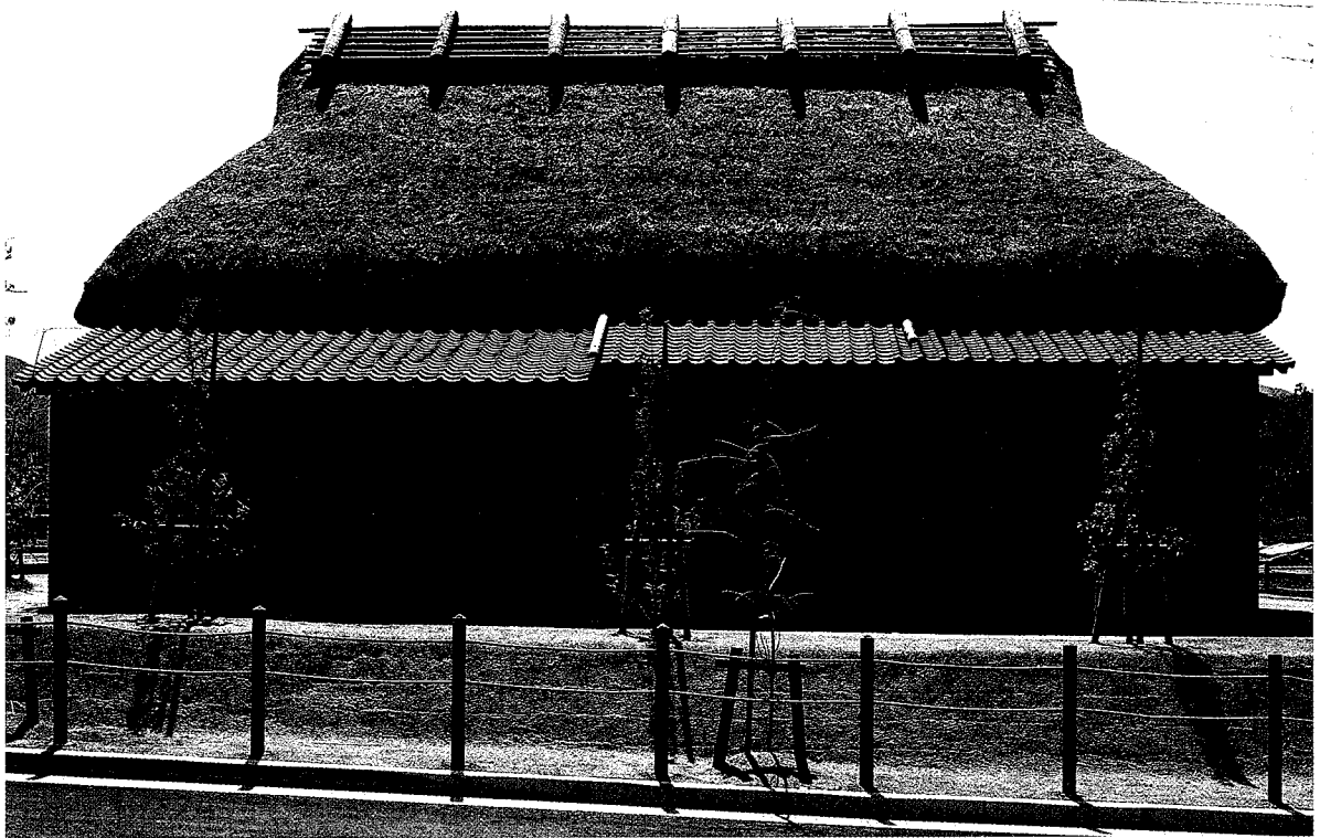
3 竣工 背面（北から）
