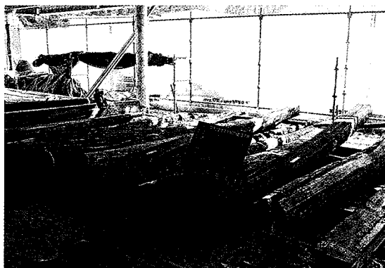
扱首材の現状
