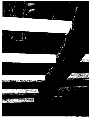
オヘヤの3通りの の梁に根太の痕 跡が確認された
