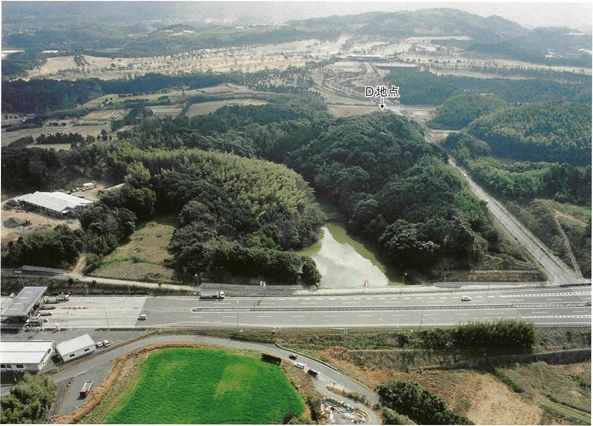
1-1 多久遺跡群遠景（北から）
