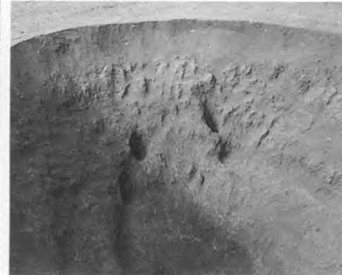
(北西壁の足場状ピットの状況)
