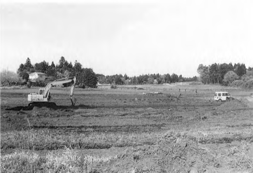
埋め戻し状況（南東より）
