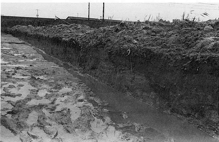
No. 6 トレンチ 断面
