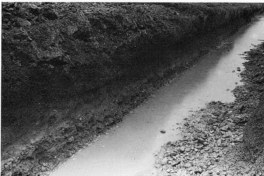
No. 5 - ① トレンチ 断面
