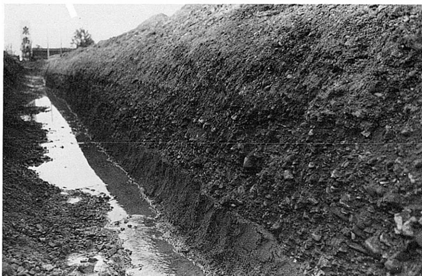
No. 4 トレンチ 断面
