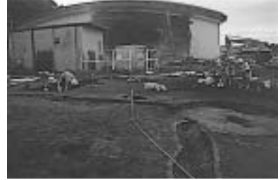
C区作業風景
