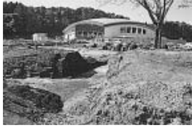
C区作業風景
