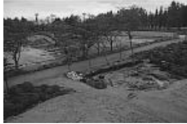
C区作業風景 N
