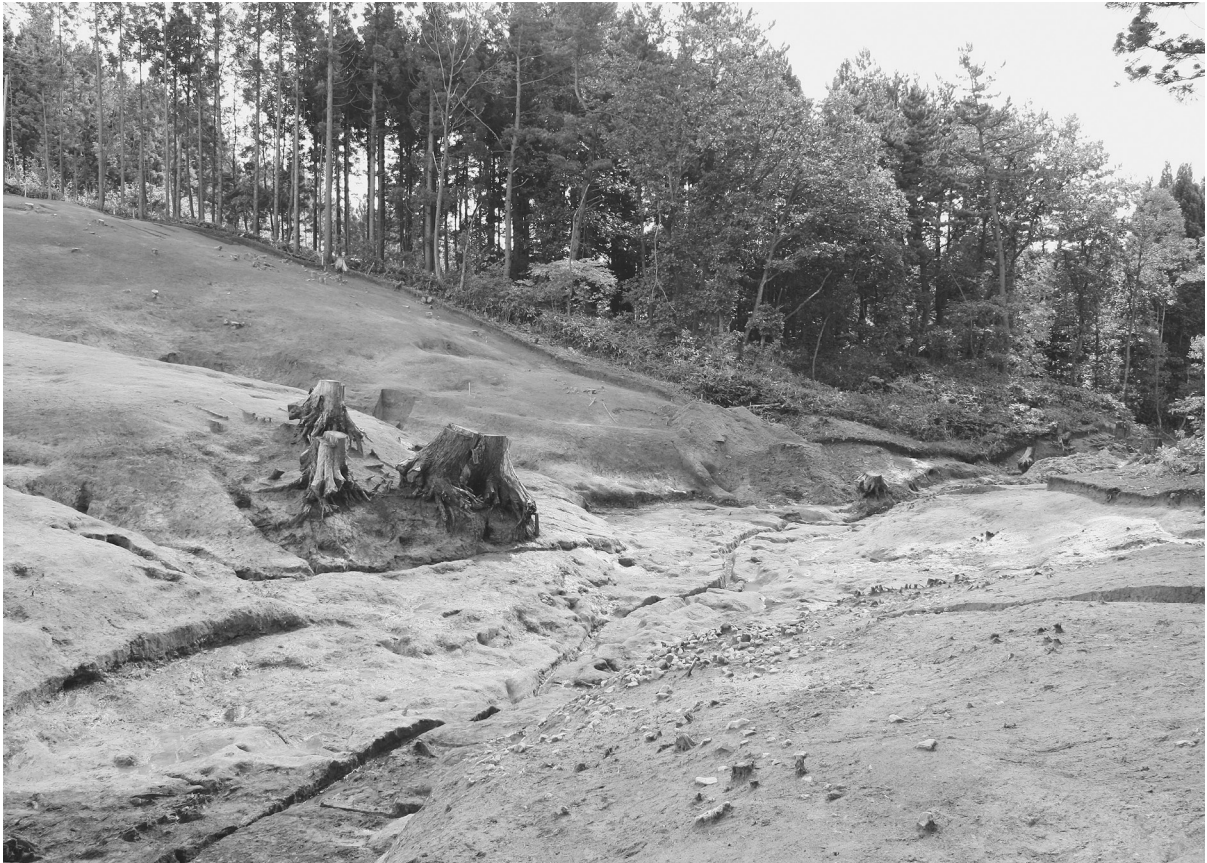
沢本流完掘(中流部) (NW→)
