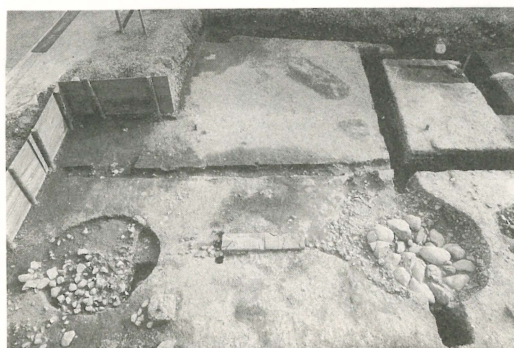
礎石根固め石と地覆石
