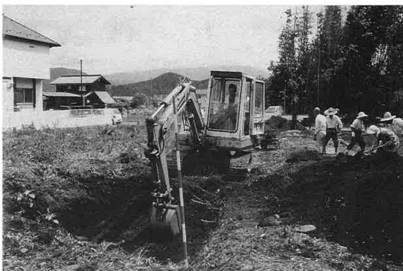
2. 重機作業風景
