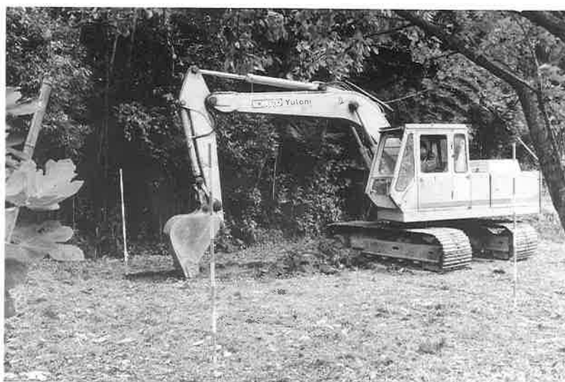
10. 重機作業風景
