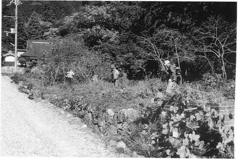
2. 草木除去作業
