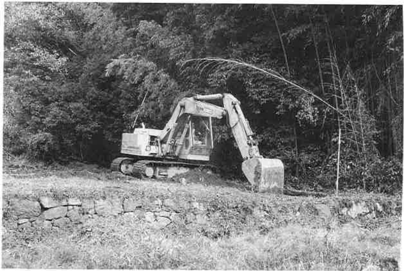
3. 重機作業風景
