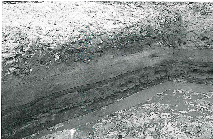
調査区南西隅 B下水田面断ち割り状況 北東から
