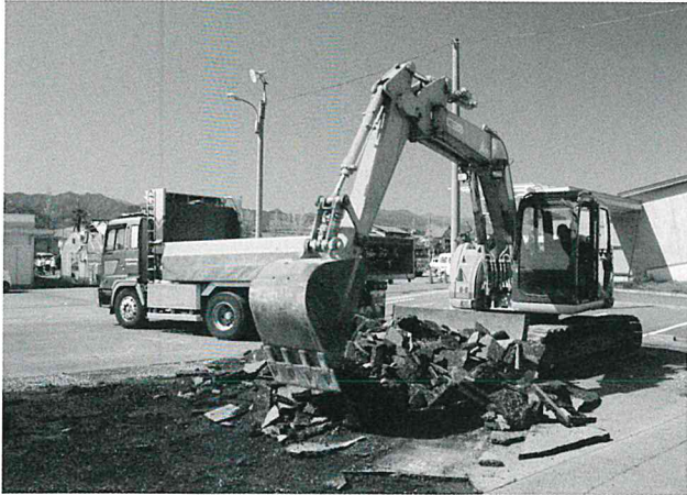
重機によるアスファルト除去作業
