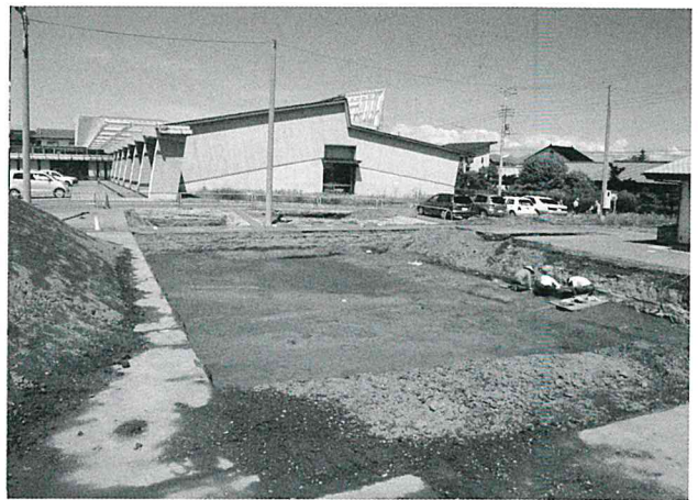
2区全景(東より)
