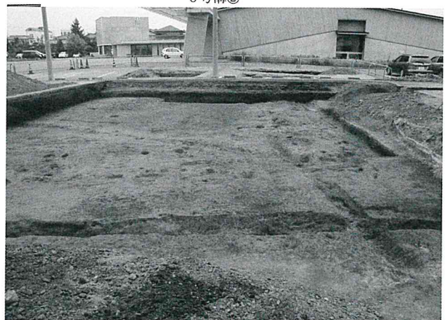
2区完掘状況(東より)
