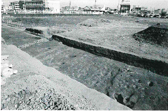
66号溝完掘状況 (南西→)
