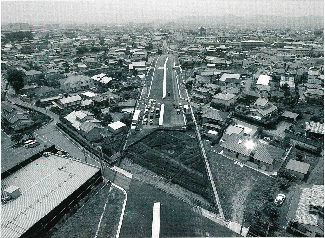
4区 調査区遠景 (北から)
