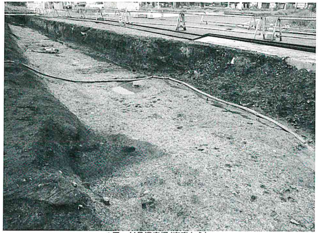
4区 44号溝完掘(南東から)
