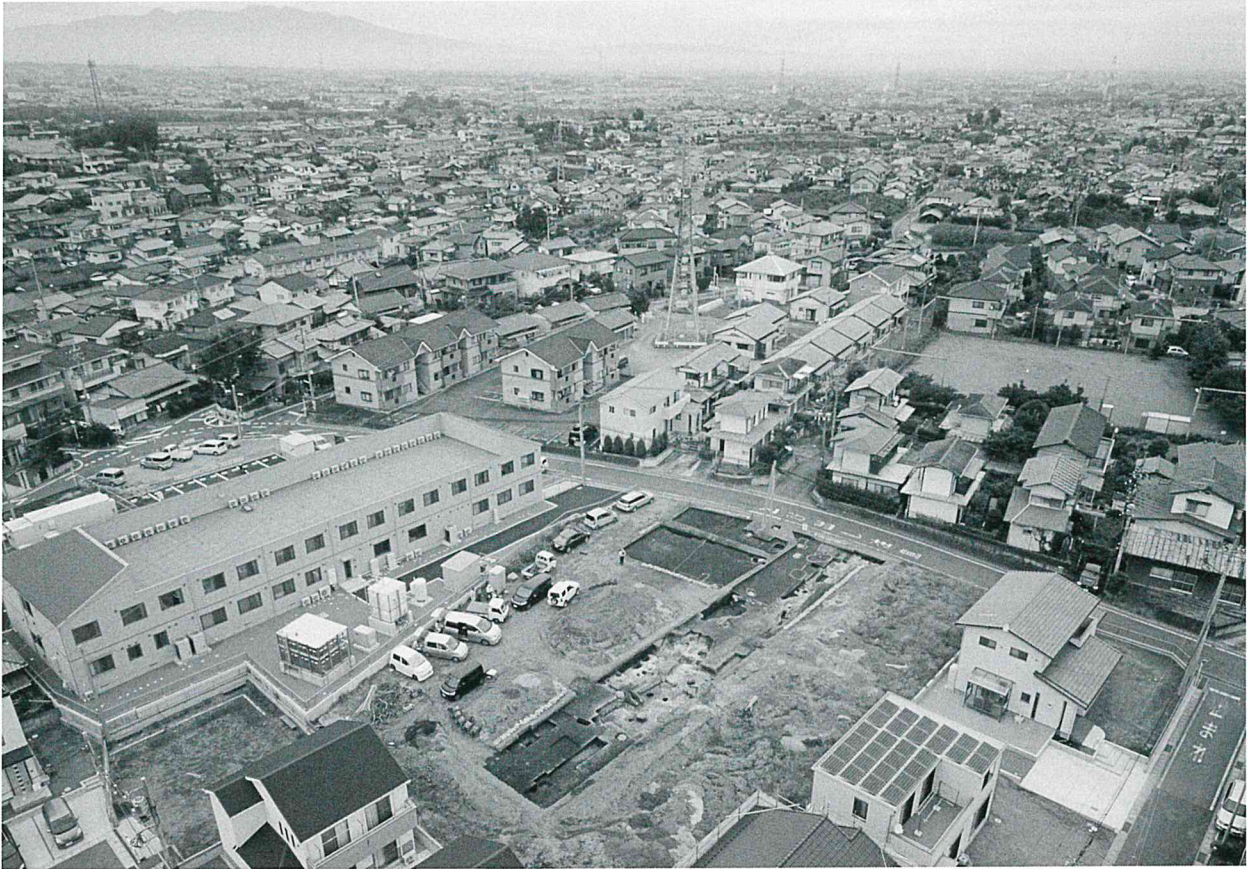
調査区全景 1 (南西から北東方向。中央鉄塔付近が七五三引遺跡。)
