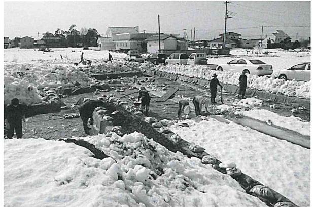
除雪作業風景（北東から）
