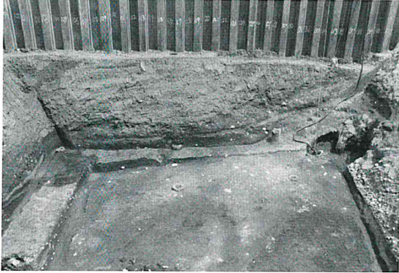
5号溝 SPA-A' (南から)
