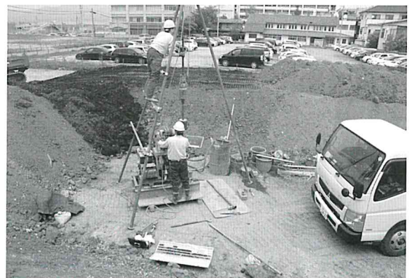
ボーリング調査風景（南から）
