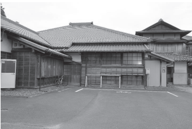
・主屋棟右側面：台所右側面壁の復元 左端は作業場棟。通用口のアルミサッシュが左端に見える。
