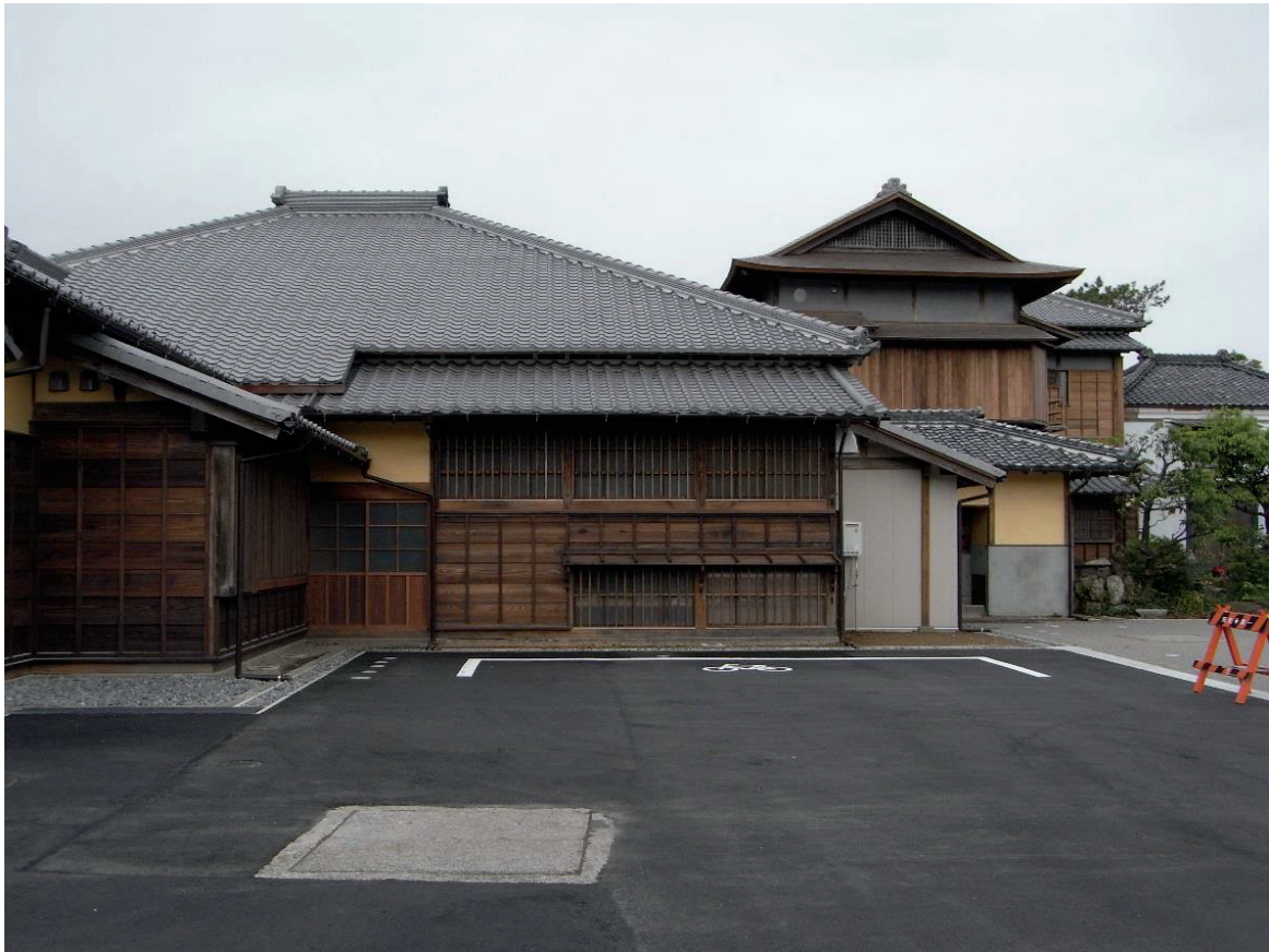
主屋左側面と作業棟背面
