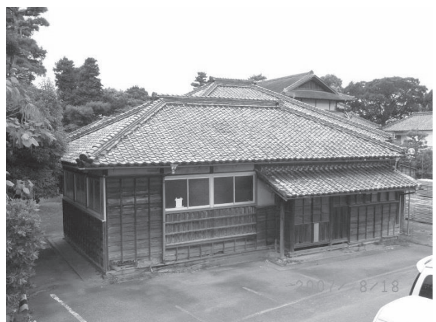
作業棟：工事前の作業棟右側面（修理前） 後方は主屋棟屋根及び「離れ」棟
