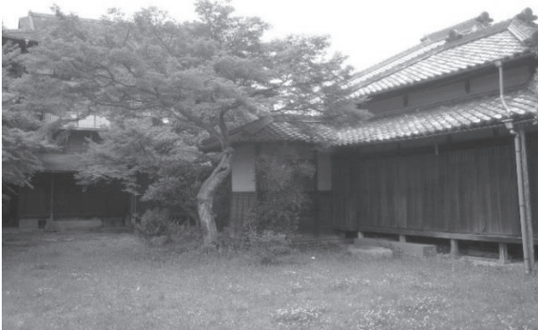
・主屋棟左側：正面左側より見る。 右側が主屋棟。中央は下屋便所棟。 左側樹木の奥が「離れ」棟。
