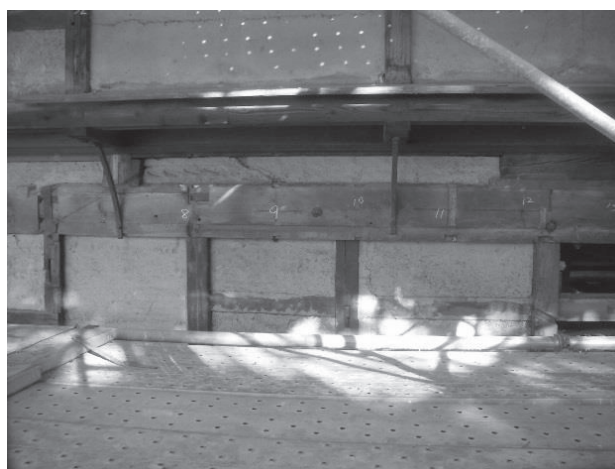
・上記写真の右側部分：1階の柱は既存の状態。旧軒桁の上に2階床を受ける胴挿が2段見える。
