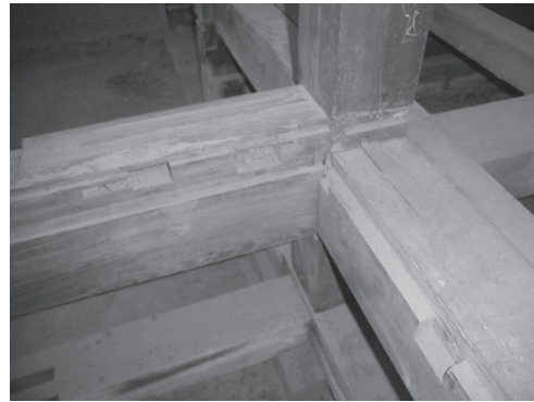
・ 柱に挿し込まれた足固
