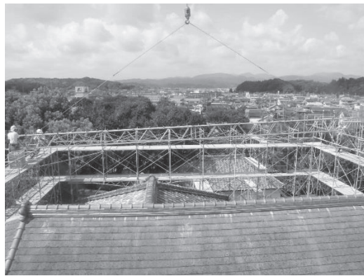
・素屋根大梁の施工
