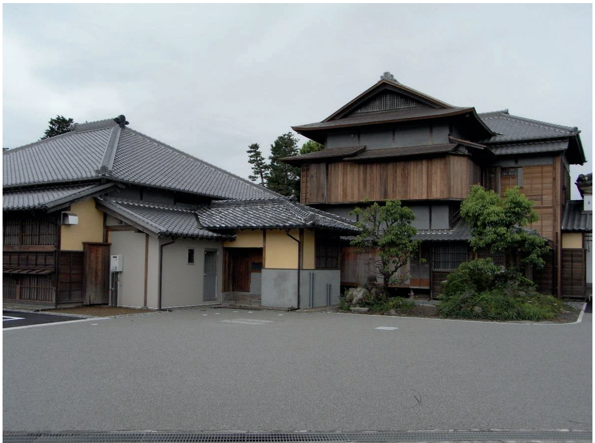
主屋棟と「離れ」右側面
