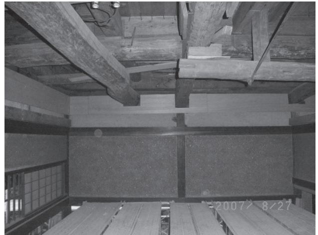
・「離れ」1階座敷天井裏の床梁
