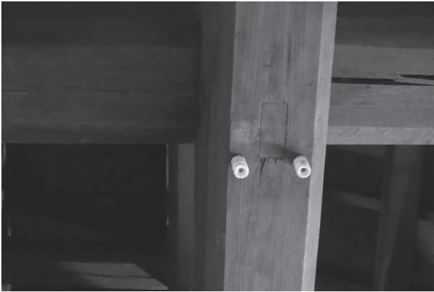
「た-14」の柱ホゾ穴と圧紺 ： 碍子の付く小屋梁が「14」通り
