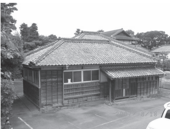
・作業場棟右側面：
