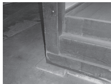
・柱「る-13」：下から土台、上框、畳寄。
