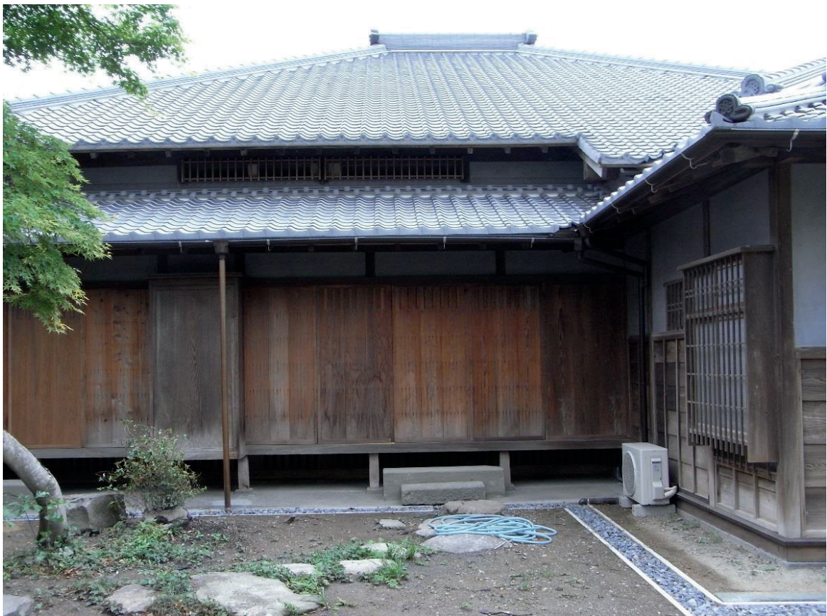
主屋左側面（背面側）と便所棟
