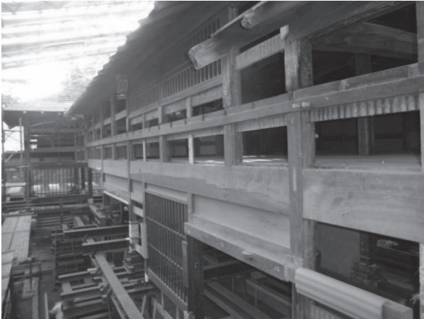
・主屋正面軸組：最右の柱が主屋上屋右端の柱。つし2階窓中央の柱の下の1階には格子窓で、柱がないが、窓下の土台の同位置には旧柱のホゾ穴がある。
