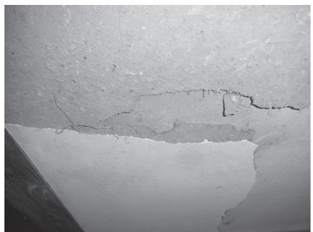
・土塗り壁剥離調査：塗り重ねを薄い筥で矧 ぎ取り、塗り重ね工法と塗厚、土質を調査。
