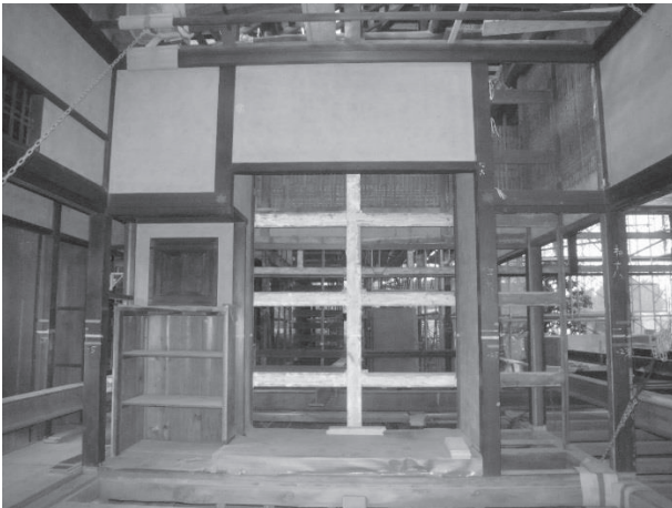
・座敷八帖背面壁：左側に縁側。床の間設え。右端の壁は後補。壁貫を辺付に施工。
