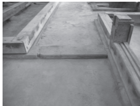
作業場左側の残音痕跡
