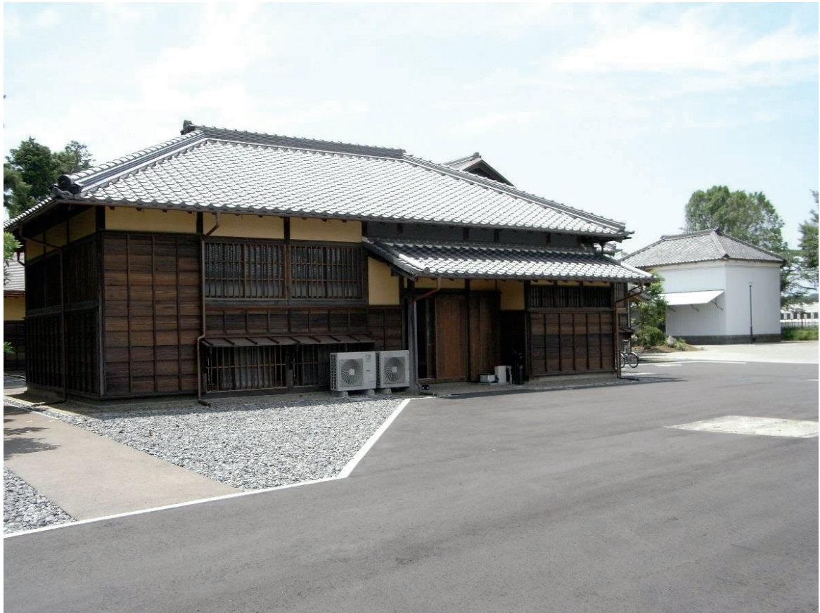
作業棟右側面
