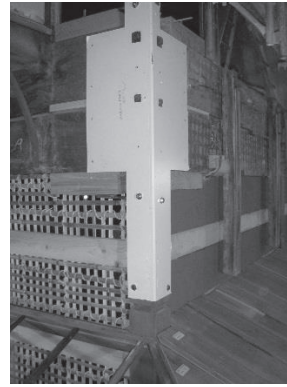
・「離れ」てー26柱 上下柱と胴挿を ST 板で補強
