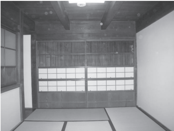
・主屋棟帳場背面：写真正面の簾戸は畳床より低い旧上框に建つ。以前は板間。右端の壁は耐震壁。
