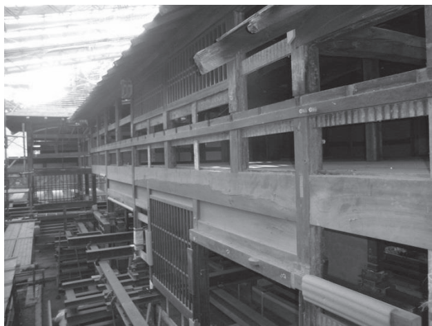
・主屋棟正面軸組：写真中央横材は胴挿。 その上の横材は正面下屋の垂木掛け。
