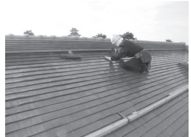
・「離れ」2階屋根：銅板平葺きを桧皮に似せる 銅板平葺き施工の最後行程。桧皮葺きに似せる 為に、銅板重ね部分を若干、箆で浮かせる工法 を採用した。木棒は足場材。
