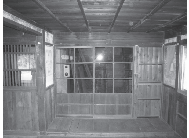
・同 左 左側面背面より：左の建具が左写真の 右側の建具。中央の硝子戸の先は通り土間。 右端の建具は 16 通りでアルミサッシュ。
