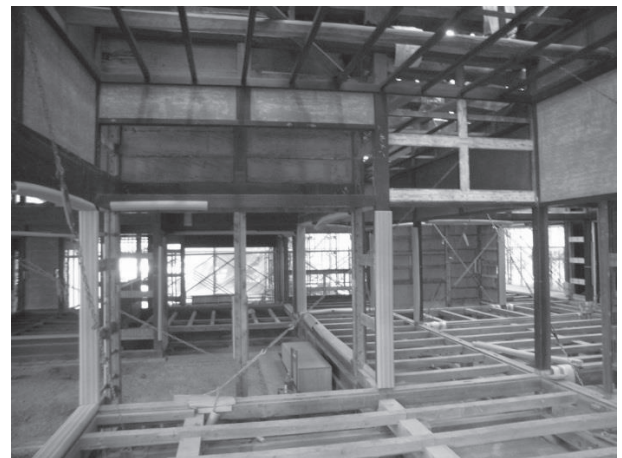
・ひろまと内玄関踏込、座敷八帖：踏石は復原されるうち玄関土間。その先は帳場と通り土間（左端） 背面側より見る
