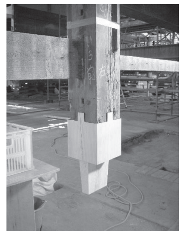
・ 柱「いー3」根継ぎ： 継ぎが短く十字目違い
