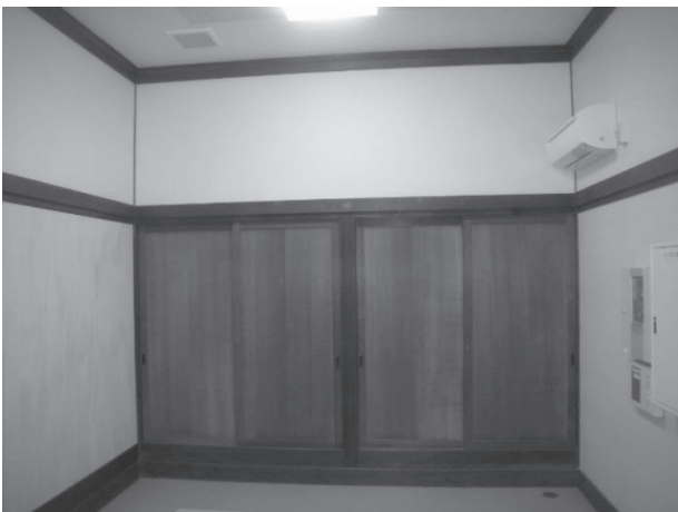
・主屋棟洋間左側面：右側壁は押入であったと推定。左側壁は耐震壁。工事前は右側の建具が施されていた。
