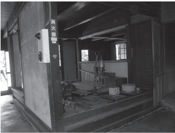
・同 上 帳場背面：土台に上框が乗り、その上奥が後補の畳寄。写真右端の硝子開戸等はシャワー室等で撤去し、内玄関土間を復元。
