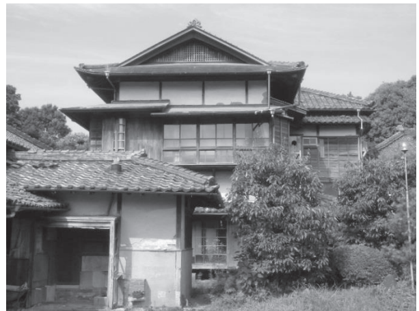
・「離れ」棟右側面：手前が浴室棟。 左端が主屋棟下屋（勝手口）。「離れ」2階 右奥が瓦葺き部分。
