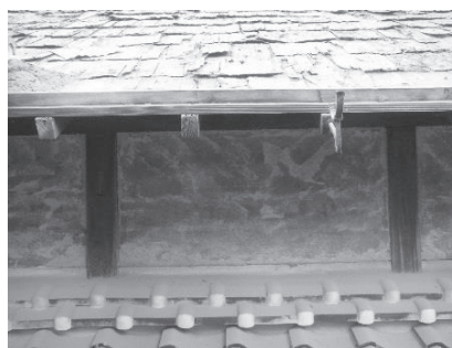
・上屋軒下と下屋屋根間の小壁に黒色が見える。（解体中）
