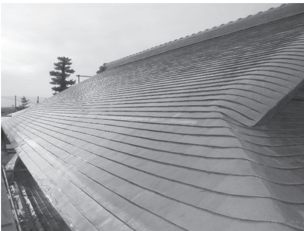
・「離れ」2階屋根：銅板平葺き 銅板に流れ方向重ねは 70 mm 程度 棟は紐付き冠瓦＋紐なし熨斗瓦積み。 鬼瓦は既存写しの新制作品。
