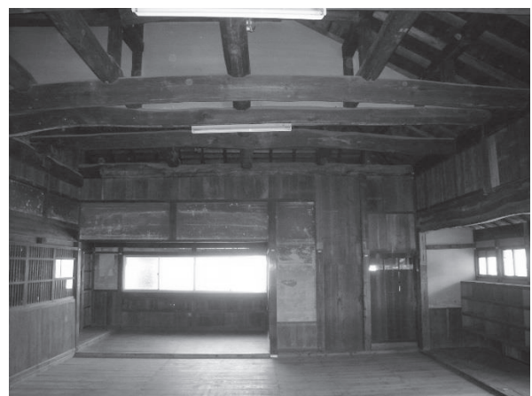
・同 左 背面：解体により、右端の下屋の 正面側半分（写真の窓付近）は後補が判明。 奥が畳 6 帖間、手前が畳 7.5 帖間。
