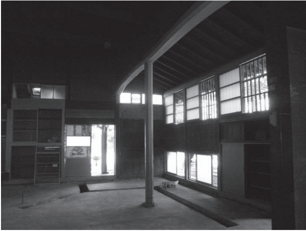
・主屋棟背面側右寄り台所： 高窓と地窓、正面開口部は裏への出口。 中央柱は大きな化粧の土居桁を受ける。
