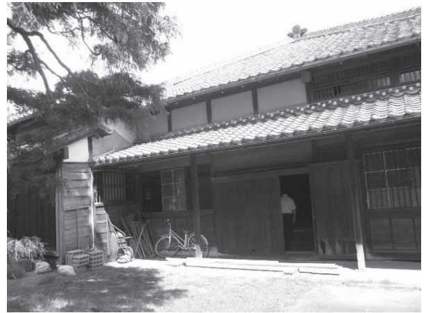
・主屋正面：右側より見る。
