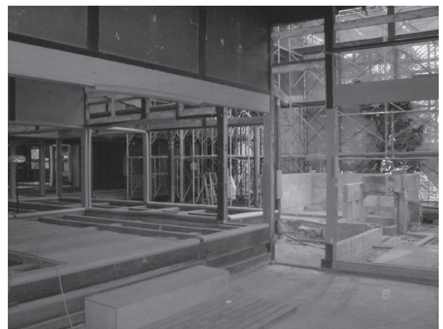
・解体中の主屋台所とひろま：右外部に風呂場石積みの腰壁。台所と風呂場堺の蠅帳や物入は後補で撤去。
