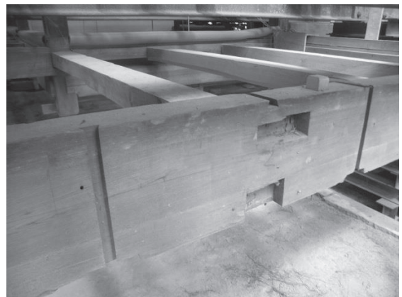
・「5」通りの旧上框下地（上写真は全体、中央の横材が上框、下写真がその部分詳細）
