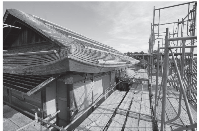
・同 左：軒付は既存桧皮葺屋根の計測値。 桧皮葺きの凹凸感を出す為に3段重ねとした。木の 栈木は葺き足場。銅板の下場から銅線を用意
