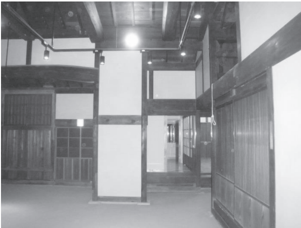
・同 上 右側面（正面側）：中央壁が新設の耐震壁。その右は作業棟の化粧室（旧6帖）。右端は帳場。
