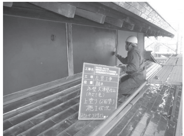
・「離れ」2階外壁仕上げ塗り：黒大津壁鍍2回塗り。黒土は伊勢黒や小牧黒と呼称される大津土があるが、現在では入手不可能と聞く。
