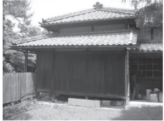
・旧正面左端の南縁側
