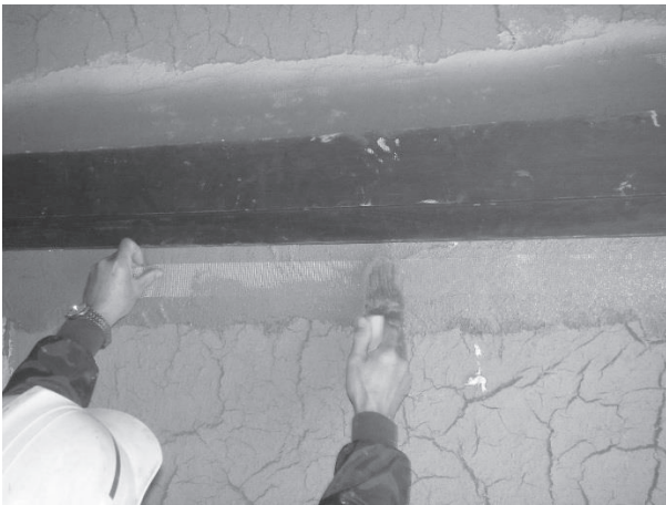
・同 上：壁脇の引けとひび割れを防ぐ為に寒令紗状の布を伏せながら斑直し塗りを施す。ひび割れ面は荒壁。長押上方は壁脇の施工が終了し薄塗部分が乾燥し始めた。
