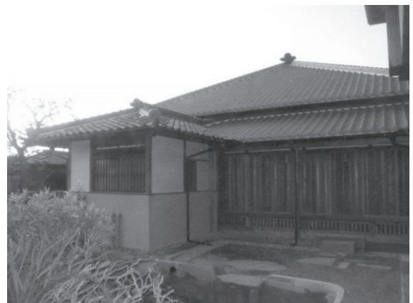
・主屋棟背面：左側の小屋根が下屋の風呂場。 風呂場の腰壁は切石積みでモルタル鏝仕上げ
