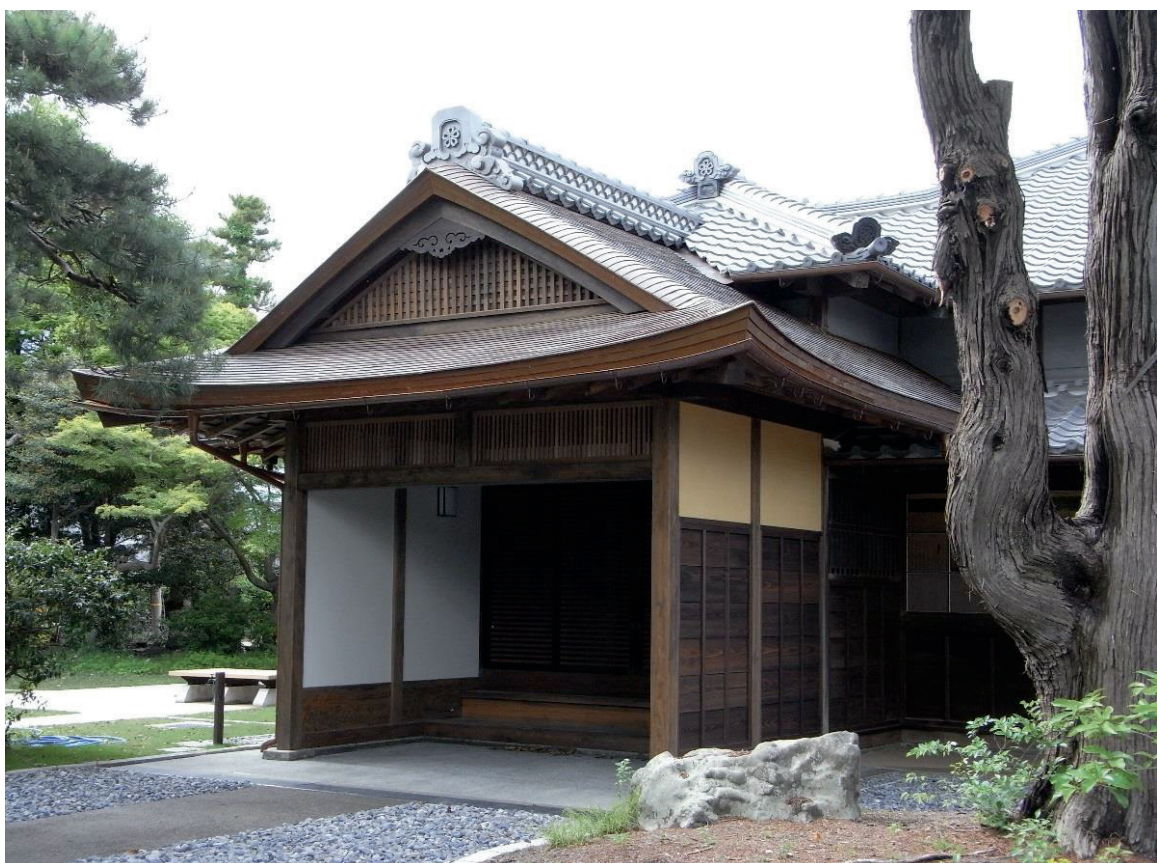
式台玄関 主屋左側
