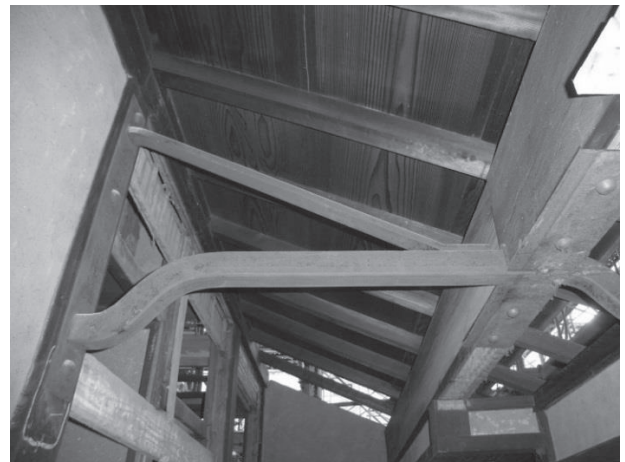
・「離れ」1階東縁側上部：2階張り出しの縁側 を支える補強持ち送り鉄材。旧縁軒桁の先まで 延びる2階縁を支える。
