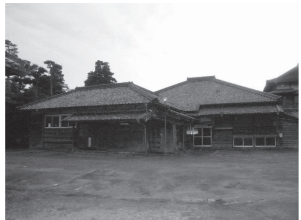
・作業場棟及び主屋棟右側面：
