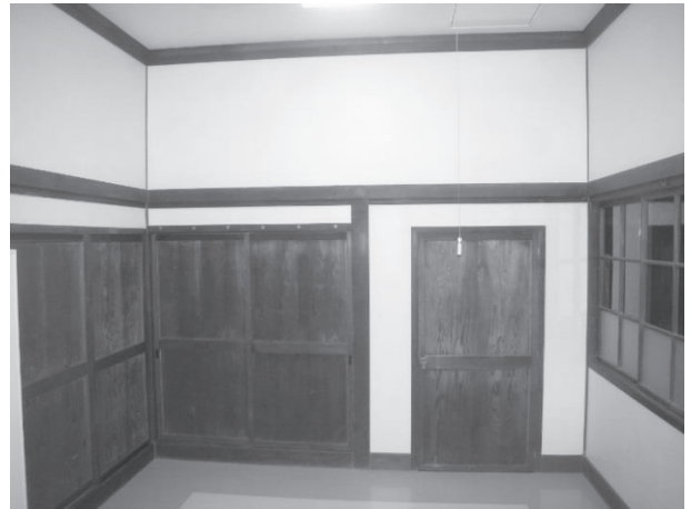
・主屋棟洋間：以前は帳場であろう。床は5寸上で板間であろう。この室の天井に金唐紙が貼られていた。右端の窓が以前は掃き出し窓である
