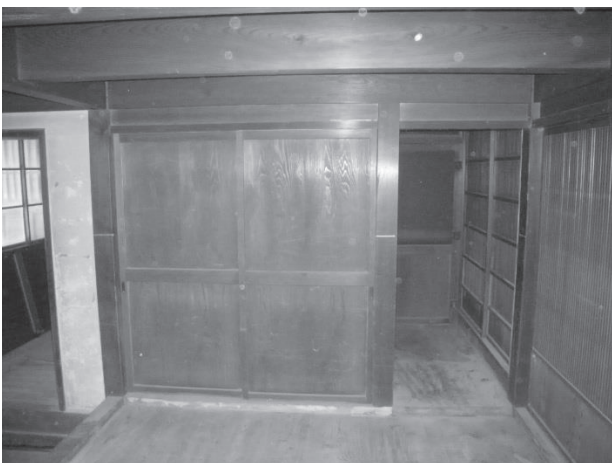
・「みせ」左面：建具の奥は洋間。左端の開口は「みせ」の洋間出入口。右奥の硝子開き戸は電話室。「みせ」の床より洋間の床が低いのが見える。
