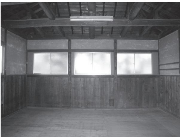
・同 上 正面：旧作業場は天井が張られず、 小屋組が見える。腰壁が板張りで土間床まで 張られている。正面窓はアルミサッシュ。
