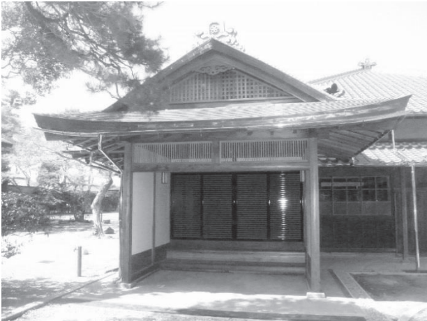
・復原した式台玄関：復原資料は旧写真と主屋棟の小屋裏や柱に残存する痕跡に拠る。
