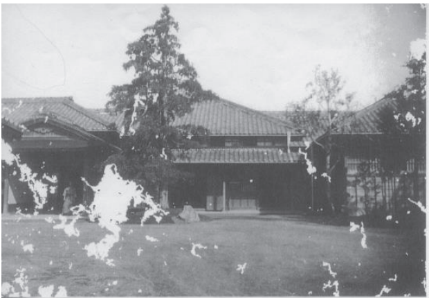
・式台玄関の旧写真
