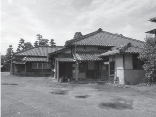
・作業場棟及び主屋棟背面： 右端が浴室。中央が主屋棟、左側が作業場棟。 浴室壁は黄大津。
