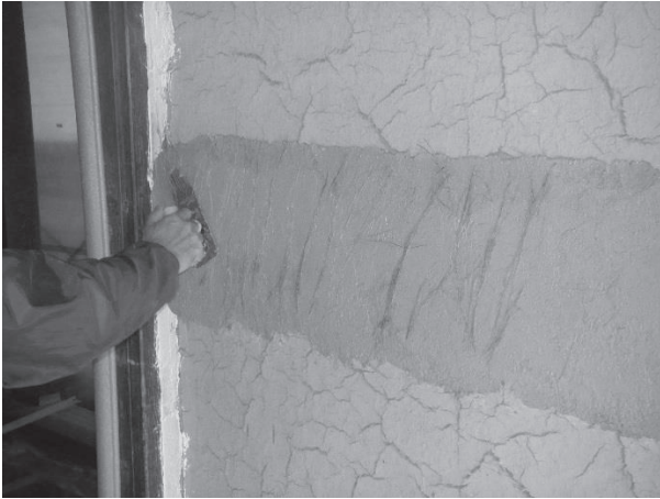
・土 壁：中塗り前の貫伏せ塗り。木肌が露出する貫の上に、貫巾の3倍程度の範囲を伏せ藁を用いて塗り伏せる斑直し塗り。
