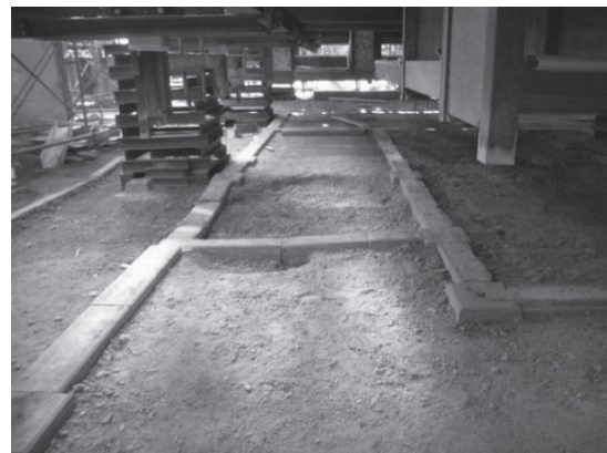
・正面「みせ土間」の柱石と布基礎（揚屋状態） ：概ね堆積岩（伊豆石）の切石。大半は再用可能。 写真中央は一部地面が陥没している。
