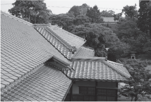
・背面側から見た主屋左側面屋
