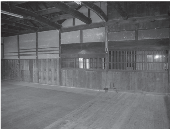
・同 上 左側面：中央部がかつての土間床へ の出入り口。右側の内法が中央より高いのは 写真右側の床が左側より高い事を示している。
