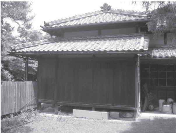
・主屋棟正面左側：正面から見る。
