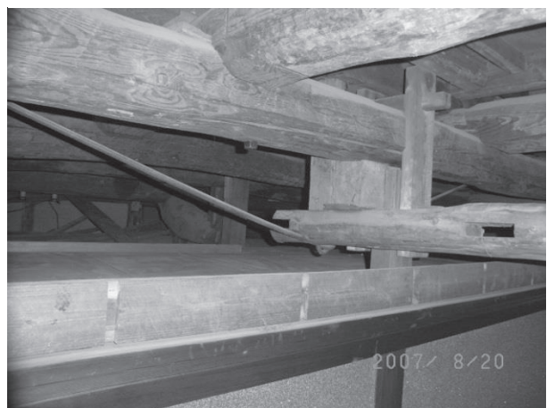
・左記写真の端部：束受けの架かる梁は旧小屋梁 同小屋梁の上に架かる材も旧小屋梁。それ等の下方の鉄筋で吊った小梁は小屋梁補強であろう
