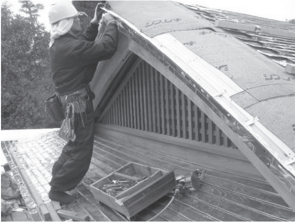
・復原式台玄関屋根葺甲：銅板平葺き施工 銅板は厚さ 0.4 mm。
