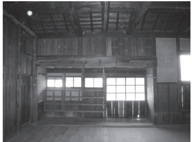
・同 左 右側面中央部：後補の挿物で下部の 柱が省略されているのであろう。板張り床の下 にコンクリート土間が広がる。
