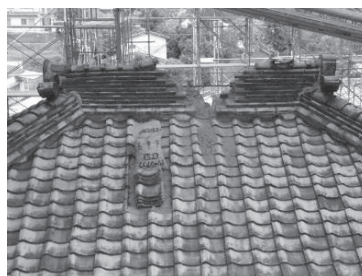
・解体工事前の調査
