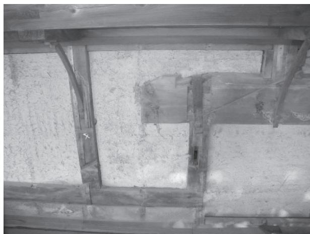
・「離れ」棟左側面中央：1階と2階の堺に旧軒桁が残存し、旧背面側の軒桁掛鼻の痕跡が見える。
