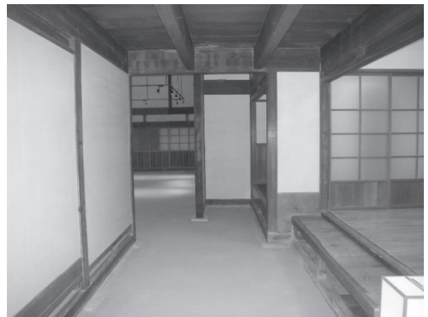
・主屋棟通り土間：写真中央の柱筋が作業場棟との境。右側の板間（作業場棟）は当初は畳敷。中央壁及び左側壁（帳場左側面）は耐震壁。床は現代風三和土（たたき）。
