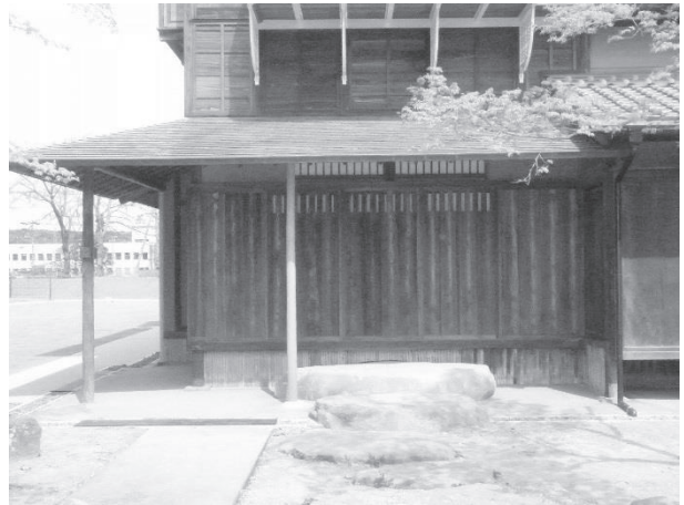
・「離れ」正面側：上部の鉄製バルコニーの持ち送りが見える。1階座敷雨戸の無双は既存。
