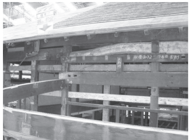
・主屋背面壁下地：下屋の垂木掛けの下部の貫は白 色で、上方の半割の土居桁も白色である。垂木掛 け直上の貫は木舞が外部側の為、切り替えし塗りが 施工されず、土色である。その左方の貫も同様 である。この貫には木舞の跡が見える。
