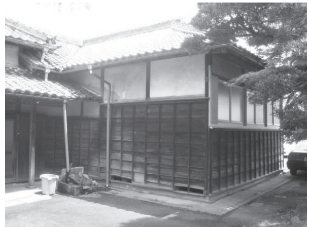
・作業場棟左側面及び正面：
