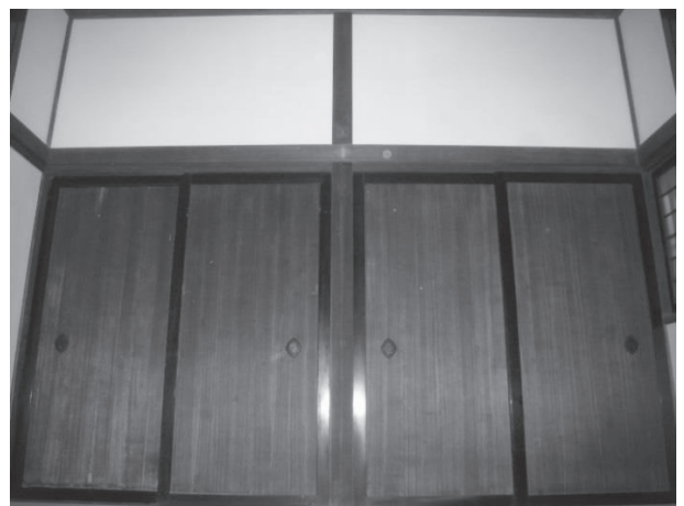
・復原された式台玄関取次：左側板戸は洋間西入側へ、右側板戸は洋間に通じる。但し、洋間側板戸は開閉不可能で、裏に耐震壁あり。
