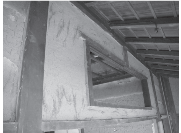
・「離れ」2階小壁開口廻り：全面に伏せ藁を用いて塗り伏せる斑直し塗り。中塗り下地。
