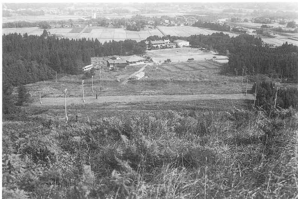
近景（南西から）
