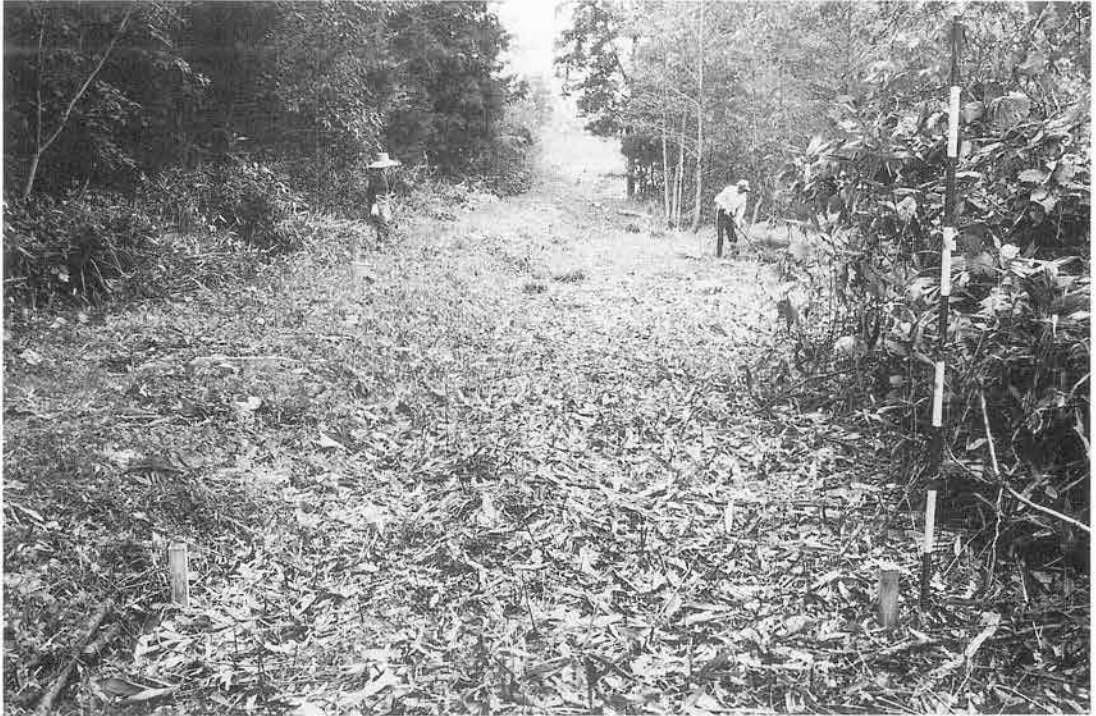
1. D1～E1 区域調査前の状態（導水管管理設区域）
