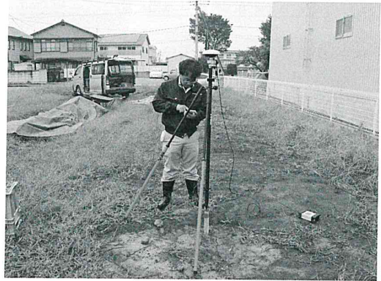
基準点設置状況 (南から)
