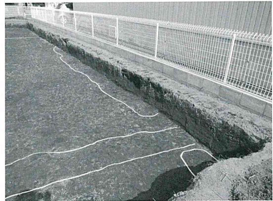
3号畦畔検出状況 (南西から)
