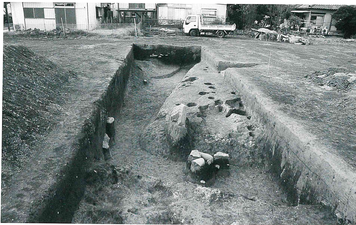
SD - 2号溝 (東から)
