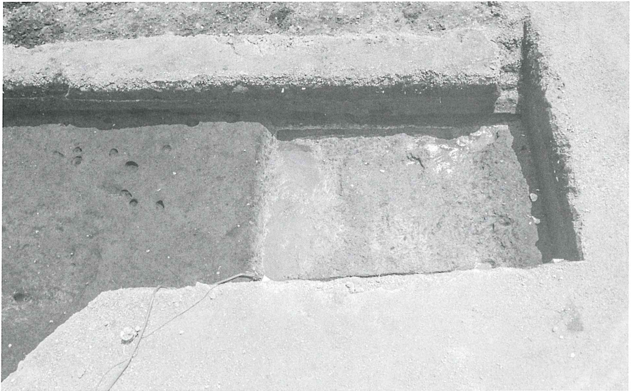
SZ01 南西部全景 (空撮、北から)
