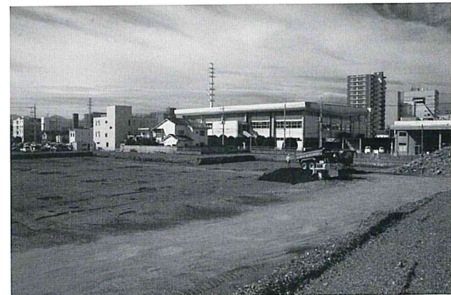
重機による埋め立て作業風景（北東）
