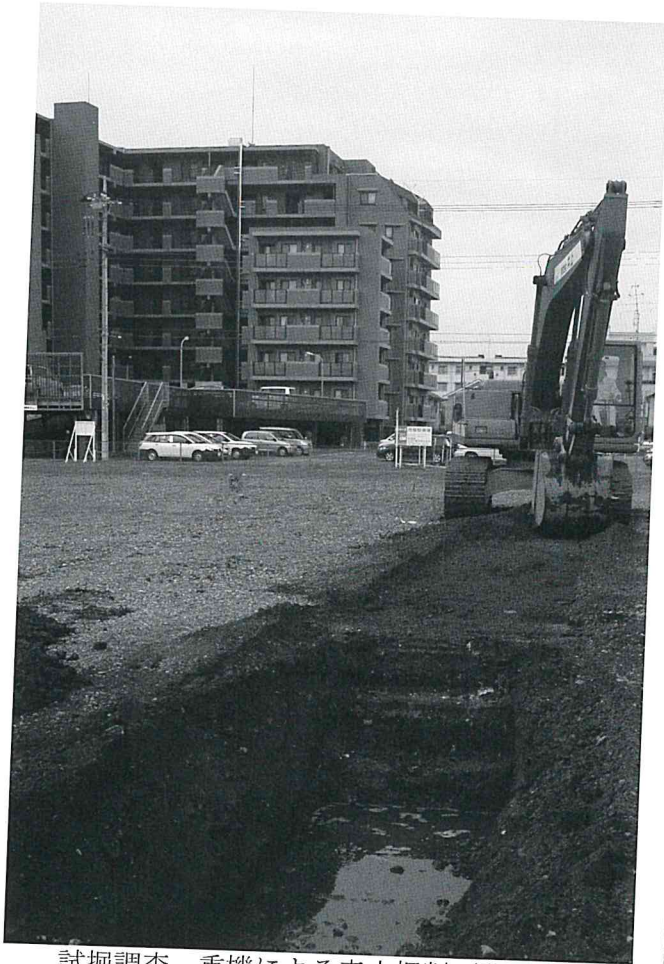
試掘調査 重機による表土掘削（北から）
