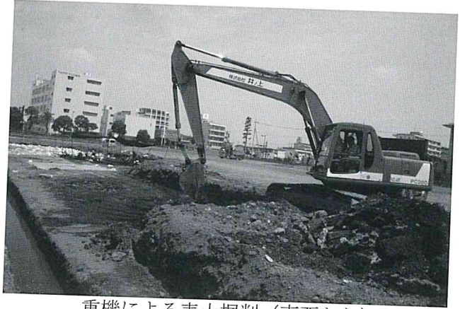
重機による表土掘削（南西から）
