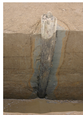
12 第16号建物跡 基礎杭(2)
