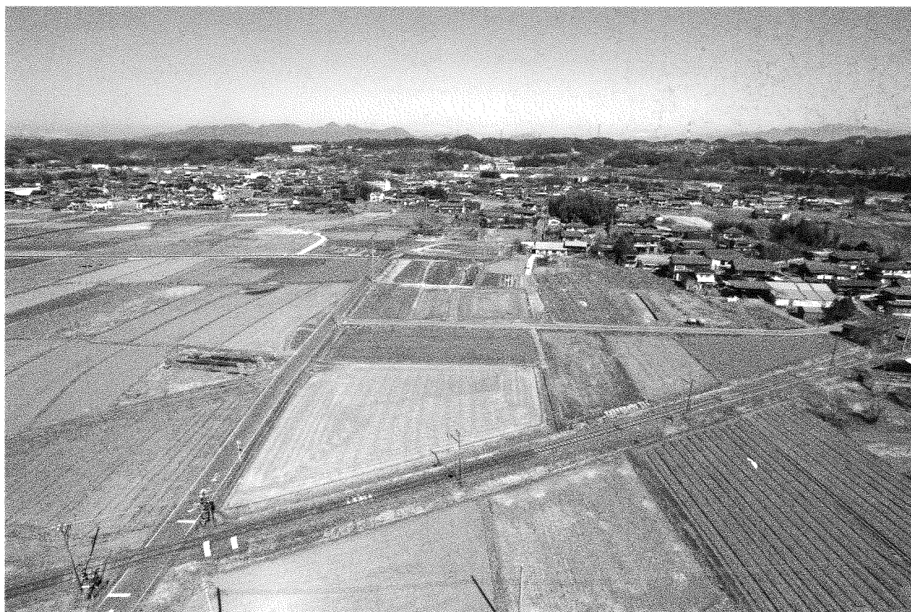
平成24年度(第2次)空中写真 多胡郡正倉跡 遠景 南から
