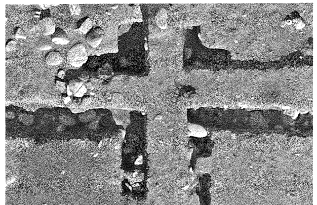
SB03 C8 柱筋交点 オルソ画像 上が北
