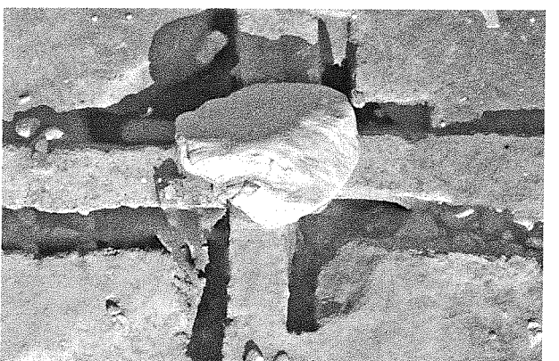
SB03 B6 柱筋交点 オルソ画像 上が北
