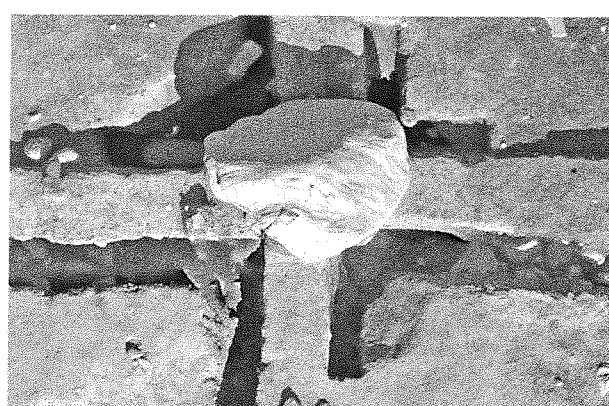
SB03 B6 柱筋交点 オルソ画像 上が北
