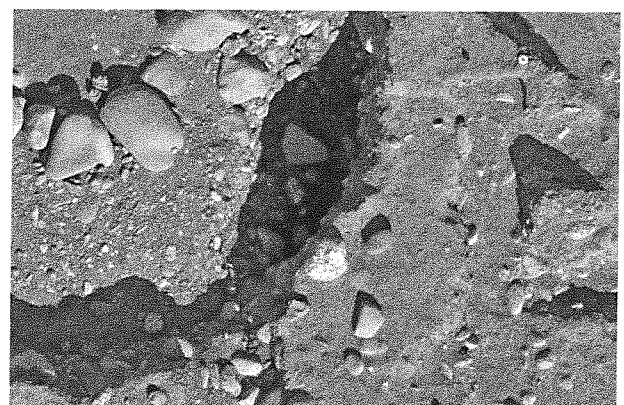
SB03 D6 柱筋交点 オルソ画像 上が北
