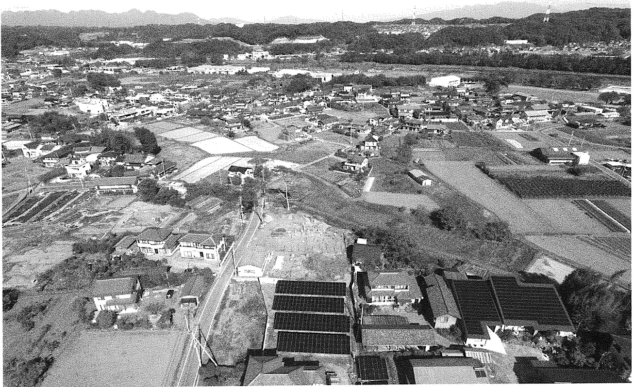
SB03 遠景 南から
