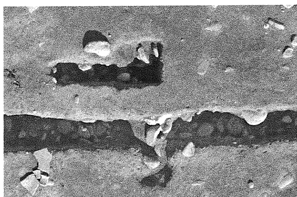
SB03 C7 柱筋交点 オルソ画像 上が北
