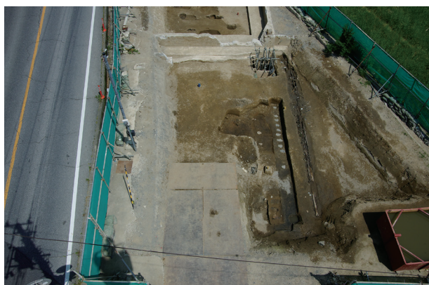
5 第一面 D 区全景
