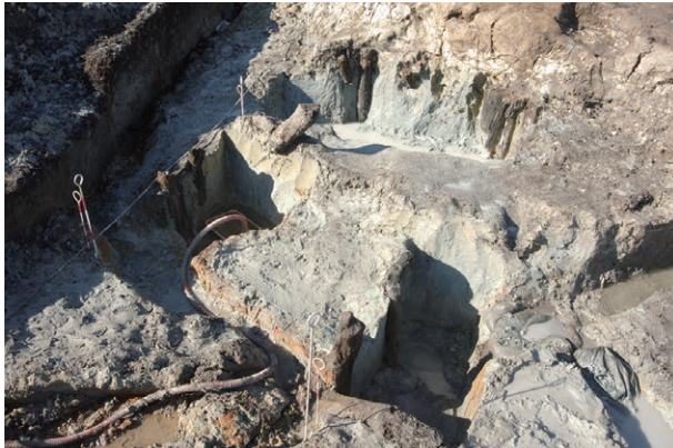
1 第5号木組遺構内部杭群と南部杭群
