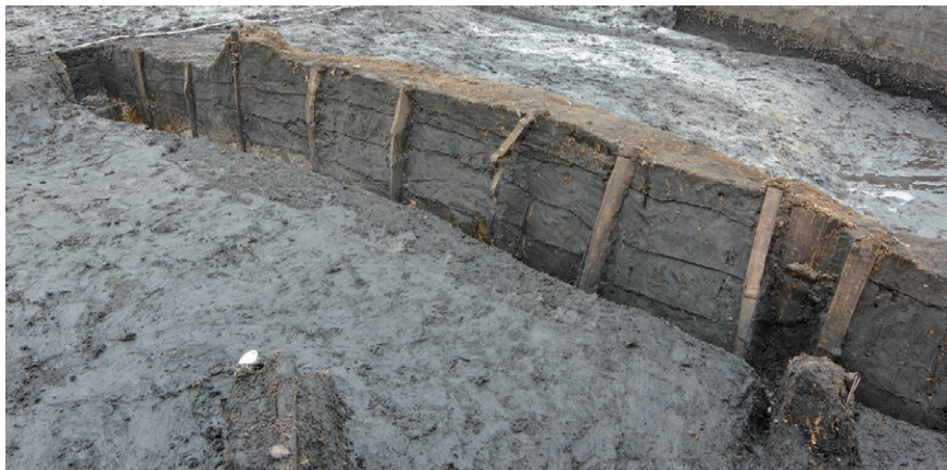
1 杭打設状況① (杭 1 ~ 9)
