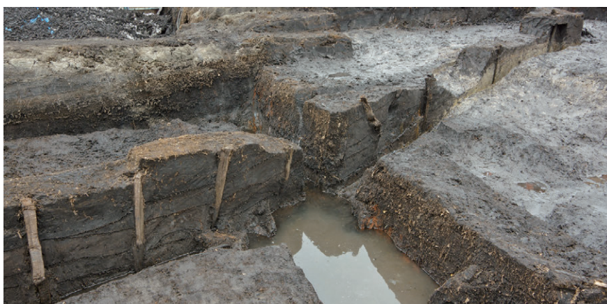
4 杭打設状況④ (杭 16 ~ 24)
