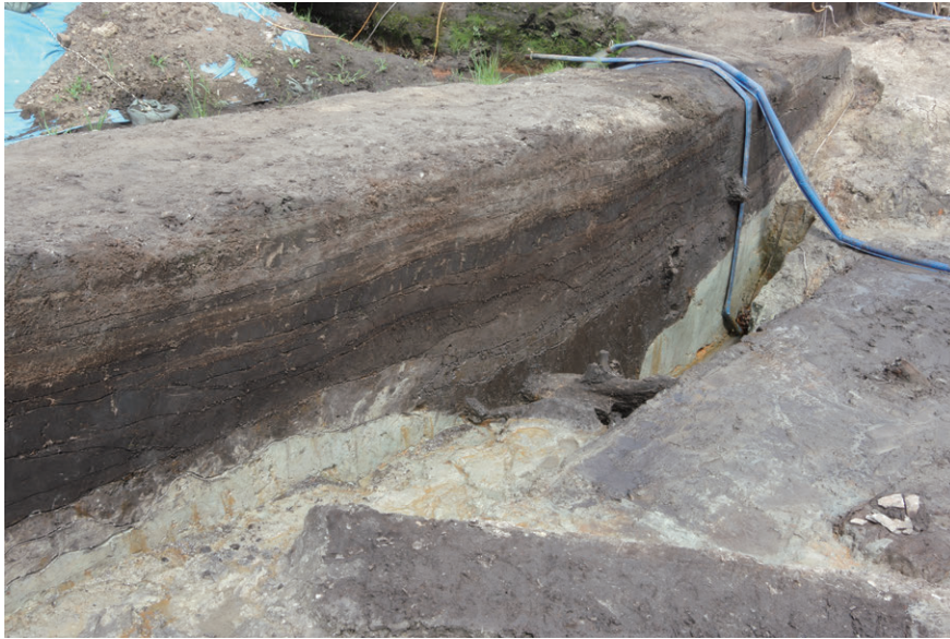
1 開削部A断面（1） ※右岸は階段状掘り込み
