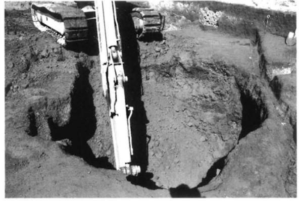
2. 145号土坑 重機による発掘風景
