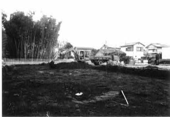
2. 表土剥ぎ風景
