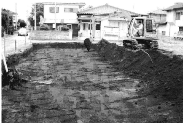
3. 表土剥ぎ風景
