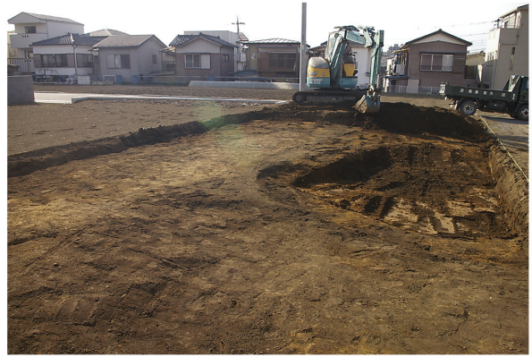
2. 表土剥ぎ風景
