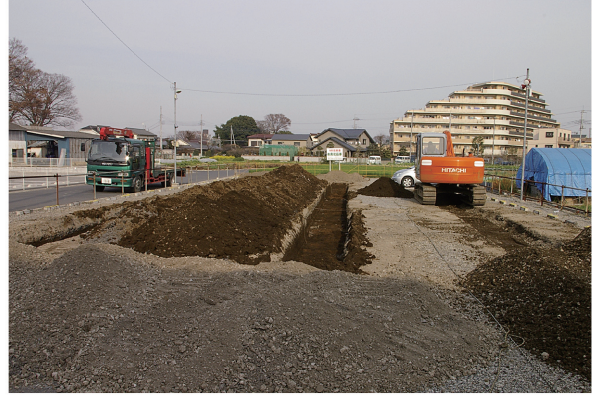
2. 確認調査風景
