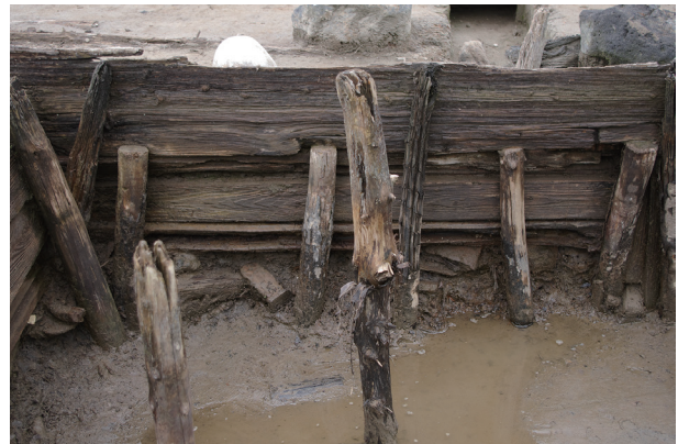
6 第3号池跡南側壁面 (2)
