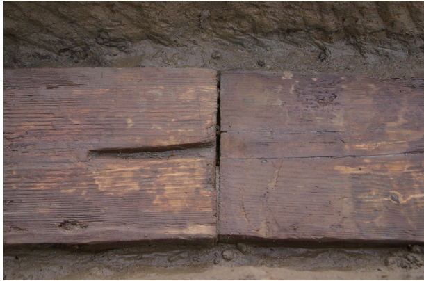
1 第1号建物跡 捨土台接合部
