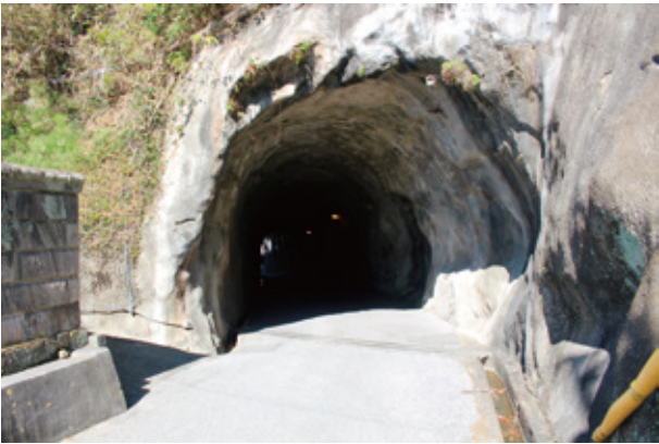
【木出】逢島隧道
