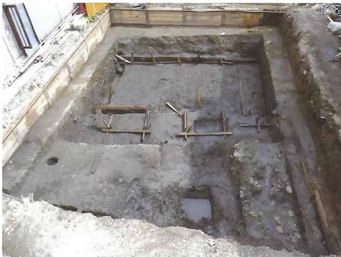
写真1 発見された若宮大路側溝(溝幅は約3m)
