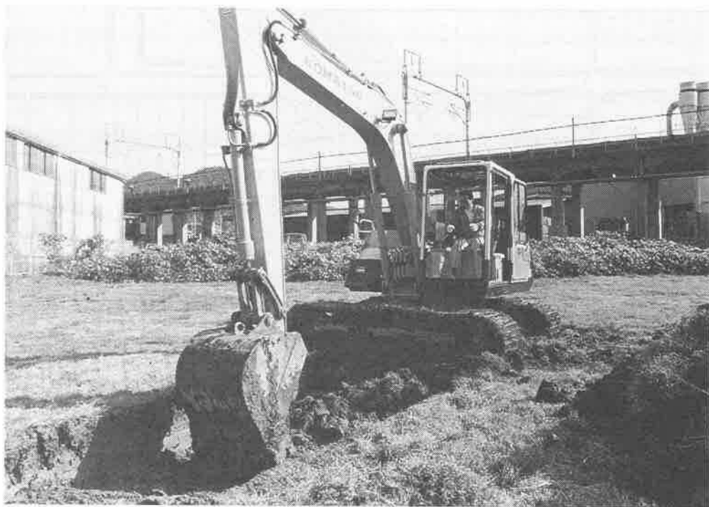
写真1 重機による表土掘削
